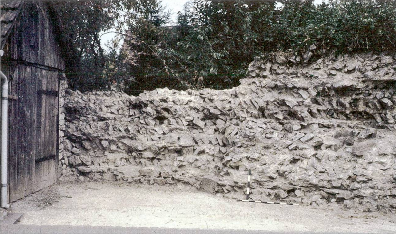
Abb. 56: Kaiseraugst AG, Sanierung Geräteschuppen Heidemurweg (Baubegleitung 2016. 008). Situation bei der Freilegung im Jahr 1985. Die Schräglagen im Mauer Kern sind deutlich erkennbar. Blick von Süden.
