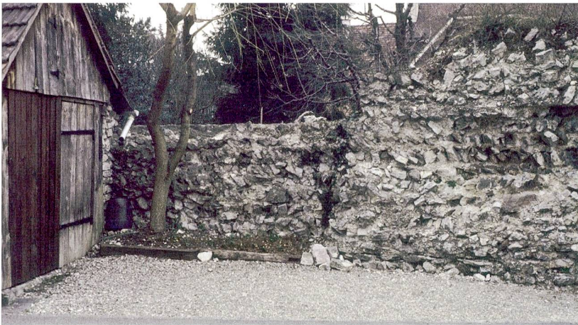
Abb. 57: Kaiseraugst AG, Sanierung Geräteschuppen Heidemurweg (Baubegleitung 2016. 008). Situation im Jahr 1994. Einige lose Steine des Mauer kerns liegen am Mauerfuss. Blick von Süden.
