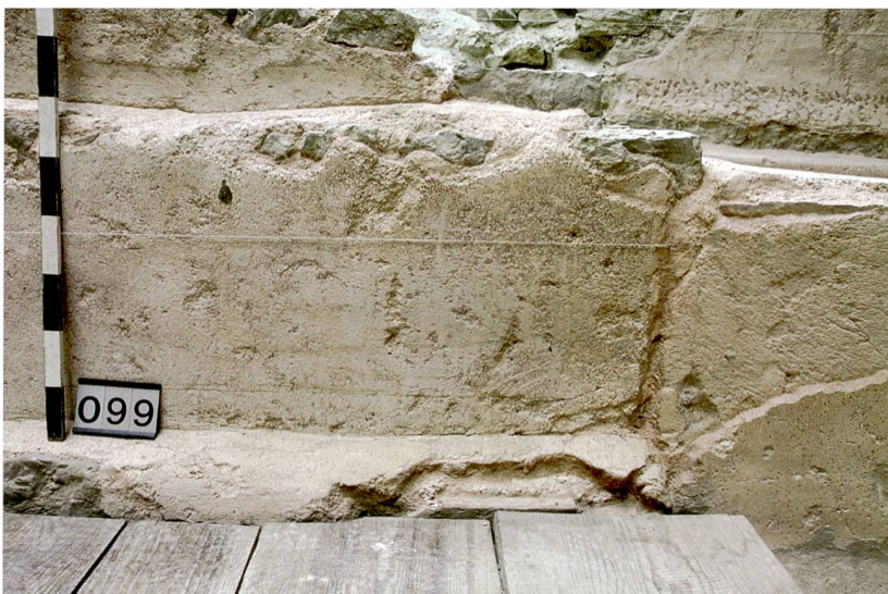
Abb. 43: Kaiseraugst AG, Nachuntersuchungen Schmidmatt (Dokumentation 2016.005). Haus 2, Raum 10: Detail von Mauer MR 28 und des Übergangs zu Mauer MR 74. Blick von Westen.
