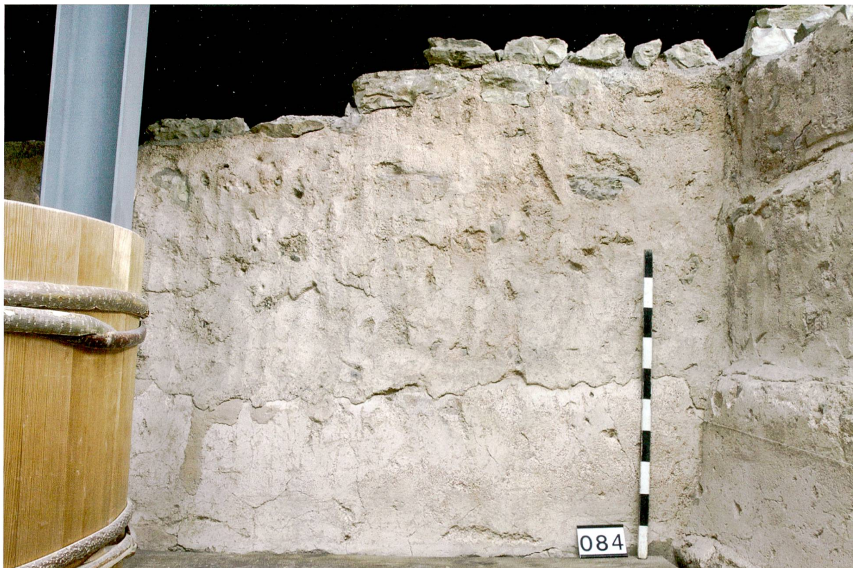
Abb. 38: Kaiseraugst AG, Nachuntersuchungen Schmidmatt (Dokumentation 2016.005). Haus 2, Raum 10: Detail von Mauer MR 27 mit Endverputz (unten), darin Flickstellen (links) und darüberliegender Grobverputz (oben). Blick von Süden.
