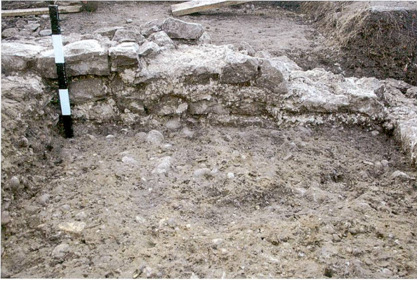
Abb. 77. Augst BL, EFH Sichelstrasse (Grabung 2016.065). Mauer MR 2 mit Mörtelquellungen. Diese Seite der Mauer wurde direkt gegen das Erdreich gemauert. Blick von Westen.
