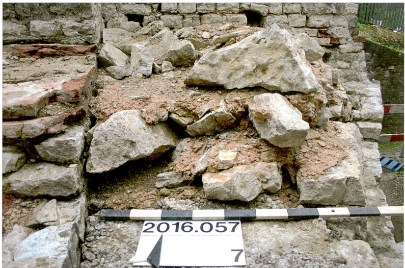
Abb. 56: Augst BL, Stützmauern Basilica (Intervention 2016.057). Nordwestliche Kanalwange MR 28 der Kloake. Auf der Kämpferlinie (rechts im Bild) liegen einige leicht abgeschrägte Kalksteine des Widerlagers zum Bogen. Darüber finden sich grössere, stärker abgeschrägte Kalksteine, die als Widerlager für einen zweiten Bogen dienten. Blick von Süden.
