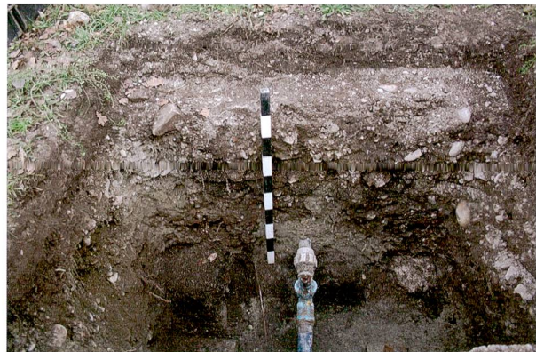
Abb. 4: Augst BL, Forum Schieber (Baubegleitung 2016.053). Nordöstliche Grabenwand mit der aktiven Wasserleitung. Auf der Grubensohle sind beidseits der Leitung intakte Kulturschichten vorhanden. Blick von Südwesten.
