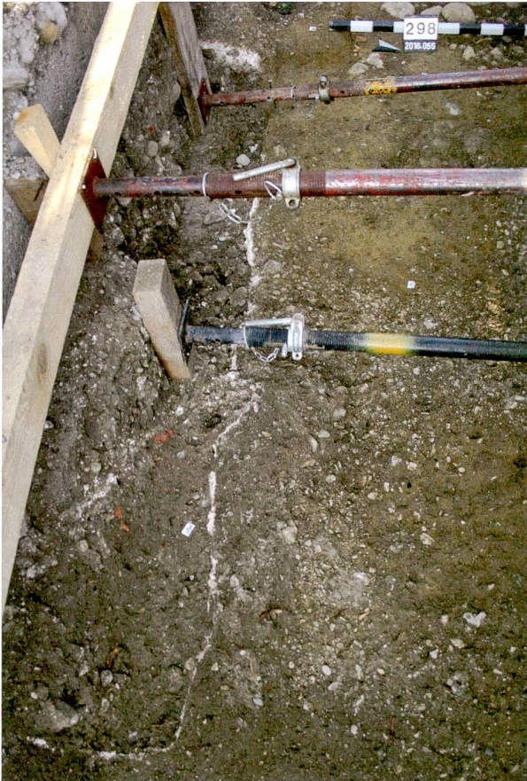
Abb. 47: Augst BL, Rheinstrasse (Grabung 2016.055). Eine neuzeitliche Kalksumpfgrube zeichnet sich durch eine weisse Kalkschicht am Rand der Struktur ab. Die Grube wurde auf der Grabung 1962.055 «Rheinstrasse» bereits einmal angeschnitten, im Osten der Grube, am oberen Bildrand.
