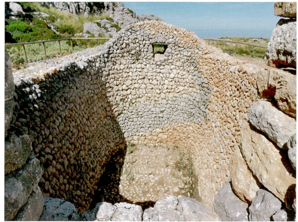
Abb. 15: (Früh-)nezeitliche und moderne Baubefunde, die nachweislich zur Bevorratung von Schnee und Eis dienen. Blick in eine frühnezeitliche casa de neu an der Nordwestflanke der Puig d'En Galileu (Mallorca, E).
