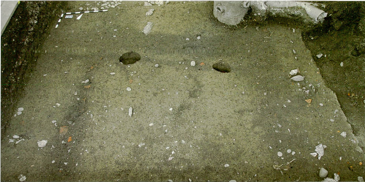
Abb. 33: Kaiseraugst AG, MFH Heidemurweg 28 (Grabung 2015.003). Spuren von Holzbauten in Baugrube B: Die breiten Gräbchen (MR 25 und MR 26) entsprechen dem zweiten Holzbauzustand, die schmalen (MR 22–MR 24) dem dritten Holzbauzustand. Die Pfostengruben gehören zum vierten Holzbauzustand. Blick von Süden.
