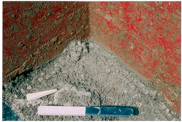
Abb. 13: Kaiseraugst AG, Baugrube Dorfstrasse 29 (Baubegleitung 2015.002). Häufchen von Tesserae in der Raumecke MR 72/MR 73, die auf dem hier lokal intakten Mosaik liegen. Blick von Südosten.
