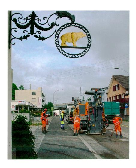
Abb. 83: Augst BL, Hauptstrasse Belagserneuerung (Grabung 2015.061). Der Belag auf der nördlichen Fahrbahn ist abgefräst (rechts), die südliche Fahrbahn weist bereits den neuen Belag auf (links). Von Osten.
