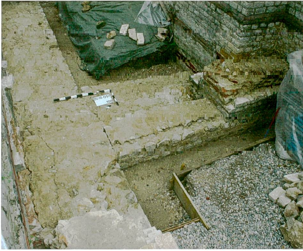
Abb. 54: Augst BL, Basilica-Stützmauern (Grabung 2015.057). Nach dem Entfernen aller Restaurierungsmaßnahmen von 1941 liegen die originalen Oberflächen der Mauern MR 8 (links), MR 12 (Stützpfiler auf MR 8), MR 13 (beim Fotojalon), MR 15 (vordere, quer verlaufende Mauer) und MR 16, ein an die massive Eckverstärkung MR 17 der Basilica-Stützmauer (rechts oben im Bild) angeklebter, ehemals wohl hochgeführter Mauerrest frei. Die Fuge zwischen MR 8 und MR 15 ist deutlich zu sehen. Von Südwesten.
