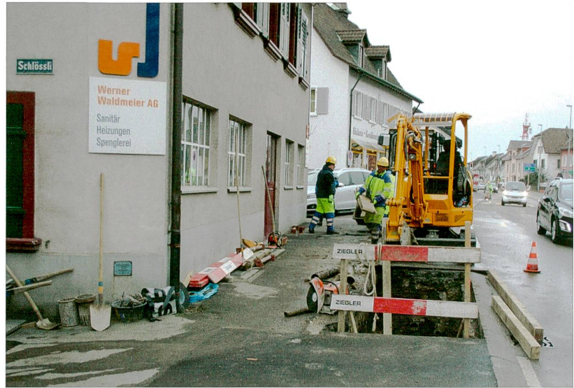
Abb. 12: Augst BL, Wasserleitung Hauptstrasse (Grabung 2015.052). Wiederaufnahme der Aushubarbeiten im Anschluss an die erste Etappe von 2014. Von Osten.
