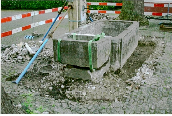
Abb. 70: Augst BL, Ehingerhof (Grabung 2015.059). Die schadhafte Pflästerung rund um den Brunnen ist entfernt. Von Westen.
