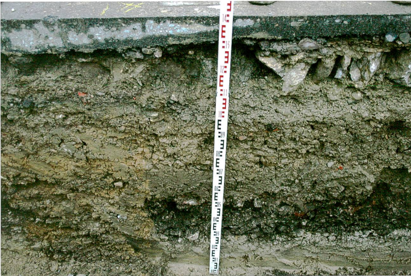
Abb. 19: Augst BL, Wasserleitung Hauptstrasse (Grabung 2015.052). Im Westteil des Leitungsgrabens konnte unmittelbar anschliessend an den Bereich, der in Abbildung 14 dokumentiert ist, eine sehr dunkle Schicht beobachtet werden, die von Norden in den Graben hineinläuft (Abb. 11,3). Es handelt sich um ausplamiertes Material des Nordwestgräberfelds. Diese Schicht liegt teilweise über den Gräbern, teilweise dazwischen.
