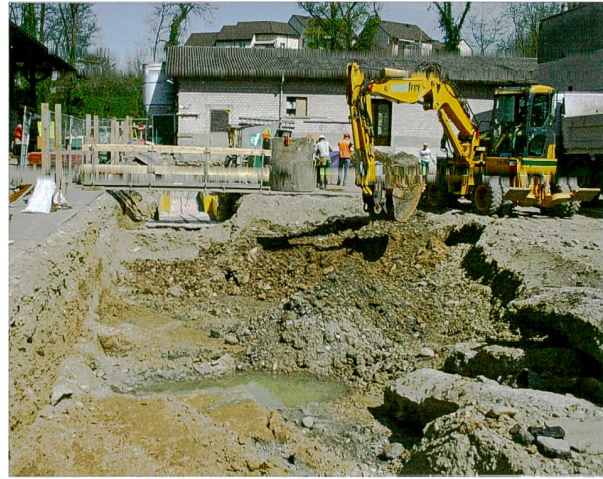
Abb. 35: Augst BL, Werkhof E. Frey AG (Grabung 2015.054). Grossflächige Aushubarbeiten im Mittelteil der geplanten Werkhalle. Das abgebaute Material stammt von Planierungen im Zusammenhang mit dem Ausbau des Werkplatzes. Von Südwesten.
