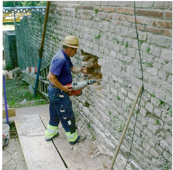
Abb. 59: Augst BL, Basilica-Stützmauern (Grabung 2015.057). Im deutlich als 1941 wieder aufgebaut erkennbaren Teilstück von MR 14 wird eine Mauer-sondierung herausgebrochen. Damit sollte erstens abgeklärt werden, ob sich hinter der rechts zu sehenden Mauerschale noch Aufgehendes aus römischer Zeit verbirgt und zweitens, ob MR 14 tatsächlich auf die Nordkante von MR 8 gesetzt war, wie Befundbeobachtungen an der Innenseite nahelegten. Es erwies sich, dass MR 8 und MR 14 eine bauliche Einheit bilden (siehe Abb. 60). Von Südwesten.
