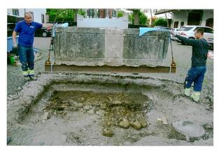
Abb. 71: Augst BL, Ehingerhof (Grabung 2015.059). Das aus Beton gegossene Brunnenbecken wird weggehoben, damit die Fundamentierung erneuert werden kann. Das bestehende Fundament erwies sich eher als Gebastel, wie das Bild zeigt. Es war mit der Möglichkeit gerechnet worden, dass dafür allenfalls Spolien aus römischer Zeit verwendet worden seien, weshalb die Arbeiten begleitet wurden. Von Süden.
