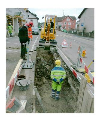
Abb. 13: Augst BL, Wasserleitung Hauptstrasse (Grabung 2015.052). Aushubüberwachung zwischen bereits gespriessten Stellen (vorne) und dem arbeitenden Bagger (hinten). Wie hier brach an vielen Stellen das seitliche Erdreich oft ein, sodass die von der Baufirma vorgenommene rasche Spriessung der Grabenwände verständlich ist. Von Osten.
