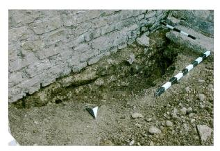
Abb. 58: Augst BL, Basilica-Stützmauern (Grabung 2015.057). Nach dem Aushub in Feld 14 liegt das Fundament der Stützmauer MR 21 frei. Es besteht aus recht grossen, unregelmässigen Kalksteinen. Rechts oben Stützpfeiler MR 24, der 1941 mit einer Betonplatte unterfangen wurde, wie unter dem kurzen Fotojalon zu sehen ist. Von Norden.
