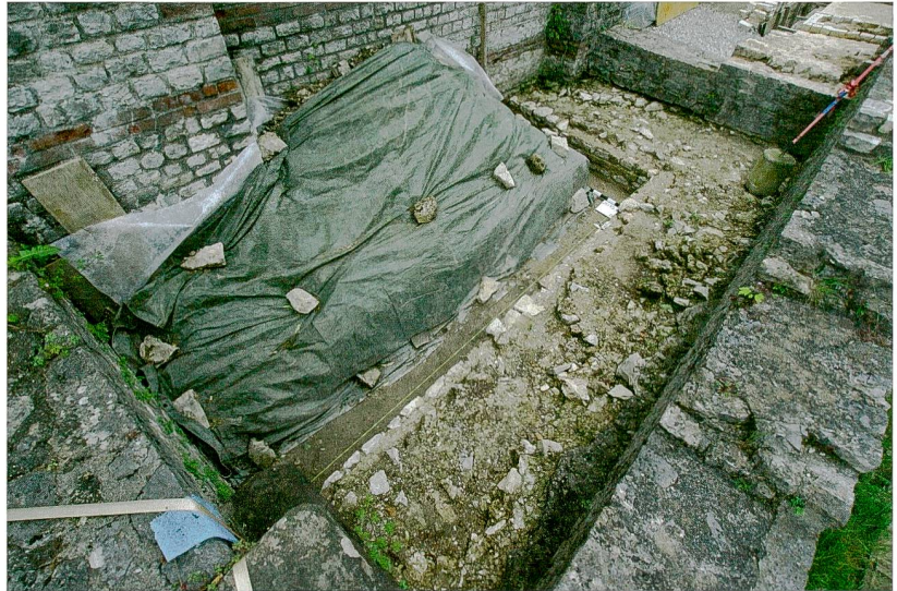
Abb. 51: Augst BL, Basilica-Stützmauern (Grabung 2015.057). Die Mauern MR 8 (vorne) und MR 13 in Feld 12 nach dem Abbau der 1941 aufgesetzten Mauerkrone. Ganz rechts die hochgeführte Mauer MR 14. Von Norden.
