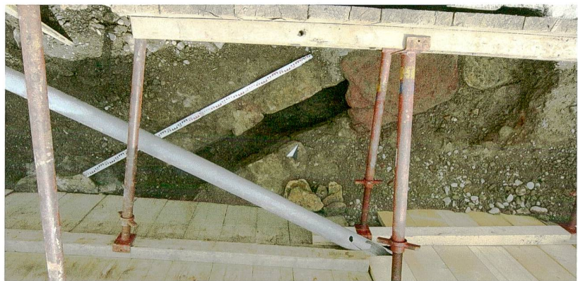
Abb. 12: Augst BL, Wasserleitung Hauptstrasse (Grabung 2014.052). Neuzeitlicher Abwasserkanal. Aufsicht. Das Gefälle verläuft von links unten nach rechts oben.
