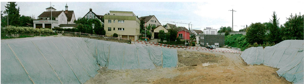
Abb. 30: Augst BL, Hausmatt (Grabung 2014.053). Die fertig ausgehobene Baugrube mit Umgebung. Ganz links das Augster Gemeindehaus, ganz rechts der Bahndamm der SBB. Rechts der Mitte die seit 2010 entstandenen Gebäude im Areal der Ausgrabung 2010.053, beim Bau des Wohnblocks links der Mitte kamen 1974 ebenfalls römische Bauzeugnisse zutage. Das rot gestrichene Haus steht über einer Grabung, die 1998 stattfand. Die Absperrungen markieren den Verlauf des Hausmattwegs. Von Westen.
