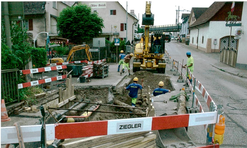
Abb. 16: Augst BL, Wasserleitung Hauptstrasse (Grabung 2014.052). Aushubarbeiten unmittelbar westlich der Ergolzbrücke. Von Osten.
