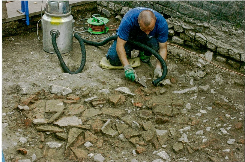
Abb. 56: Augst BL, Stützmauern Basilica (Grabung 2014.057). Freipräparieren einer Schicht mit verstärkten Dachziegeln in Feld 7. Von Südwesten.
