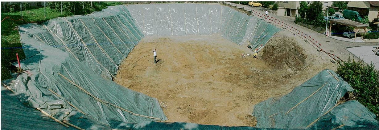
Abb. 29: Augst BL, Hausmatt (Grabung 2014.053). Die fertig ausgehobene Baugrube. Rechts das vergleichsweise kleine, archäologisch interessante Areal, ganz rechts der Hausmattweg. Die Aushubtiefe bezogen auf das einst vorhandene Terrain beträgt bis zu sieben Meter. Von Südosten.
