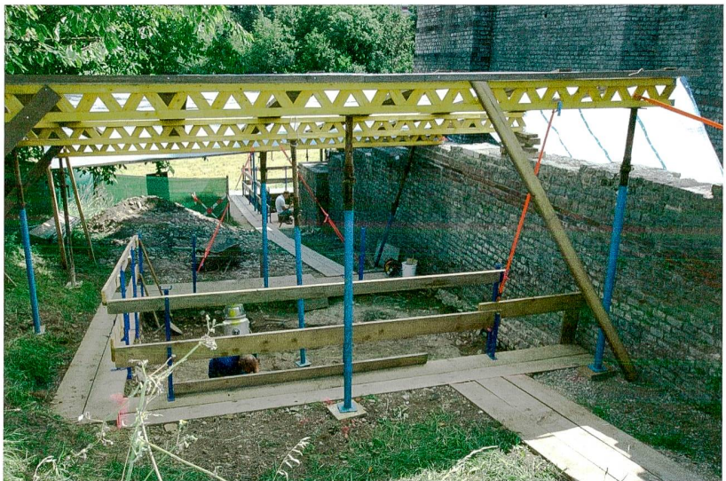
Abb. 51: Augst BL, Stützmauern Basilica (Grabung 2014.057). Feld 7 mit den Einrichtungen für Besucherinnen und Besucher (Bretterstege, stabile Abschränkungen) und dem fest montierten Regendach. Von Südwesten.
