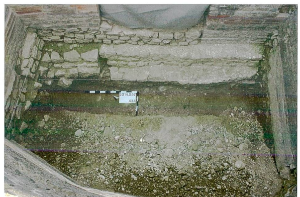
Abb. 52: Augst BL, Stützmauern Basilica (Grabung 2014.057). Raum 3 nach der vollständigen Ausräumung der modernen Sedimente im Nordteil. Die freigelegte Oberfläche entspricht dem anstehenden Kies. Oben das mehrphasige Mauerwerk an der Nordseite: links MR 8, darüber MR 32, in der Mitte ein Fundament für MR 7 (ehemals ein Durchgang mit massiver Sandsteinschwelle), rechts MR 25. Von oben, gegen Norden.
