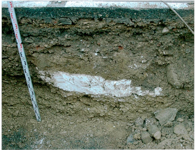
Abb. 23: Augst BL, Wasserleitung Hauptstrasse (Grabung 2014.052). Angeschnittene Kalksumpfgarbe im Südprofil des Leitungsgrabens (vgl. Abb. 10,6; 18,6). Von Norden.
