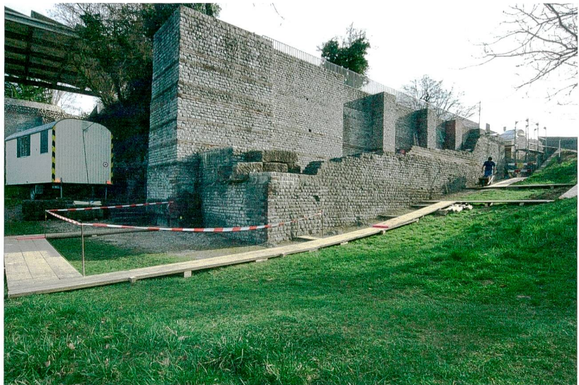
Abb. 50: Augst BL, Stützmauern Basilica (Grabung 2014.057). Mit Bretterstegen für Besucherinnen und Besucher zugänglich gemachte Felder 7 (rechts oben) und 8 (links unten). Von Norden.
