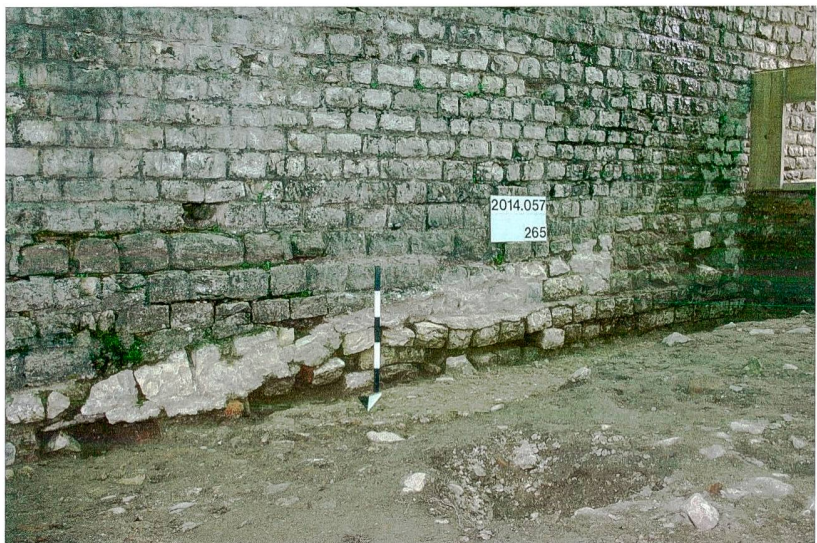
Abb. 57: Augst BL, Stützmauern Basilica (Grabung 2014.057). Ostrand von Feld 7 mit freigelegten Originalquadern von MR 14 (Aussenseite). Das gesamte Mauerwerk darüber wurde 1941/42 ausgeführt. Von Norden.
