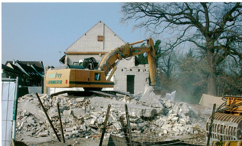
Abb. 3: Augst BL, Umbau Hauptstrasse 15 (Grabung 2014.051). Abbruch des Scheunenteils. Links im Bild die Häuser entlang der Südseite der Hauptstrasse. Von Osten.
