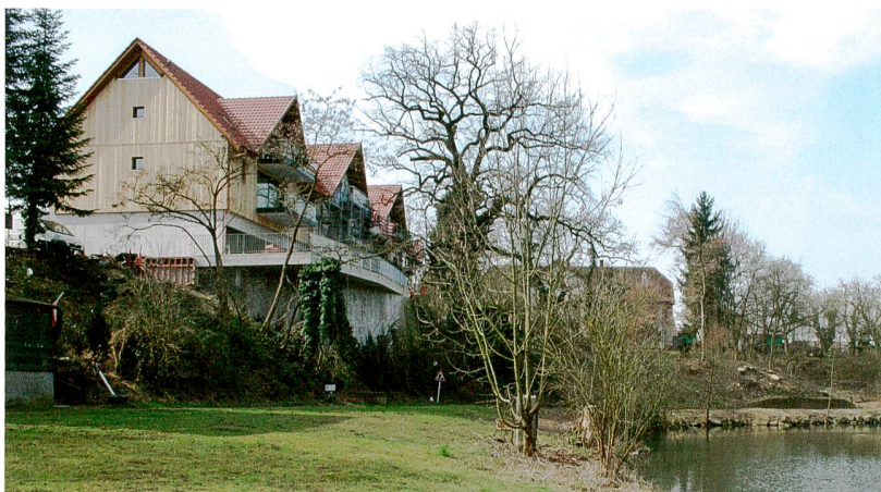
Abb. 8: Augst BL, Umbau Hauptstrasse 15 (Grabung 2014.051). Das Gelände zwischen den postulierten römerzeitlichen Häusern (oben links im Bereich des Neubaus) und dem Lauf der Ergolz. Der Brunnen (siehe Abbildung 9) befindet sich unmittelbar am Fuss des Steilhangs unter der überkragenden Terrasse. Aufnahme vom 18.03.2015. Von Osten.
