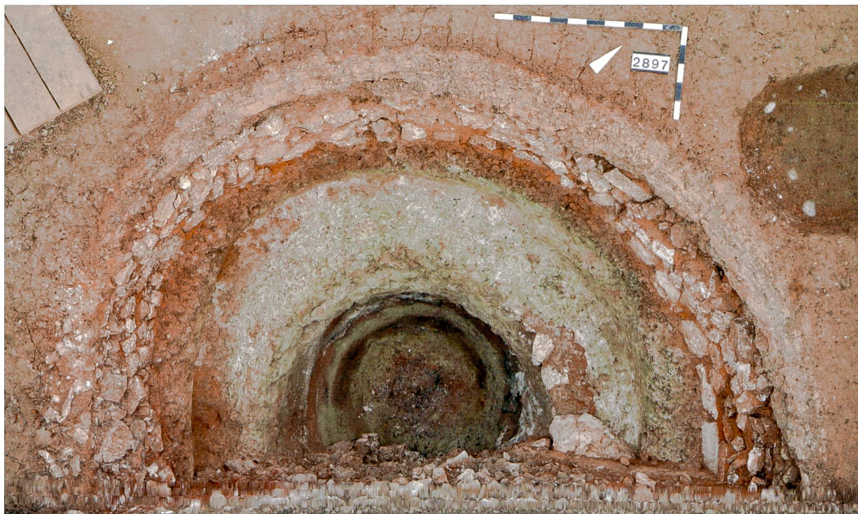
Abb. 5: Kaiseraugst AG, Auf der Wacht (Grabung 2013.001). Aufsicht von Südosten auf den vollständig geleerten Kalkbrennofen (Ofen 6). Die drei Schalungen (verzierter Lehmstrich, Kalksteine mit Lehmfugen, verschlackter Lehmstrich) der Kalkkammer sind hier gut über der grünlichen Ofenbank sichtbar. Auf Letzterer liegt noch ein grosser kalzinierter Kalkstein, der als Anfängerstein des Himmels diente. Die rötliche Stelle in der Ofenbank deutet ihrerseits auf einen Flick. Die Feuerkammer ist muldenförmig in den anstehenden Hochflutsand eingetieft.
