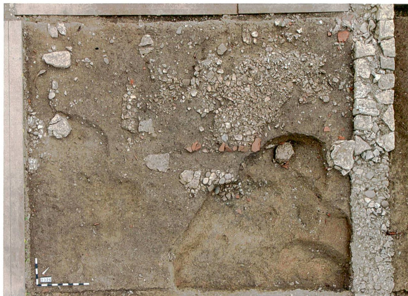
Abb. 23: Kaiseraugst AG, Auf der Wacht (Grabung 2013.001). Südteil des an MR 3 (rechts) stehenden Anbaus. Die Mauern ruhen auf flach liegenden Kalksteinen. Der Kiesboden ist deutlich sichtbar. Gegen das Balkennegativ von MR 93 (mittig) liegen Ziegelfragmente der grösstenteils abgebauten Feuerstelle 23. Blick von Südosten.
