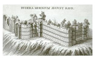
Abb. 19: Augst BL, Stützmauern Basilica (Grabung 2013.057). Die erste bekannte Darstellung der Situation an der Nordwestecke des Forums, publiziert von Johann Daniel Schöpflin im Jahre 1751. Das aktuelle Grabungsareal liegt rechts im Bild, links ist die Curia dargestellt, damals als Wehrturm interpretiert. Die Ziegeldurchschussbänder sind klar hervorgehoben. Von Norden.
