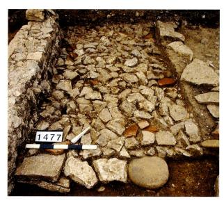
Abb. 19: Kaiseraugst AG, Auf der Wacht (Grabung 2012.001). Unterbau des Mörtelgussbodens aus Kalksteinen und einigen Ziegelfragmenten. Blick von Südosten.
