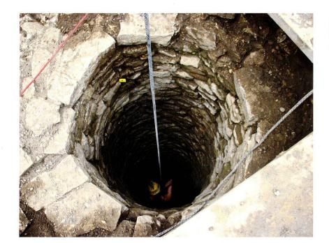
Abb. 40: Kaiseraugst AG, Auf der Wacht (Grabung 2012.001). Der obere Teil von Sodbrunnen MR 12 ist regelmässig rund und trocken gemauert. Blick von Osten.
