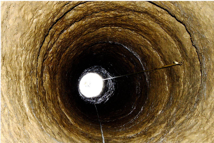
Abb. 41: Kaiseraugst AG, Auf der Wacht (Grabung 2012.001). Der untere Teil von Sodbrunnen MR 12 ist in den anstehenden Fels gehauen. Blick von unten.
