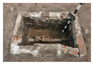
Abb. 12: Augst BL, Hausmatt (Grabung 2010.053). Wartungsschacht der gusseisernen Wasserleitung mit abhebbarem, verkeiltem Deckel (links) und Schieber (rechts) in Feld 6. Von Nordwesten.
