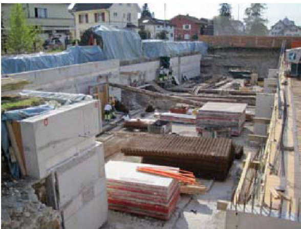
Abb. 73: Kaiseraugst AG, südliche Kastellmauer. Übersicht über die Baugrube für eine Tiefgarage (mitten im Castrum Rauracense!). Blick nach Südwesten. Oben: Zum Schutz der Kastellmauerfundamente deckten wir diese während der Bauarbeiten mit Plastikplanen ab. – Mitte: Die antiken Fundamente wurden in Richtung Baugrube angeböscht, damit sie nicht abzurutschen drohten. – Unten: Die Tiefgarage im Bau. Die Konservierungsarbeiten an der spätantiken Kastellmauer erfolgten teils vorgängig (Abb. 75), teils aber erst 2011 in Zusammenhang mit der Umgebungsgestaltung.
