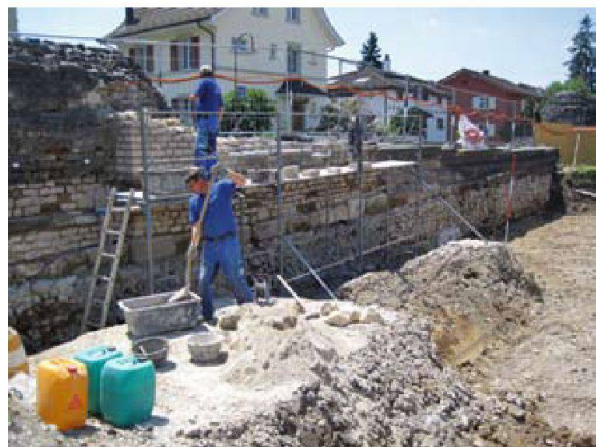
Abb. 74: Kaiseraugst AG, südliche Kastellmauer. Zwei instabile Stellen wurden, zur Sicherheit gegen weiteren Zerfall und Einsturz, mit einem in Beton gegossenen Streifenfundament und Zementbacksteinen unterfangen.
