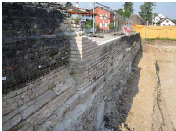
Abb. 75: Kaiseraugst AG, Kastellmauer. Um die Sicherheit während der Bauarbeiten an der Tiefgarage zu gewährleisten, wurde entschieden, diverse lose Mauersteine und eine gefährlich gewordene herausragende Ecke der Kastellmauer zu entfernen und neu aufzumauern.
