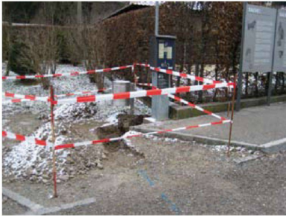
Abb. 83: Augst BL. Elektro-Leitungsgraben (für die Parkuhr), eingetieft in die moderne Aufschüttung des Besucherparkplatzes gegenüber dem Römerhaus in Augst.
