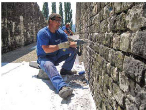
Abb. 77: Augst BL, Theater. Auch im Nordost-Vomitorium mussten wieder durch Frost zerstörte Mauerteile nachsaniert werden. Mladen Puklin und Ismet Muhadini ergänzen defekt gewordene Partien mit frostfesten Steinen und Kalkmörtel.
