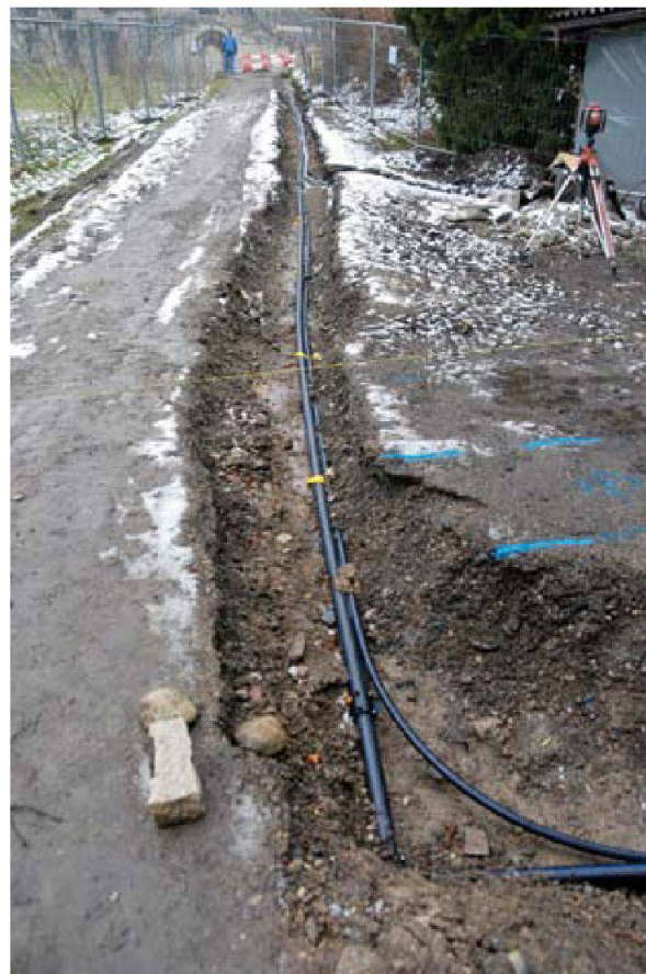
Abb. 82: Augst BL, Nordfuss des Schönbühls. Trotz archäologischer Bedenken bezüglich eines weiteren Bodeneingriffs liessen wir die Frisch- und die Abwasserleitungen von der Brotbackstube resp. einem neuen Pumpensumpf (Abb. 81) in die Sichelstrasse (im Hintergrund) verlegen – vom Ausgrabungsteam dokumentarisch begleitet.
