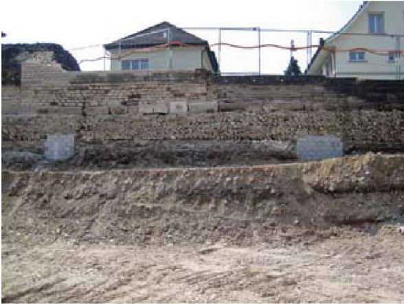
Abb. 74: Kaiseraugst AG, südliche Kastellmauer. Zwei instabile Stellen wurden, zur Sicherheit gegen weiteren Zerfall und Einsturz, mit einem in Beton gegossenen Streifenfundament und Zementbacksteinen unterfangen.
