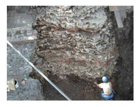
■ Abb. 94: Augst, Augusta Raurica. Bei der Reinigung des Stützpfeilers, hier durch Mladen Puklin, wurde der originale Ziegeldurchschuss deutlich sichtbar (zwei horizontale rote Bänder über resp. unter der Bildmitte). Diese Ziegelbänder gehören zum jüngeren, angebauten Teil des Stützpfeilers und wurden bei den Restaurierungsarbeiten sichtbar belassen.
