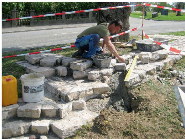
Abb. 105: Augst, Augusta Raurica, Theater. Die bei der Gesamtsanierung des Theaters vor einigen Jahren noch verschonten Wurzeln mussten nun doch entfernt und die Fehlstellen der Bodenmarkierung mit Steinen und Mörtel ergänzt werden (im Bild: Remo Plattner, Firma Markus Fux AG).
