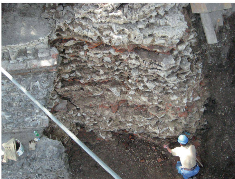
◀ Abb. 94: Augst, Augusta Raurica. Bei der Reinigung des Stützpfilers, hier durch Mladen Puklin, wurde der originale Ziegeldurchschuss deutlich sichtbar (zwei horizontale rote Bänder über resp. unter der Bildmitte). Diese Ziegelbänder gehören zum jüngeren, angebauten Teil des Stützpfilers und wurden bei den Restaurierungsarbeiten sichtbar belassen.
