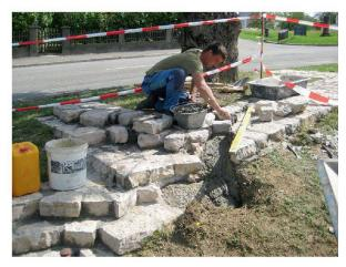
Abb. 105: Augst, Augusta Raurica, Theater. Die bei der Gesamtsanierung des Theaters vor einigen Jahren noch verschonten Wurzeln mussten nun doch entfernt und die Fehlstellen der Bodenmarkierung mit Steinen und Mörtel ergänzt werden (im Bild: Remo Plattner, Firma Markus Fux AG).
