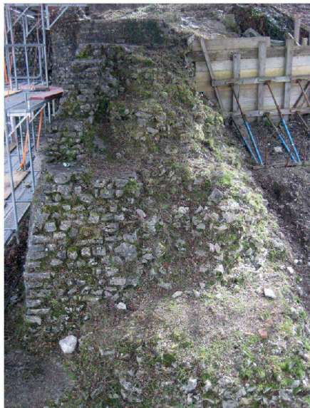
Abb. 68: Augst, Augusta Raurica, Nordhang Schönbühl (Grabung 2009.052). Die erste Grobreinigung am originalen antiken Mauerkern des Stützpfilers durch das Restaurierungsteam. Steine und Mörtel an der während Jahrzehnten der Witterung ausgesetzten Oberfläche des Mauerkerns sind so instabil geworden, dass sie von Hand entfernt werden können. Die losen, nicht sicher antiken Kalksteine müssen zur Vorbereitung der Reinigung und Dokumentation (Abb. 69) noch entfernt werden.
