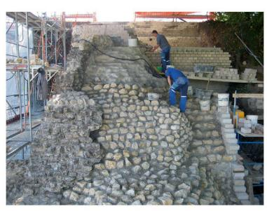
Abb. 10: Augst, Augusta Raurica, Nordhang Schönbühl. Die erste Schicht frostfester Kalkbruchsteine, sogenannter «Schroppen», wird von Dominik Fux und Mladen Puklin zugerichtet und als künftige «Schutz- und Verschleissschicht» vermauert.
