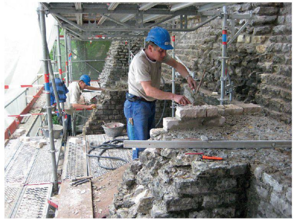
Abb. 91: Augst, Augusta Raurica, Nordhang Schönbühl. Die Stützmauer mit ihren Entlastungspfйлern oberhalb der Brotbackstube wird von Dominik Fux und Mladen Puklin dort, wo nötig, etwas aufgemauert.
