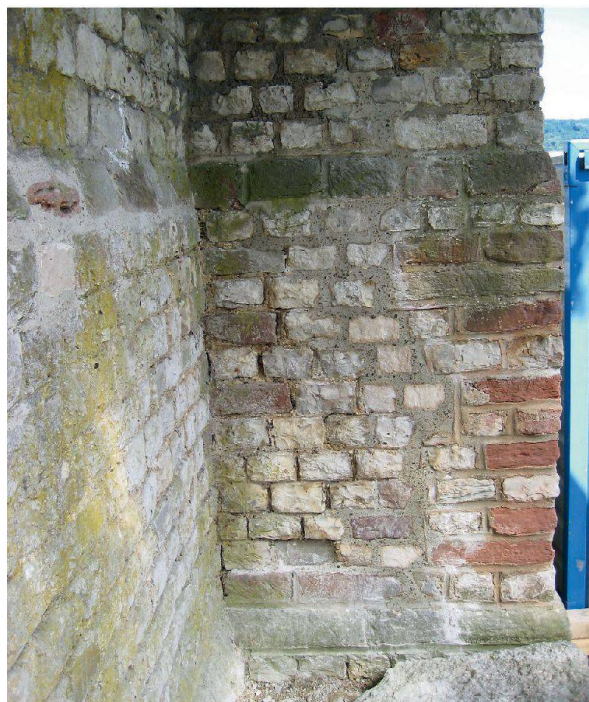
Abb. 98: Augst, Augusta Raurica, Basilikastützmauer. Statische Probleme in der noch nicht restaurierten Basilika-Ostmauer: Das Eindringen von Wasser und Frostsprengungen haben im kleinen Stützpfiler bedrohliche Risse verursacht (oben links von Norden, oben rechts von Süden gesehen). Die gespaltenen und losen Steine wurden durch frostfeste Steine ersetzt und die Fehlstellen mit Mörtel ergänzt (entsprechende Ansichten unten).
