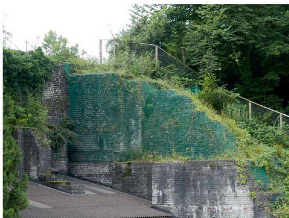
Abb. 81: Augst, Augusta Raurica, Nordhang Schönbühl. Der Stützpfiler wird nur teilweise, d. h. vor allem die Mauerschulung an der Ostseite, restauriert (links im Bild). Der ausgegrabene, aber nicht restaurierte Mauerkern und die Mauerschulung am Nordhang wurden über Jahrzehnte ihrem Schicksal überlassen und waren einem rapiden Zerfall ausgesetzt.
