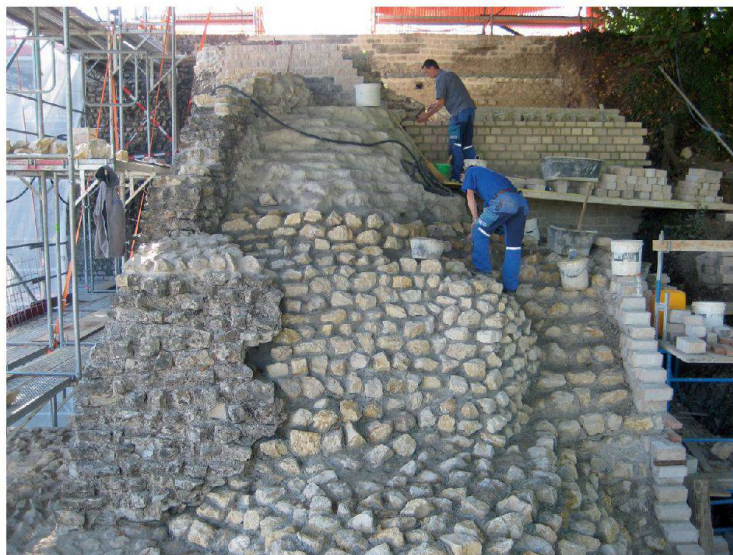
Abb. 10: Augst, Augusta Raurica, Nordhang Schönbühl. Die erste Schicht frostfester Kalkbruchsteine, sogenannter «Schroppen», wird von Dominik Fux und Mladen Puklin zugerichtet und als künftige «Schutz- und Verschleisschicht» vermauert.
