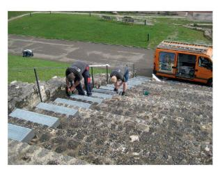
Abb. 96: Eine denkmalpflegerische Konzession an die Sicherheit der älteren Besucherinnen und Besucher am Aufgang zum Augster Schönbühltempel: Die modernen Trittstufen und ein Handlauf werden von der Firma Furrer aus Lausen seitlich der römischen Monumentaltreppe zum Tempel montiert.
