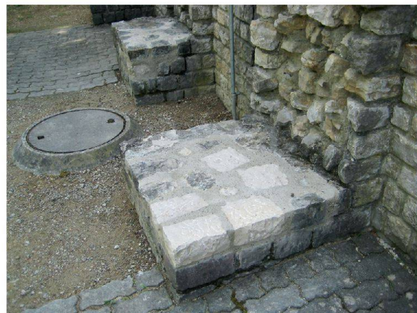
Abb. 100: Augst, Augusta Raurica, Basilikastützmauer Süd. Die sanierte Mauerkrone im Bereich der Toilettenanlage südlich der Curia.
