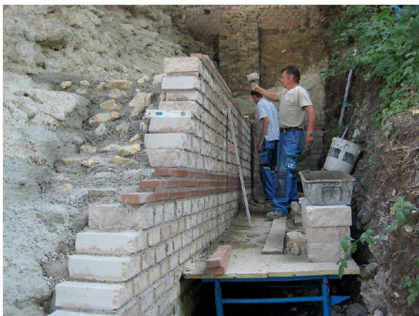
Abb. 93: Augst, Augusta Raurica, Nordhang Schönbühl. Aus statischen Gründen musste die rückwärtige Seite des Stützpfilers (westliches Mauerhaupt) von Dominik Fux und Mladen Puklin hoch aufgemauert werden.
