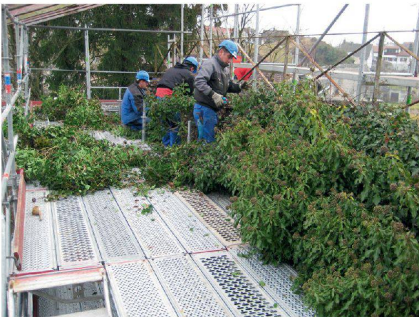
Abb. 85: Augst, Augusta Raurica, Nordhang Schönbühl. Als erste restauratorische Massnahme müssen die Stützmauer und die Mauerkrone von Bäumen und Pflanzenbewuchs befreit werden.
