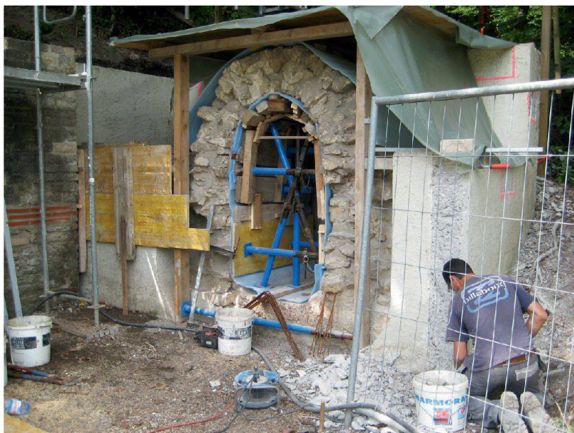
Abb. 99: Augst, Augusta Raurica, Basilikastützmauer Süd. Im Bereich der restaurierten Entlastungsbögen und der darin integrierten Toilettenanlage südlich der Curia stellen diverse lose Steine eine Gefahr für die Besucher und Besucherinnen dar. Die Schäden, verursacht durch Pflanzenwuchs auf der Mauerkrone, sind hier gut erkennbar.
