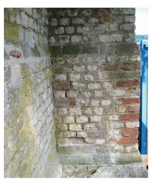
Abb. 98: Augst, Augusta Raurica, Basilikastützmauer. Statische Probleme in der noch nicht restaurierten Basilika-Ostmauer: Das Eindringen von Wasser und Frostsprengungen haben im kleinen Stützpfeiler bedrohliche Risse verursacht (oben links von Norden, oben rechts von Süden gesehen). Die gespaltenen und losen Steine wurden durch frostfeste Steine ersetzt und die Fehlstellen mit Mörtel ergänzt (entsprechende Ansichten unten).
