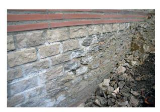
Abb. 89: Augst, Augusta Raurica, Nordhang Schönbühl, westliche Mauerschale. In allen Bereichen, wo neu aufgemauert wurde, trennen in die Mörtelfugen integrierte kleine Keramikplättchen den antiken Originalbestand von den modernen Ergänzungen.
