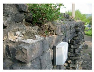
Abb. 99: Augst, Augusta Raurica, Basilikastützmauer Süd. Im Bereich der restaurierten Entlastungsbögen und der darin integrierten Toilettenanlage südlich der Curia stellen diverse lose Steine eine Gefahr für die Besucher und Besucherinnen dar. Die Schäden, verursacht durch Pflanzenwuchs auf der Mauerkrone, sind hier gut erkennbar.
