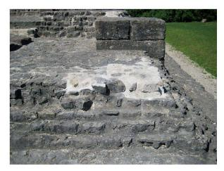
Abb. 95: Augst, Augusta Raurica, Schönbühl. An diversen Stellen des Tempelpodiums haben sich Steine gelöst. Diese wurden routinemässig durch neue Quader ersetzt.
