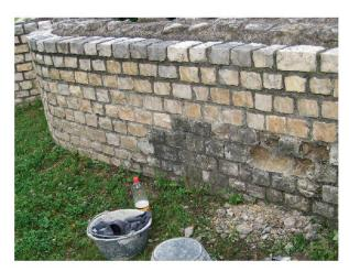
Abb. 106: Augst, Augusta Raurica, Theater. An diversen Stellen im Bereich der Umfassungsmauer von Keil 2 mussten die von Frost zerstörten Steine entfernt und durch frostfeste Steine und Mörtel ersetzt werden. Dieses Beispiel zeigt deutlich, wie auch nach der grossen Theatersanierung immer wieder Schäden auftreten können; das Monument erfordert permanente Beobachtung und laufendes restauratorisches Eingreifen.
