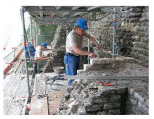
Abb. 91: Augst, Augusta Raurica, Nordhang Schönbühl. Die Stützmauer mit ihren Entlastungspfeilern oberhalb der Brotbackstube wird von Dominik Fux und Mladen Puklin dort, wo nötig, etwas aufgemauert.
