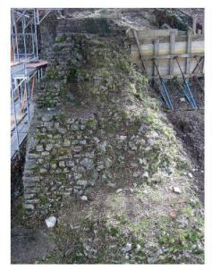
Abb. 68: Augst, Augusta Raurica, Nordhang Schönbühl (Grabung 2009.052). Die erste Grobreinigung am originalen antiken Mauerkern des Stützpfeilers durch das Restaurierungsteam. Steine und Mörtel an der während Jahrzehnten der Witterung ausgesetzten Oberfläche des Mauerkerns sind so instabil geworden, dass sie von Hand entfernt werden können. Die losen, nicht sicher antiken Kalksteine müssen zur Vorbereitung der Reinigung und Dokumentation (Abb. 69) noch entfernt werden.
