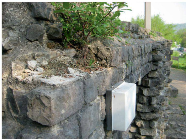
Abb. 99: Augst, Augusta Raurica, Basilikastützmauer Süd. Im Bereich der restaurierten Entlastungsbögen und der darin integrierten Toilettenanlage südlich der Curia stellen diverse lose Steine eine Gefahr für die Besucher und Besucherinnen dar. Die Schäden, verursacht durch Pflanzenwuchs auf der Mauerkrone, sind hier gut erkennbar.
