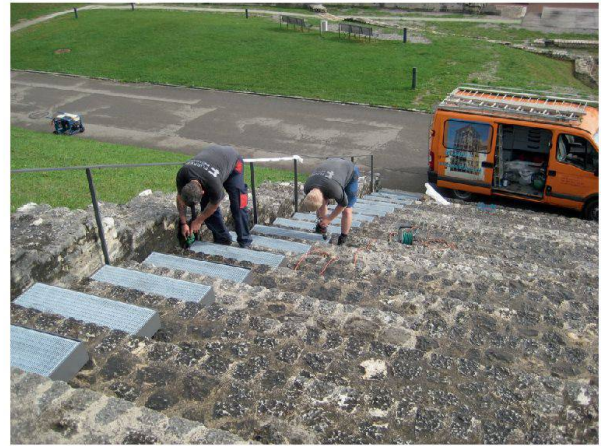
Abb. 96: Eine denkmalpflegerische Konzession an die Sicherheit der älteren Besucherinnen und Besucher am Eingang zum Augster Schönbühltempel: Die modernen Trittstufen und ein Handlauf werden von der Firma Furrer aus Lausen seitlich der römischen Monumentaltreppe zum Tempel montiert.
