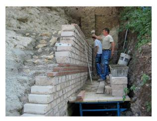
Abb. 93: Augst, Augusta Raurica, Nordhang Schönbühl. Aus statischen Gründen musste die rückwärtige Seite des Stützpfeilers (westliches Mauerhaupt) von Dominik Fux und Mladen Puklin hoch aufgemauert werden.
