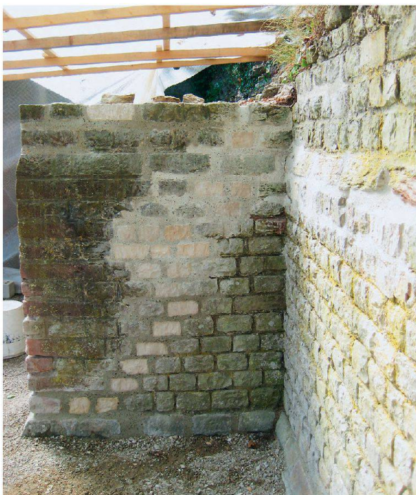
Abb. 98: Augst, Augusta Raurica, Basilikastützmauer. Statische Probleme in der noch nicht restaurierten Basilika-Ostmauer: Das Eindringen von Wasser und Frostsprengungen haben im kleinen Stützpfiler bedrohliche Risse verursacht (oben links von Norden, oben rechts von Süden gesehen). Die gespaltenen und losen Steine wurden durch frostfeste Steine ersetzt und die Fehlstellen mit Mörtel ergänzt (entsprechende Ansichten unten).
