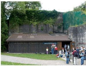
Abb. 83: Augst, Augusta Raurica, Nordhang Schönbühl. Aufbau des Gerüsts durch die Firma Roth AG. Um den offen liegenden antiken Mauerkern während der Arbeiten gegen Feuchtigkeit zu schützen, war eine vollständige Überdachung notwendig.
