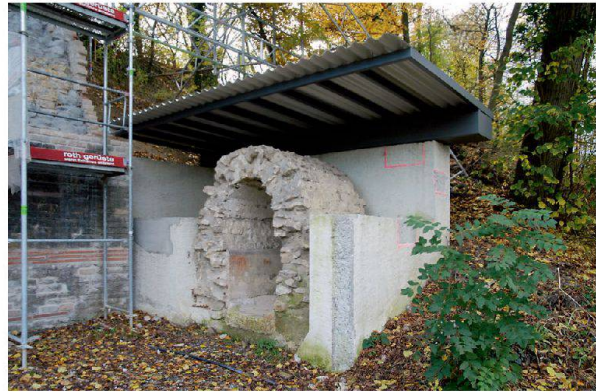
Abb. 103: Augst, Augusta Raurica, Wasserleitungs-Exponat am Nordabhang des Schönbühls. Das Holzdach wurde durch ein modernes Metaldach ersetzt. Die Maler- und Umgebungsarbeiten werden 2010 noch folgen.
