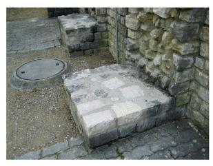
Abb. 100: Augst, Augusta Raurica, Basilikastützmauer Süd. Die sanierte Mauerkrone im Bereich der Toilettenanlage südlich der Curia.
