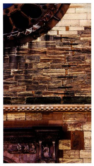
Abb. 4: Basel, Münster-Nordwestfassade am Querschiff über der romanischen Galluspforte. Das bei der Bevölkerung bekannteste Zeugnis des grossen Erdbebens vom 18. Oktober 1356 ist der klaffende Riss zwischen den Sandsteinquadern, der im Zuge der gotischen Reparaturarbeiten mit eisernen Klammern zusammengehalten wurde.
