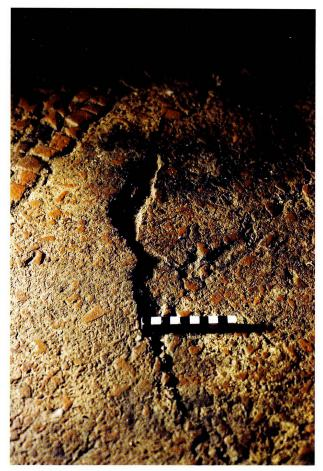
Abb. 25: Augusta Raurica, Region 2A westlich des Theaters. Durch Absacken des Untergrundes entstandener Riss. Aufnahme im Streiflicht.
