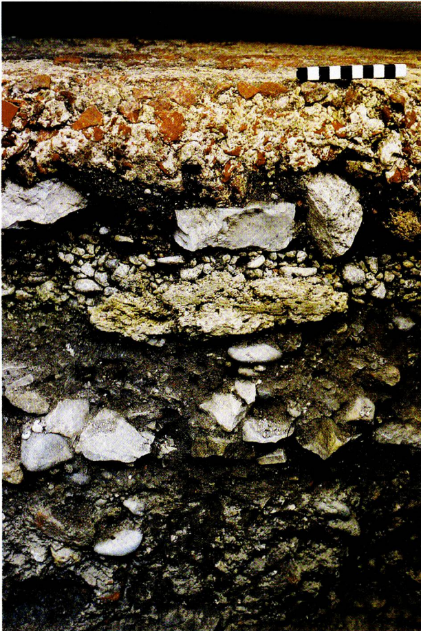
Abb. 11: Augusta Raurica, Region 2A westlich des Theaters. Ziegelsplittmörtel mit Fundament und vermutlich älteren Planien als Unterkonstruktion.
