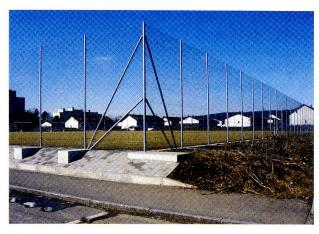
Abb. 26: Kaiseraugst AG, Sportanlagen Im Liner (Grabung 2008.005). «Bauen über den Ruinen». Das Fussballfeld liegt auf einer Aufschüttung über dem geschützten Gräberfeld «Im Sager». Blick von Osten auf die Spezialfundation der Einzäunung.
