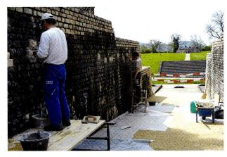
Abb. 83: Augst, Augusta Raurica. Theater. Auch hier im Mittelvomitorium waren bereits wieder punktuelle Ausbesserungen am alt restaurierten Mauerwerk nötig (analog Abb. 82; Mladen Puklin und Remo Plattner, Markus Fux AG)
