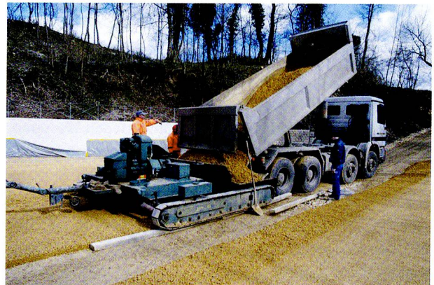
Abb. 87: Augst, Augusta Raurica. Amphitheater. Einbringen des neuen Belags in der Arena. Unten: Der Mergel wird mit dem LKW direkt in die Einbaumaschine gekippt und mit dieser gleichmässig verteilt (Firmen M. Fux AG und Aymonod Tiefbau AG).
