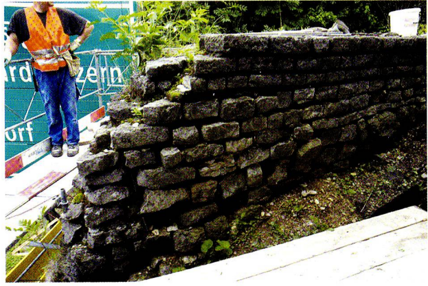
Abb. 75: Augst, Augusta Raurica. Westliche Stadtmauer. Nach Jahrzehnten haben Wurzeln von Sträuchern und Bäumen erhebliche Schäden an der Mauer verursacht. Der kompakte «Deckel» ist Teil der Erstrestaurierung mithilfe von (zu) hartem Portlandzement.
