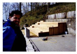
Abb. 91: Augst, Augusta Raurica. Amphitheater. Schreiner Thomas Bitterli aus Lausen/BL (links) erneuerte die maroden, 20 Jahre alten Sitzstufen-«Rekonstruktionen» aus Eichenholz über dem Carcer (vgl. Abb. 90). Der weitaus grösste Teil der ehemaligen – im Oval angeordneten – Sitzstufen des Amphitheaters von Augusta Raurica präsentiert sich heute als bewaldeter Hang (im Bildhintergrund) rings um die Arena.
