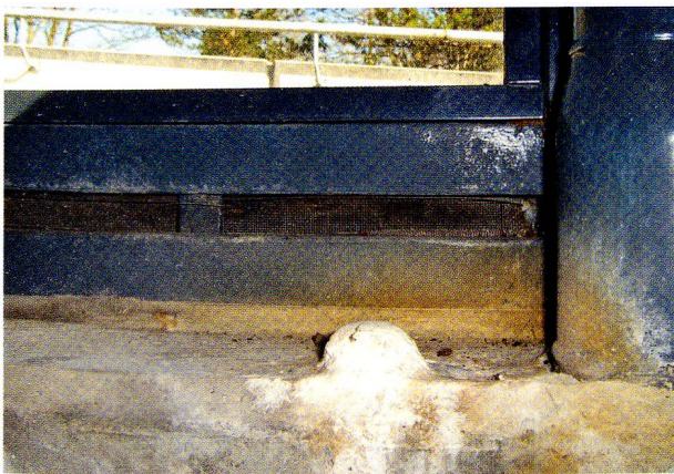
Abb. 94: Kaiseraugst-Liebrüti. Im «modernen» Schutzhäuser über den beiden römischen Ziegelbrennöfen haben sich infolge eines immer wieder undicht gewordenen Beton-Flachdachs richtige Stalagmiten gebildet (vorne in der Mitte). Auch die metallenen Fensterrahmen sind durch Rostbildung stark in Mitleidenschaft gezogen worden. Das Aargauer Hochbauamt hat 2008 alle Schäden behoben (Abb. 95).
