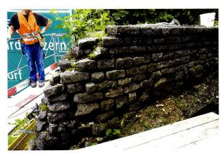
Abb. 75: Augst, Augusta Raurica. Westliche Stadtmauer. Nach Jahrzehnten haben Wurzeln von Sträuchern und Bäumen erhebliche Schäden an der Mauer verursacht. Der kompakte «Deckel» ist Teil der Erstrestaurierung mithilfe von (zu) hartem Portlandzement.
