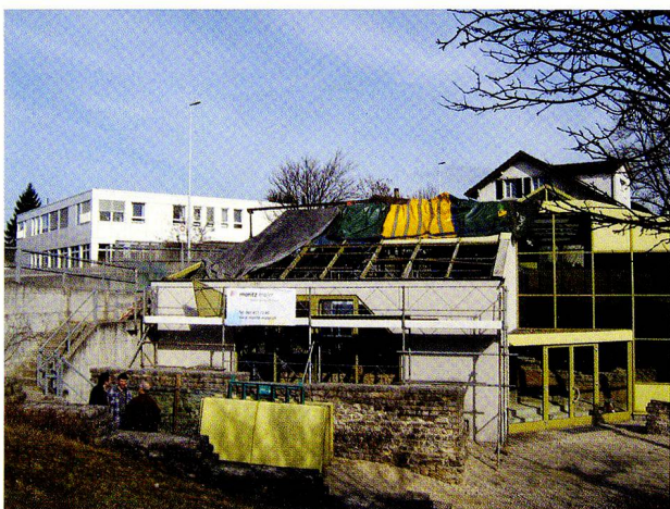
Abb. 96: Kaiseraugst-Schmidmatt. Das viel besuchte «römische Handels- und Gewerbehaus» unter diesem modernen Schutzbau war gefährdet, nachdem sich versteckte Korrosionsschäden an der Dachkonstruktion bemerkbar gemacht haben. Das Hochbauamt des Kantons Aargau liess die schadhafte Stellen freilegen und sanieren. Die damit beauftragte Firma nahm sich monatelang Zeit dafür, während der die stellenweise mit Plastikplanen abgedeckte archäologische Stätte nicht gerade einladend aussah.
