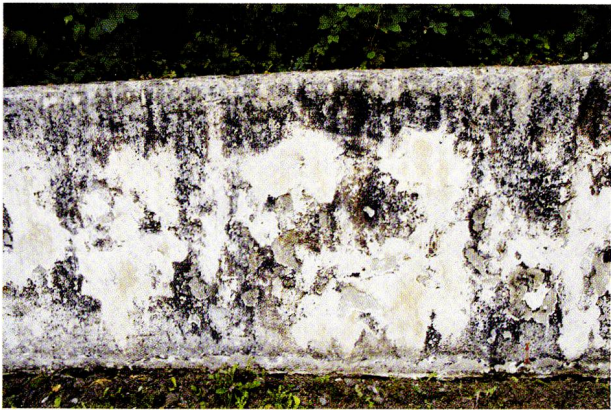
Abb. 72: Augst, Augusta Raurica. Amphitheater. Der schlecht erhaltene Wandverputz von 1987 auf der teilrekonstruierten Arenamauer. Unten ein Detail mit Algen- und Flechtenbefall.
