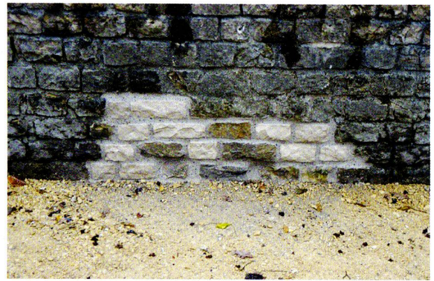
Abb. 73: Augst, Augusta Raurica. Amphitheater. An diversen Stellen muss – 21 Jahre nach der ersten umfassenden Restaurierung – die Arenamauer teilweise neu ausgefugt werden.
