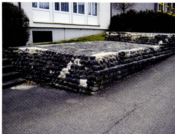
Abb. 79: Kaiseraugst-Dorf, Wehrmauer des Castrum Rauracense. Die Mauerkrone am Fuchsloch (Abb. 78, unten) ist repariert.
