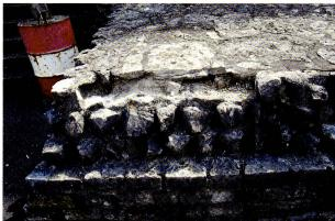
Abb. 78: Kaiseraugst-Dorf, Wehrmauer des Castrum Rauracense. Viele Mauerkronen, wie hier am Heidemurweg (oben) oder bei der Feuerwehrkaserne am Fuchsloch (unten), sind durch Witterungseinflüsse stark beschädigt und an mehreren Stellen von Vandalen ausgebrochen worden.
