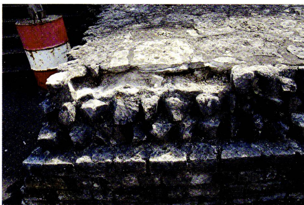
Abb. 78: Kaiseraugst-Dorf, Wehrmauer des Castrum Rauracense. Viele Mauerkrone, wie hier am Heidemurweg (oben) oder bei der Feuerwehrkaserne am Fuchsloch (unten), sind durch Witterungseinflüsse stark beschädigt und an mehreren Stellen von Vandalen ausgebrochen worden.
