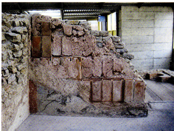
Abb. 81: Kaiseraugst-Schmidmatt. Die mutwillig herausgebrochenen Tubuli (Abb. 80) mussten an originaler Position wieder eingepasst werden.
