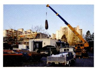
Abb. 95: Kaiseraugst-Liebrüti. Zur Sanierung des undichten Betondaches über den antiken Ziegelbrennöfen wird eine auf Mass vorfabrizierte Abdichtfolie «am Stück» auf das vorbereitete Dach gebracht.
