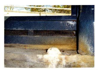
Abb. 94: Kaiseraugst-Liebrüti. Im «modernen» Schutzhaus über den beiden römischen Ziegelbrennöfen haben sich infolge eines immer wieder undicht gewordenen Beton-Flachdachs richtige Stalagmiten gebildet (vorne in der Mitte). Auch die metallenen Fensterrahmen sind durch Rostbildung stark in Mitleidenschaft gezogen worden. Das Aargauer Hochbauamt hat 2008 alle Schäden behoben (Abb. 95).
