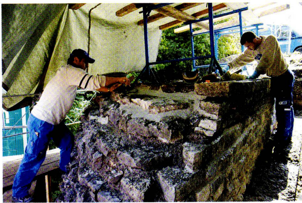
Abb. 76: Augst, Augusta Raurica. Westliche Stadtmauer. Die Fehlstellen wurden mit neuen Quadern ergänzt und der vielerorts herausgefallene Fugenmörtel neu mit einer Kalkmörtelmischung ausgefugt (Mladen Puklin und Remo Plattner, Markus Fux AG).
