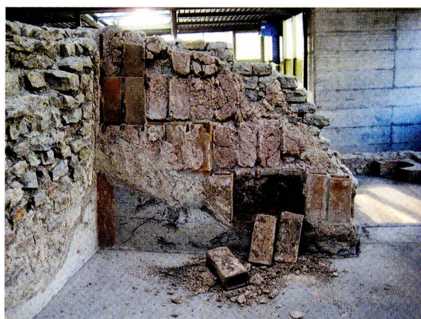
Abb. 80: Kaiseraugst-Schmidmatt. Drei Tubuli im am besten erhaltenen Hypokaust-Raum von Augusta Raurica wurden von Vandalen aus dem originalen Wandverband gerissen.
