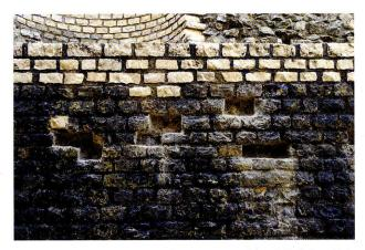
Abb. 82: Augst, Augusta Raurica. Theater. Nur ein Jahr nach Ende der 16 Jahre dauernden Gesamtsanierung mussten von Frost versplitterte Steine einer damals nicht sanierten Mauerpartie bereits entfernt und mit neuen Quadern ersetzt werden. – Dieses Beispiel zeigt: Archäologische Denkmalpflege ist eine Daueraufgabe!
