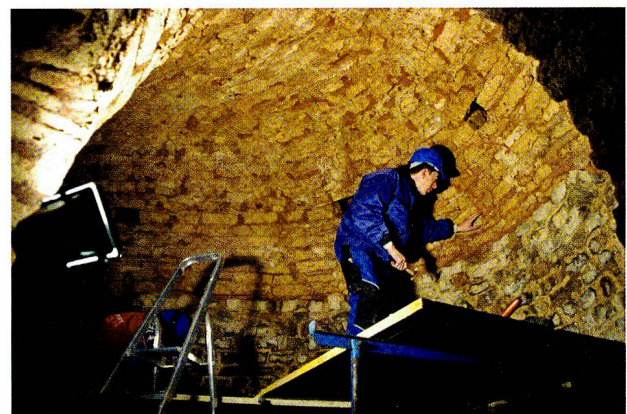
Abb. 84: Augst-Violenried, Badeanlage und Unterirdisches Brunnenhaus. Die Gewölbedecke wird im Rahmen der Aktualisierung des Schadenskatasters auf lose Tuffsteine und fehlerhaften Fugenmörtel kontrolliert (Dominik Fux, Markus Fux AG).
