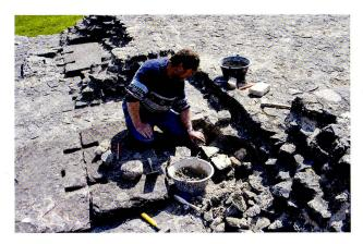
Abb. 70: Augst, Augusta Raurica. Punktuelle Konservierungsarbeiten am Podium des Schönbühltempels durch Max Heid von der Bauunternehmung Markus Fux AG.
