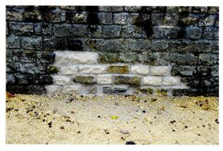
Abb. 73: Augst, Augusta Raurica. Amphitheater. An diversen Stellen muss – 21 Jahre nach der ersten umfassenden Restaurierung – die Arenamauer stellenweise neu ausgefugt werden.
