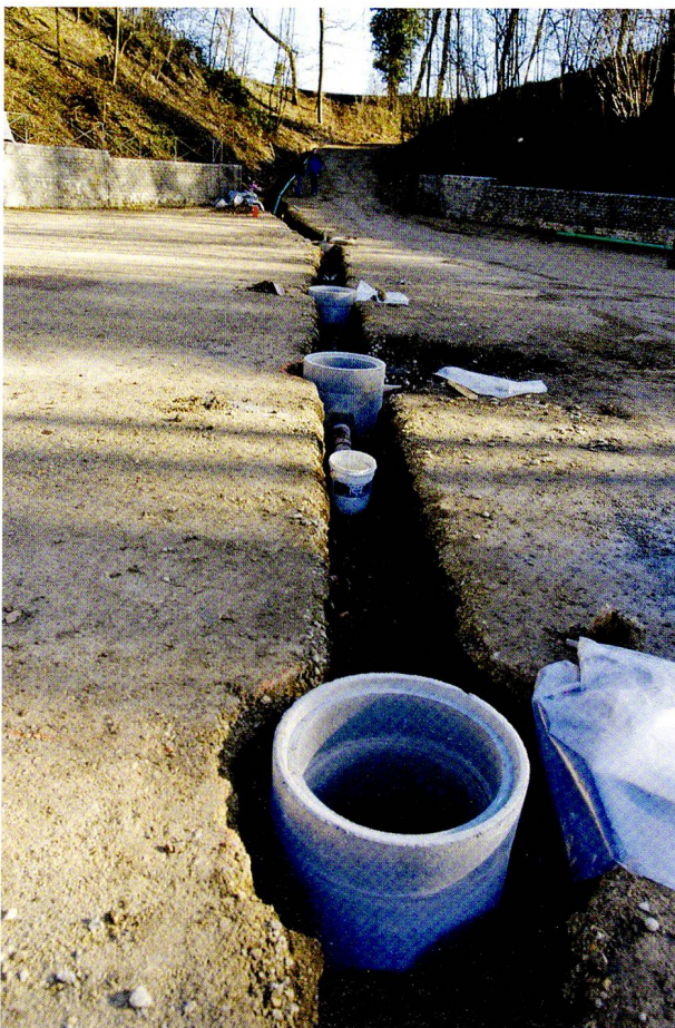
Abb. 86: Augst, Augusta Raurica. Amphitheater. Die neu gegrabene Sickerleitung in der Arena mit dem Anschluss an drei neue Sickerschächte.
