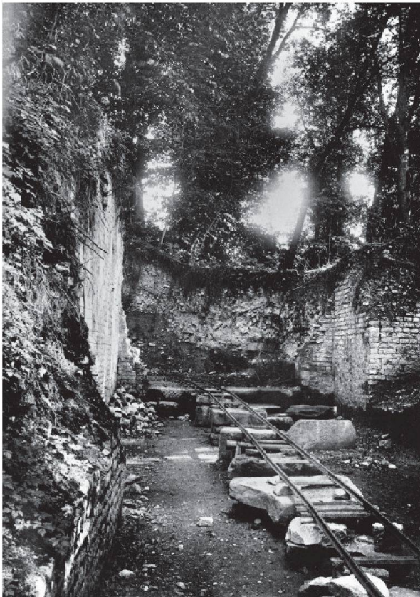
Abb. 3: Augst, Theater. Freilegungsarbeiten 1898 im Südaditus des Augster Theaters. Man beachte die enormen Schuttmassen, die mithilfe einer Rollbahn aus dem Monument abgeführt wurden.
