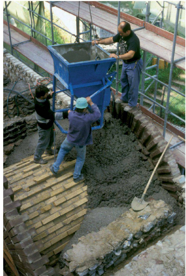
Abb. 66: Augst, Theatersanierung (Grabung 1992–2007.055). Fenstergewölbe in der äusseren Aditusmauer MR 1, Arbeitsfoto. Nach dem Einpassen des durch keilförmige Muschelkalkquäderchen gefertigten unteren Teils der Gewölbeschale wird der darüberliegende Gewölbereich ausbetoniert.
