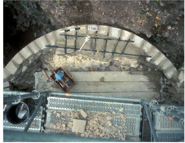
Abb. 57: Augst, Theatersanierung (Grabung 1992–2007.055). Peripherie Keil 4, Entlastungsbogen MR 139, Aufsicht von Süden. Ein Netz von eingelegten Glasfaserstäben verbessert die Druckverteilung der modernen Aufmauerung auf die bestehende Mauerschale.
