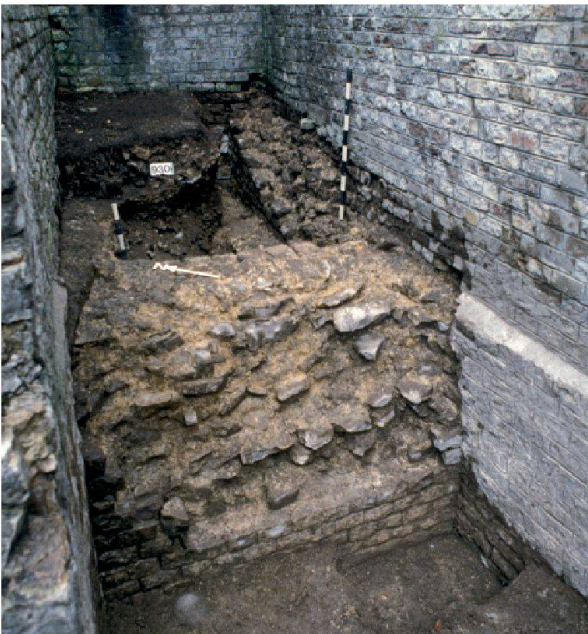
Abb. 36: Augst, Theatersanierung (Grabung 1992–2007.055). Peripherie des jüngeren szenischen Theaters, Keil 2; Eingangsbereich des Nordost-Vomitoriums des jüngeren szenischen Theaters, Umbau- oder Reparaturmassnahmen (Phase 5b). Über den Mauerkronen älterer Mauerzüge (Phase 4b) wurden mit fast identischem Verlauf neue Mauerpartien (Phase 5b) errichtet. Beide Bauphasen gehören zum jüngeren szenischen Theater.
