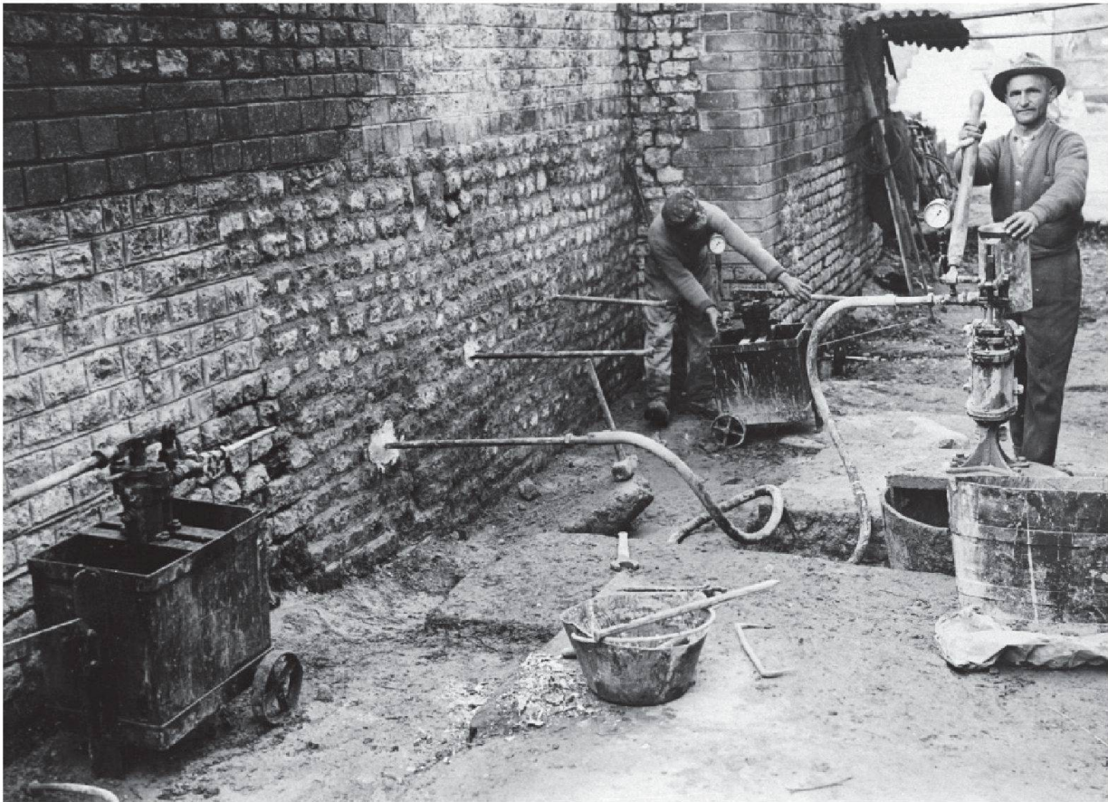
Abb. 62: Augst, Theater. Injektionsarbeiten von 1934 im Südaditus.
