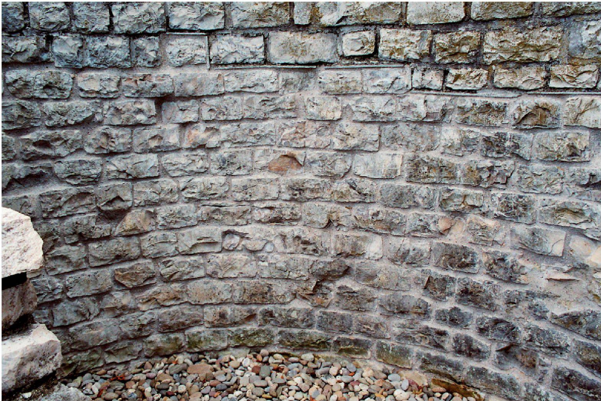
Abb. 60: Augst, Theatersanierung (Grabung 1992–2007.055). Peripherie Keil 2, Entlastungsbogen MR 125. Die geklebten Handquadern wurden mit einem speziell entwickelten, weichen Restauriermörtel gefügt, die Mauerschale erscheint geschlossen und bietet Wasser und Vegetation wenig Angriffsfläche.
