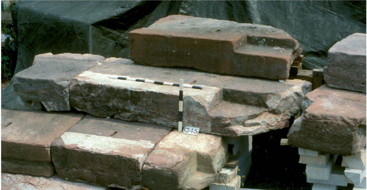
Abb. 31: Augst, Theatersanierung (Grabung 1992–2007.055). Architekturprobe der cavea des jüngeren szenischen Theaters unter Verwendung originaler Sitzstufenquader aus Buntsandstein.
