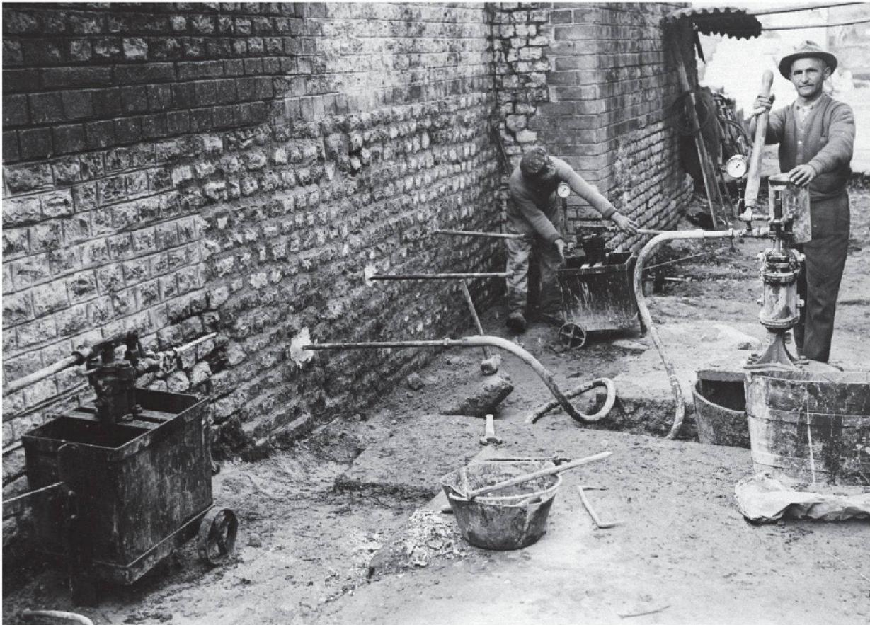
Abb. 62: Augst, Theater. Injektionsarbeiten von 1934 im Südaditus.
