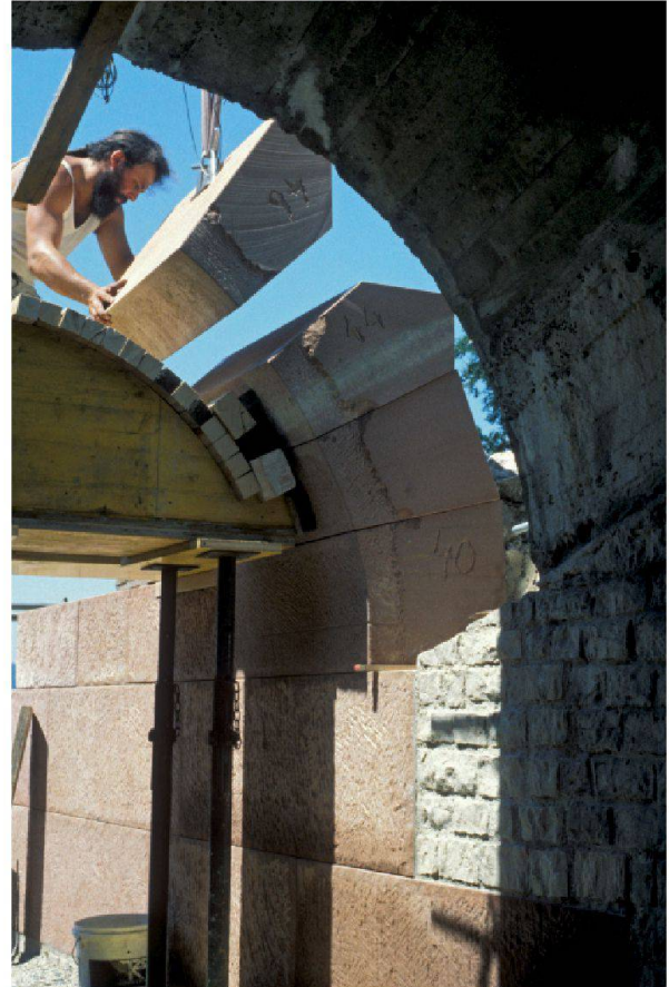
Abb. 69: Augst, Theatersanierung (Grabung 1992–2007.055). Erneuerung des Mündungsbereichs des sogenannten Südost-Vomitoriums, Arbeitsfoto. Die Gewölbequader aus feinkörnigem Buntsandstein werden mit einem modernen, dem antiken «Wolf» nachempfundenen Hebegerät vorsichtig auf das Leergestell abgesenkt. Blick von Nordosten.
