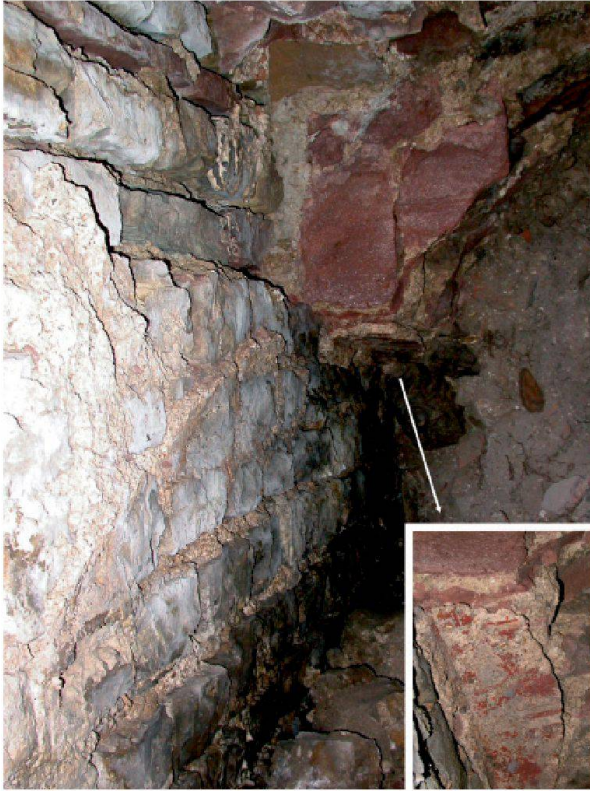
Abb. 39: Augst, Theatersanierung (Grabung 1992–2007.055). Verstürztes Mauerstück aus der südlichen Eingangshalle des jüngeren szenischen Theaters. Es handelt sich um die Überreste eines Blendbogens, der verputzt und bemalt war; die bogenförmige Mörtelbraue markiert die Unterseite des vorgeblendeten Sandsteinbogens, darunter die auf Sicht ausgeführte Kalksteinmauer mit rotem Fugenstrich. Der Verputz des Bogens imitiert Sandsteinarchitektur, indem die Keilsteine und die pietra-rasa -Verfugung mit dunkelroter Farbe aufgemalt sind.
