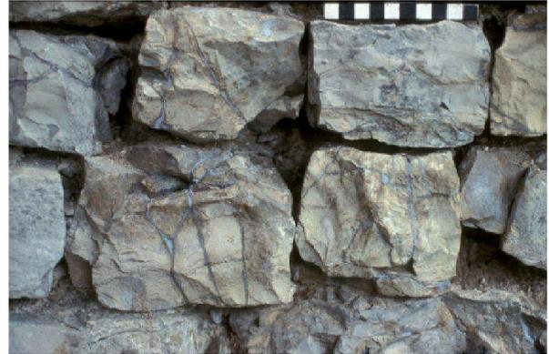
Abb. 59: Augst, Theatersanierung (Grabung 1992–2007.055). Die Kalkstein-Handquader der Mauerschalen weisen durch Alter und Witterung, aber auch durch Frosteinwirkung unzählige Haarrisse auf. In aufwendiger Feinarbeit wurden die Steinstücke verklebt und die Mauerschalen so wieder geschlossen.
