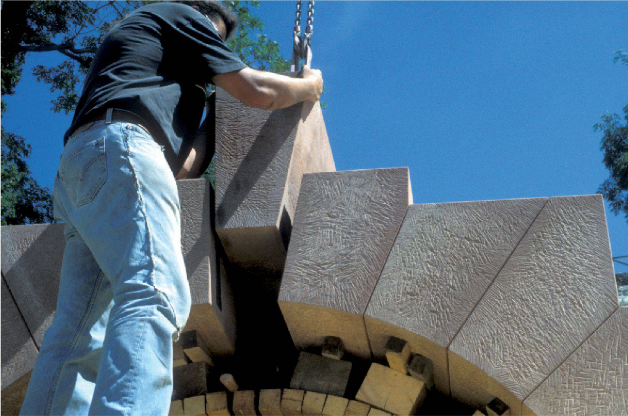
Abb. 70: Augst, Theatersanierung (Grabung 1992–2007.055). Erneuerung des Mündungsbereichs des sogenannten Südost-Vomitoriums, Arbeitsfoto, Gewölbekonstruktion aus feinkörnigem Buntsandstein. Erst mit dem Einsetzen des Schlusssteins wird eine kraftschlüssige Verbindung der ganzen Konstruktion erreicht. Blick von Westen.
