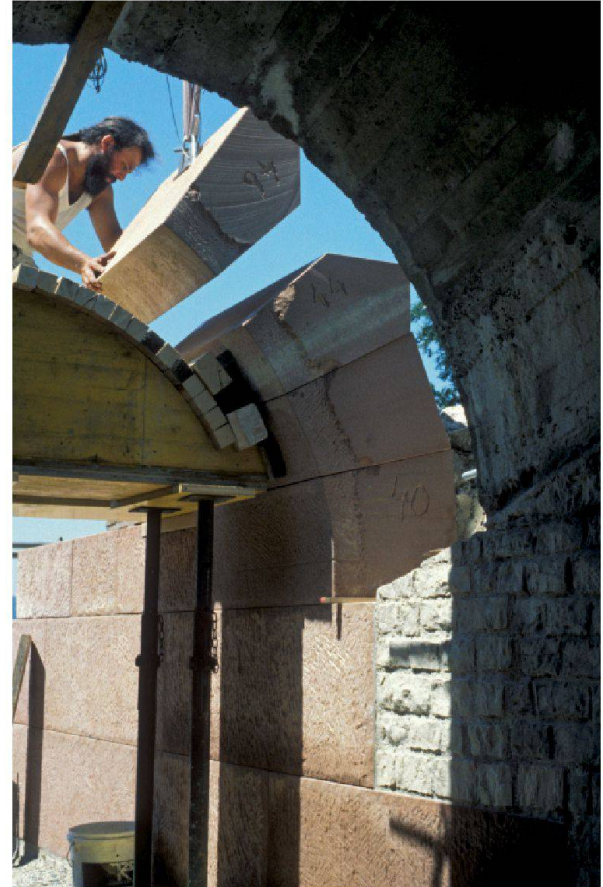
Abb. 69: Augst, Theatersanierung (Grabung 1992–2007.055). Erneuerung des Mündungsbereichs des sogenannten Südost-Vomitoriums, Arbeitsfoto. Die Gewölbequader aus feinkörnigem Buntsandstein werden mit einem modernen, dem antiken «Wolf» nachempfundenen Hebegerät vorsichtig auf das Leegerüst abgesetzt. Blick von Nordosten.
