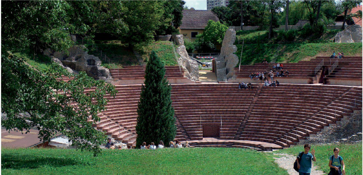
Abb. 74: Augst, Theatersanierung (Grabung 1992–2007.055). Teilrekonstruktion der Sitzstufenränge, Übersichtsfoto von Westen, nach Abschluss der Arbeiten.
