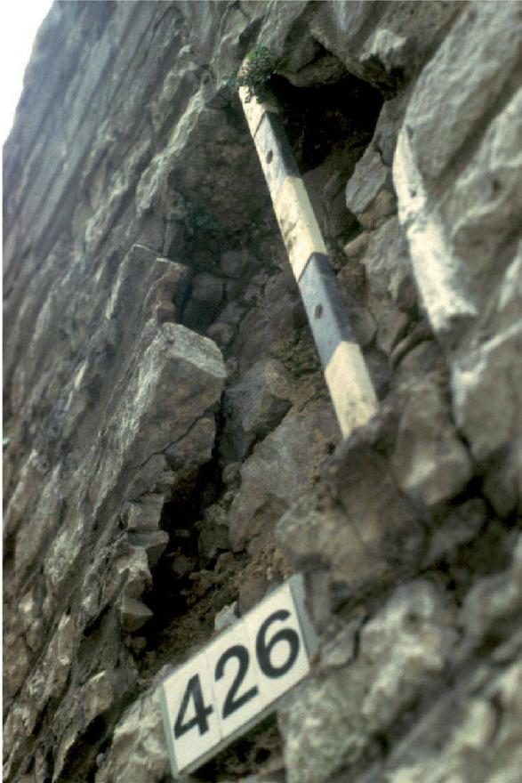
Abb. 58: Augst, Theatersanierung (Grabung 1992–2007.055). Typisches Schadensbild durch Frostsprengung mit Ablösung einer grösseren Schalenplatte an der Ostseite von Mauer MR 2. Zustand bei Beginn der Sanierungsarbeiten.
