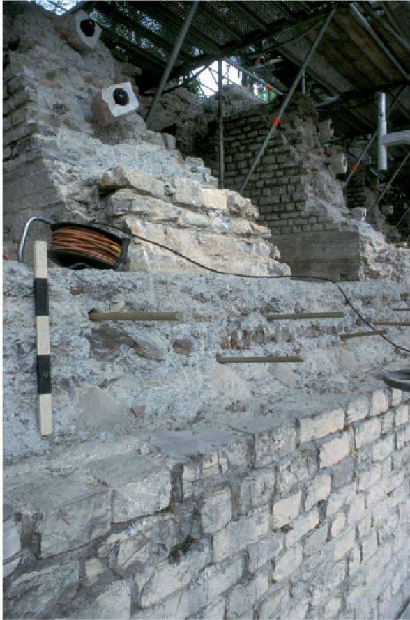
Abb. 56: Augst, Theatersanierung (Grabung 1992–2007.055). Peripheriemauer Keil 3, Blick von Süden. Kurze Glasfaseranker (im Vordergrund) und Glasfaserdübel mit verschraubtem Ankerkopf (Hintergrund, oben) verbessern die Verbindung zwischen antikem Mauerwerk und moderner Vormauerung.
