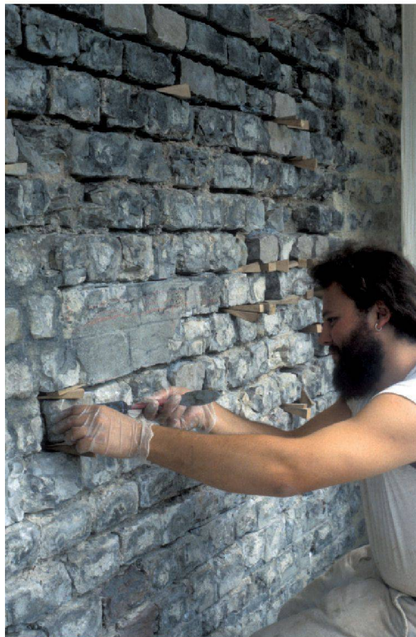
Abb. 48: Augst, Theatersanierung (Grabung 1992–2007.055). Mauerschale von Mauer MR 44/200, Arbeitsfoto während der Sanierung der vom Kern losgelösten Mauerschale.
