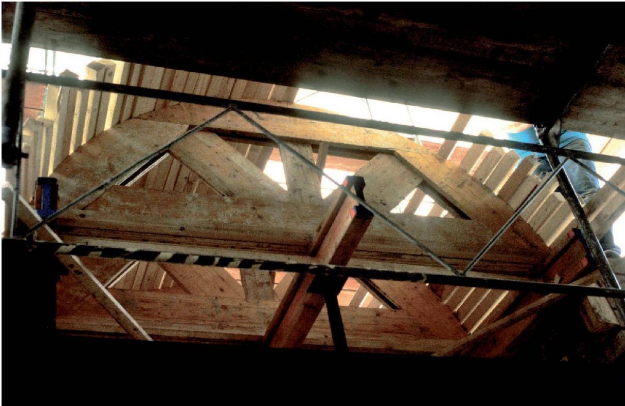
Abb. 64: Augst, Theatersanierung (Grabung 1992–2007.055). Fenstergewölbe in der äusseren Aditusmauer MR 1, Arbeitsfoto. Einbau der Gewölbeschalung aus Holz.
