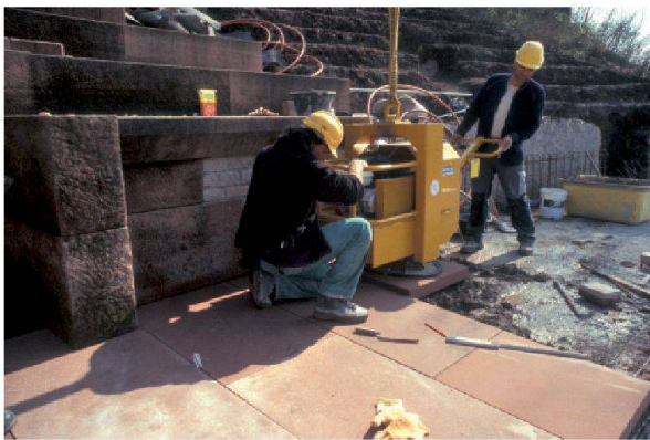
Abb. 75: Augst, Theatersanierung (Grabung 1992–2007.055). Rekonstruktion des sogenannten Diazoma-Umgangs, Arbeitsfoto. Die schweren Bodenplatten werden mit einem modernen Vakuum-Hebegerät versetzt. Blick von Norden gegen Keil 4.
