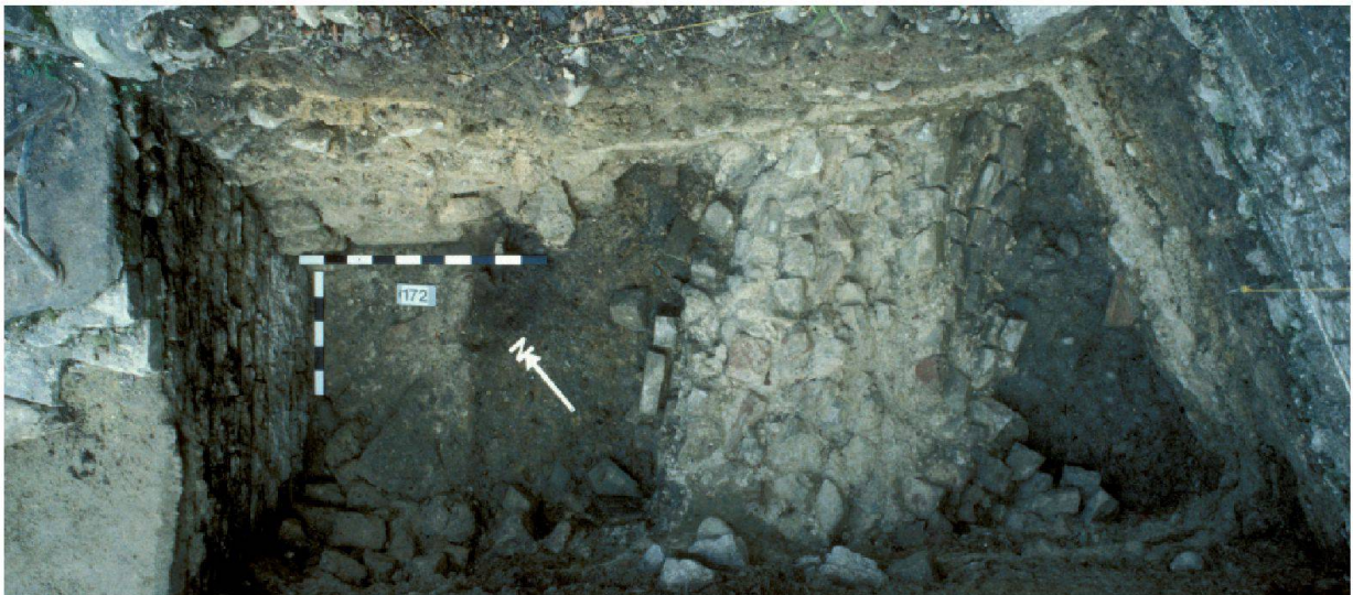
Abb. 12: Augst, Theatersanierung (Grabung 1992–2007.055). Grabungsschnitt zu Füßen des südlichen Abschnitts der sogenannten «Diazomanauer» (links im Bild die Rückseite der äusseren Couloirmauer des älteren szenischen Theaters). Im Zentrum ein verstärktes Mauerstück der vorthheaterzeitlichen Phase 1a.
