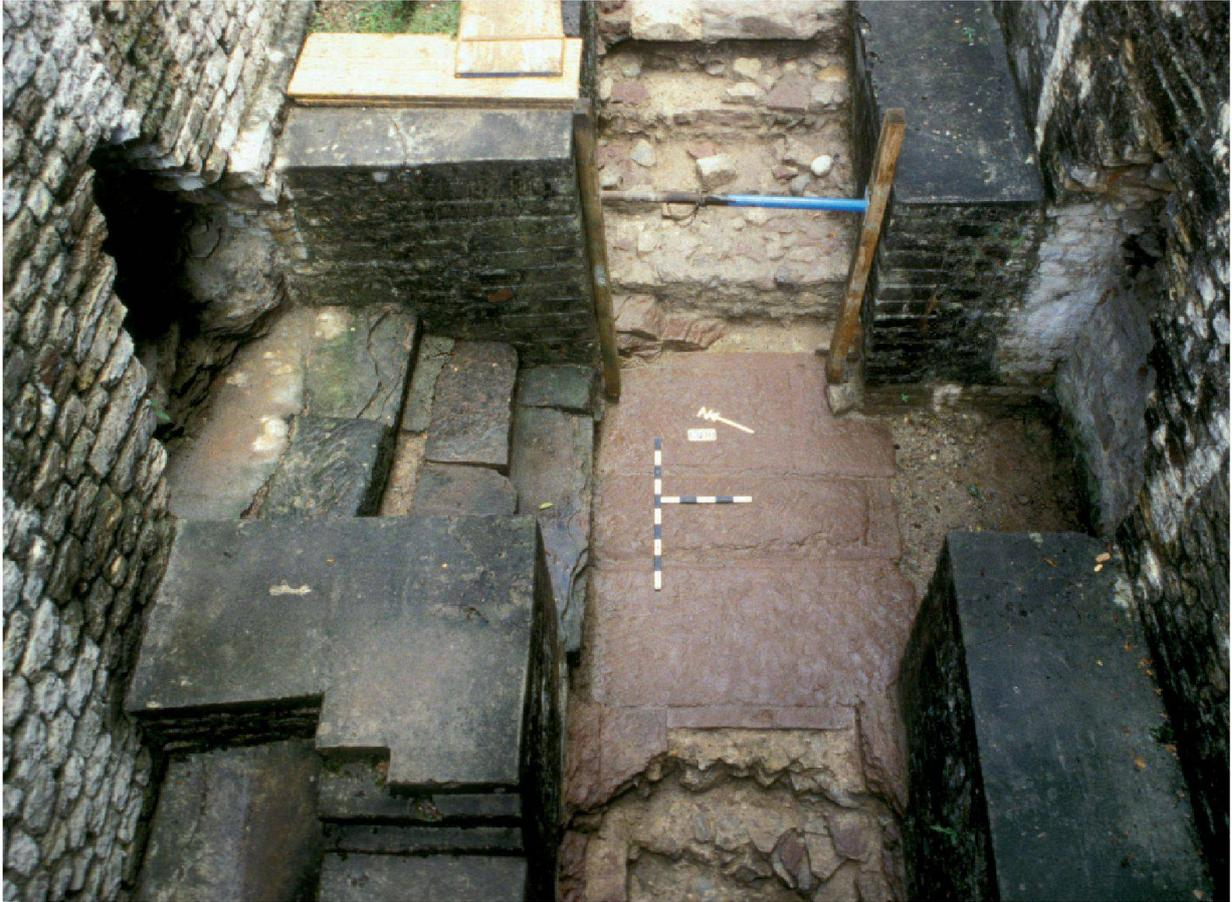
Abb. 19: Augst, Theatersanierung (Grabung 1992–2007.055). Oberer Abschnitt der axial gelegenen Mitteltreppe; Umbausituation, entstanden durch Integration dieses Treppenabschnitts in die Baustruktur des Amphitheaters. Die seitlich (links und rechts) vom Treppenpodest abgehenden Seitentreppe wurden erst beim Bau des Amphitheaters angelegt und führten in einen Erschliessungsgang, der parallel zur Umfassungsmauer verlief.
