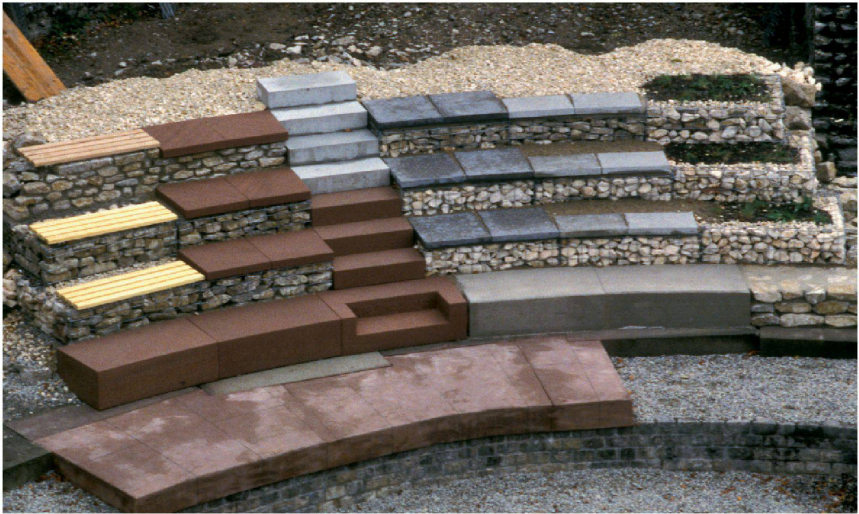
Abb. 71: Augst, Theatersanierung (Grabung 1992–2007.055). Teilrekonstruktion der Sitzstufenränge im Rahmen des Architektenwettbewerbs. Bemusterung verschiedener Varianten für die Sitzstufenrekonstruktion.
