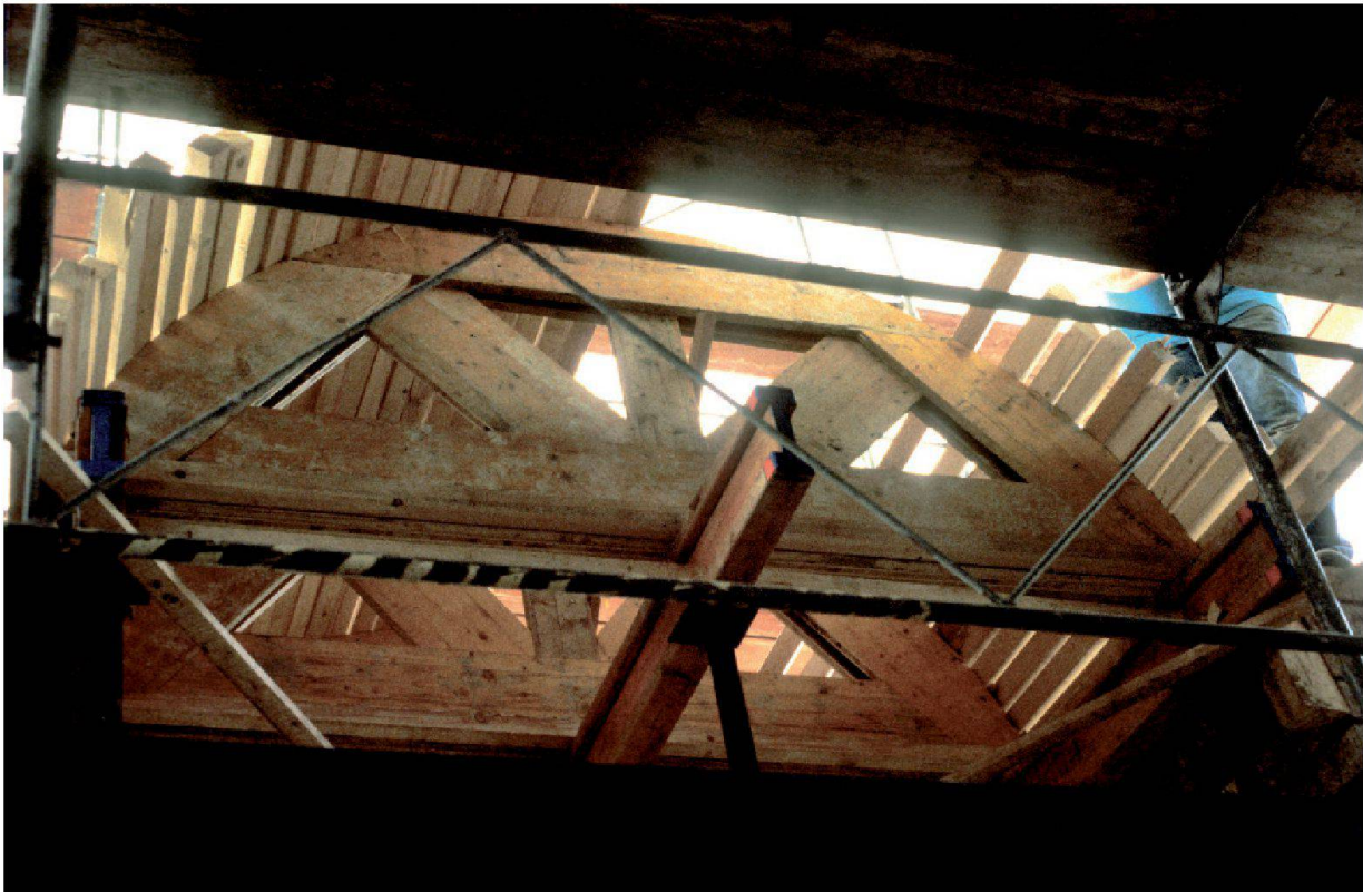
Abb. 64: Augst, Theatersanierung (Grabung 1992–2007.055). Fenstergewölbe in der äusseren Aditusmauer MR 1, Arbeitsfoto. Einbau der Gewölbeschalung aus Holz.
