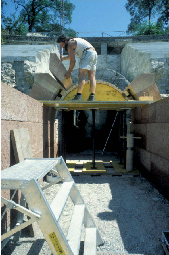
Abb. 68: Augst, Theatersanierung (Grabung 1992–2007.055). Erneuerung des Mündungsbereichs des sogenannten Südost-Vomitoriums, Arbeitsfoto. Über den bereits erneuerten Seitenwangen wird der Gewölbebogen aus feinkörnigem Buntsandstein in mörtelloser Werksteintechnik über einem Leergestell aufgebaut. Blick von Westen.
