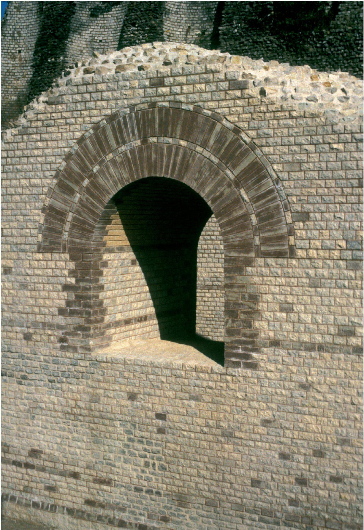
Abb. 67: Augst, Theatersanierung (Grabung 1992–2007.055). Fenstergewölbe in der äusseren Aditusmauer MR 1. Der statisch gefährdete nördliche Mauerklotz ist durch die in der Betonübermauerung des Fensters eingelegten Glasfaserstäbe mit der übrigen Mauer verbunden. Ansicht an die fertiggestellte Fensterrekonstruktion, Blick von Südwesten.
