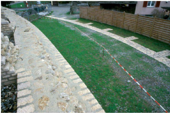
Abb. 76: Augst, Theatersanierung (Grabung 1992–2007.055). Peripheriemauer des ersten szenischen Theaters. Eine bodenebene Markierung aus flachen Kalksteinplatten lässt den Besucher die Dimension des ältesten Theaters erahnen. Blick von Süden im Mauerbereich von Keil 3.
