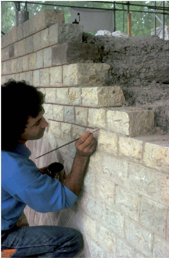
Abb. 78: Augst, Theatersanierung (Grabung 1992–2007.055). Fenster in der äusseren Aditusmauer MR 1, Bemalen der Mörtelfugen zwischen den einzelnen Handquadem des opus-vittatum-Mauerwerks entsprechend den antiken Vorgaben.
