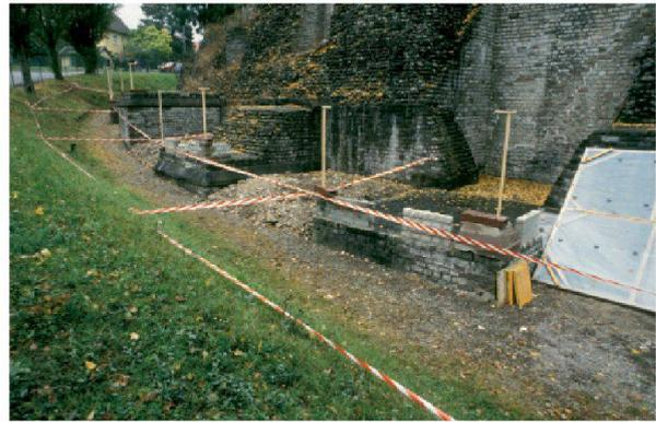
Abb. 63: Augst, Theatersanierung (Grabung 1992–2007.055). Die Visualisierung der geplanten Erdanschüttung an Peripherie Keil 1 dient als Hilfe zur Entscheidungsfindung während einer Sitzung der Eidgenössischen Kommission für Denkmalpflege. Durch die Erdanschüttung werden antike Mauerpartien optimal geschützt, der Erddruck hilft zudem bei der Stabilisierung der Peripheriemauern.
