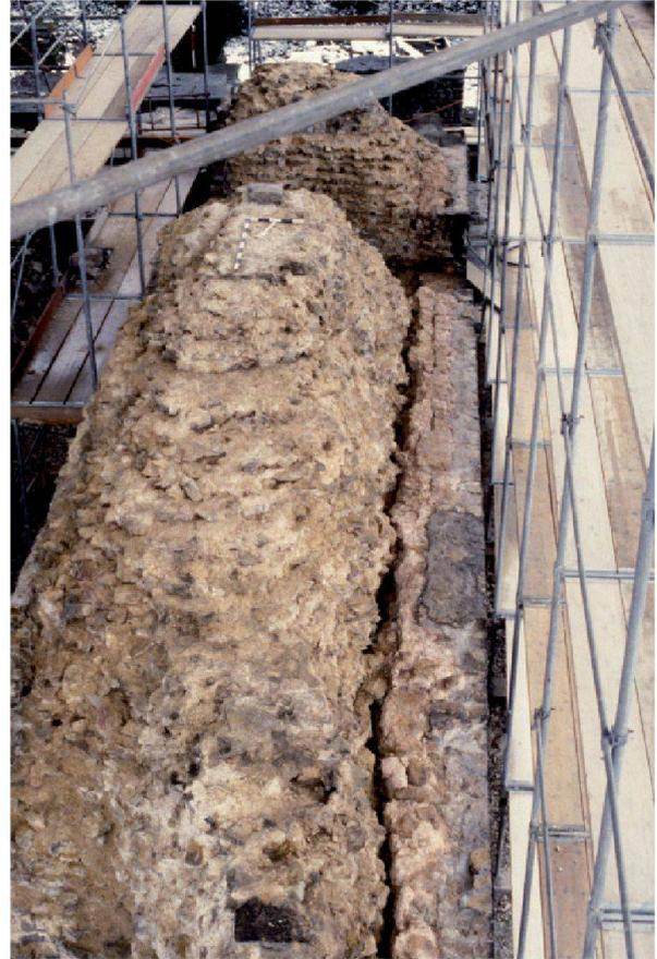
Abb. 50: Augst, Theatersanierung (Grabung 1992–2007.055). Die römische Reparatur der Mauerschale von Mauer MR 44/200 im südlichen Hauptzugang (aditus maximus) zeichnet sich durch die Ziegelstaubbeimischung im Mörtel deutlich ab; sie ist durch eine erneute Kluft vom ursprünglichen Mauerkern getrennt. Blick von Norden.
