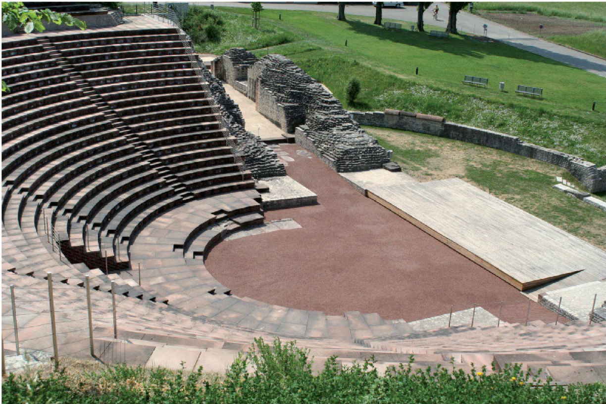
Abb. 22: Augst, Theatersanierung (Grabung 2007.055). Verfestigter Bodenbelag in der Orchestra, Übersicht. Blick von Norden.
