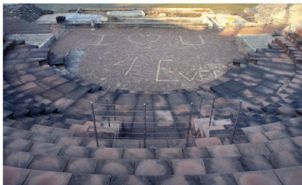
Abb. 21: Augst, Theatersanierung (Grabung 2007.055). Der lockere Splittbelag in der Orchestra – ein Träger wichtiger Botschaften. Blick von Osten aus dem Mittelvomitorium.
