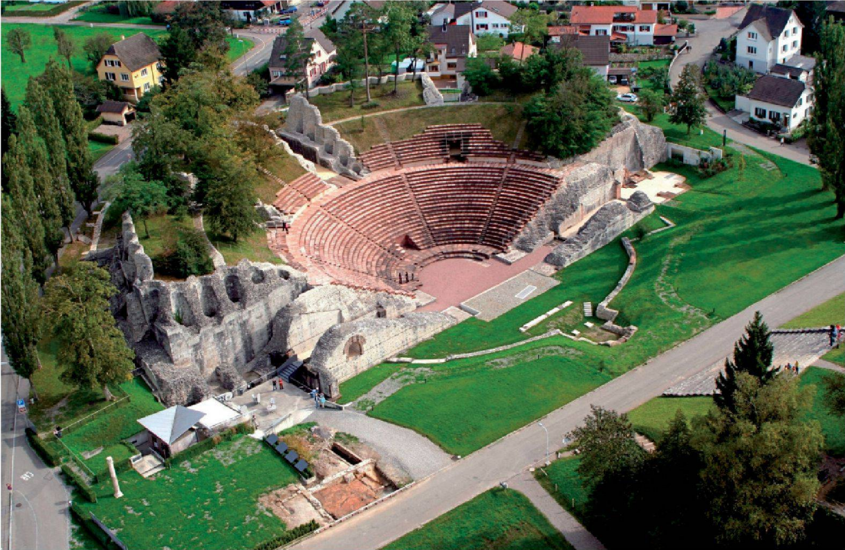
Abb. 1: Augst, Theatersanierung (Grabung 2007.055). Das Augster Theater nach Beendigung der jüngsten Restaurierungskampagne mit rekonstruierten Sitzstufen im ersten und zweiten Rang. Übersicht von Nordwesten.
