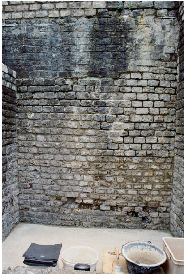
Abb. 28: Augst, Theatersanierung (Grabung 2007.055). Feinsanierung der Mauerchale von MR 55 mit stark durchfeuchtetem Mauerfuss im Bereich zwischen MR 155 und MR 156. Aufnahme nach Abschluss der Maueranierung, vor dem Einbringen der schützenden Kiesanfüllung. Blick von Norden.
