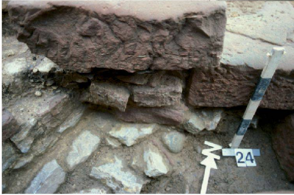
Abb. 7: Augst, Theatersanierung (Grabung 2007.055). Zone westlich des Westcarcers; Ostseite der älteren Mauer aus der Zeit vor den Theaterbauten. Die Situation, wonach der Mauerzug ausgebrochen wurde, um sekundär die Sandsteintreppe einzusetzen, ist gut erkennbar; das Fundament der Mauer zieht eindeutig unter den Treppenstufen durch, das aufgehende Mauerwerk ist gemäss der Unterkante der Treppe abgebrochen. Blick von Süden.
