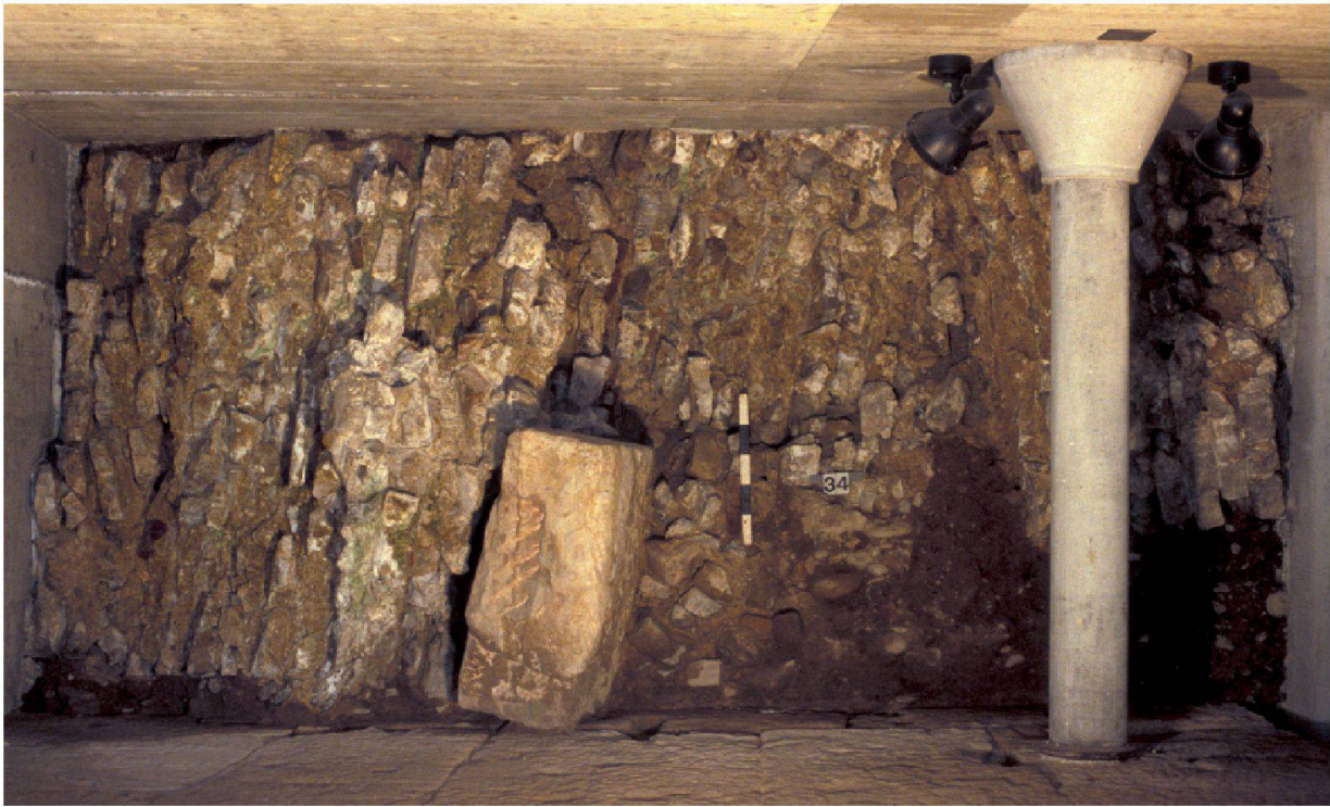
Abb. 9: Augst, Theatersanierung (Grabung 2007.055). Dokumentation von Profil 405; der Profilabschnitt besteht zum grössten Teil aus einem verstürzten opus-vittatum-Mauerkörper. Im Zentrum der grob behauene, massive Buntsandsteinquader, bei dem es sich um einen Keilsteinrohling handeln könnte, dessen weitere Bearbeitung infolge der schlechten Steinqualität aufgegeben wurde. Unmittelbar rechts neben dem Quader loser Schutt und daran anschliessend eine gegen Süden auskeilende Sedimentschicht, deren Entstehung noch ungeklärt ist. Blick von Osten.
