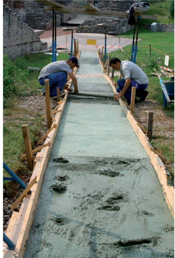
Abb. 24: Augst, Theatersanierung (Grabung 2007.055). Behindertengerechter Zugang zur Orchestra, Übersicht von Nordwesten. Die Ausführung der Rampe durch die Mitarbeiter der Fa. M. Fux AG erfolgte in grünlich eingefärbtem Beton.
