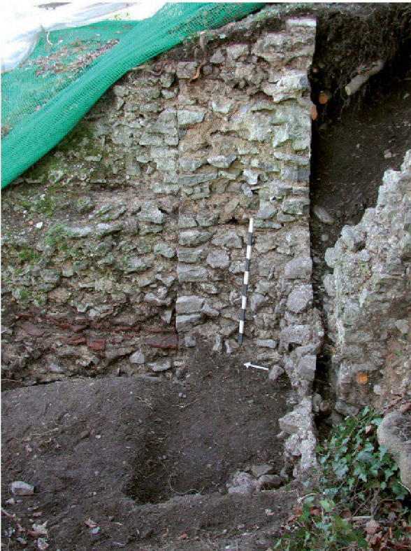
Abb. 8: Augst BL, Schönbühl-Stützpfiler (Grabung 2007.052). Situation nach der Freilegung und Reinigung der noch vorhandenen Mauern. Links der Stützpfiler (die Westseite), in der Mitte von hinten nach vorn durchs Bild laufend die (äussere) Stützmauer der Schönbühl-Tempelplattform, gegen rechts die Westmauer der bisher westlichsten bekannten «Kammer» zwischen der äusseren und der inneren Stützmauer der Plattform. Alle Abrisskanten der Mauern zeigen originales römisches Mauerwerk, das in den vergangenen 70 Jahren schutzlos der Erosion durch Wetter und kletternde Menschen ausgesetzt war. Von Westen.
