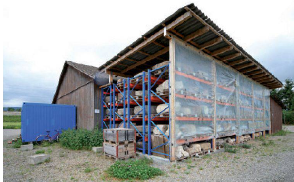
Abb. 25: Augst, Funddepots Schwarzacker. In einem provisorischen «Depot» (Tab. 1,28) für Architekturstücke an der Nordwand des Grosssteinlagers sind die Fundobjekte notdürftig mit Plastikfolie vor Wind und Wetter geschützt.
