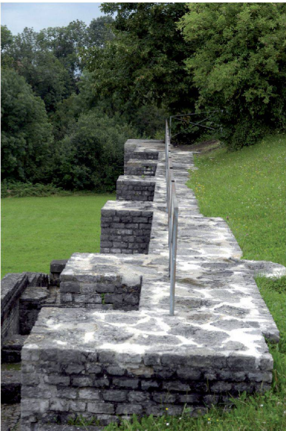
Abb. 94: Augst, Augusta Raurica. Die Krone der Basilica-Nordmauer ist fertig konserviert. Sie muss künftig regelmässig auf Pflanzenwuchs und Frostschäden überprüft werden.
