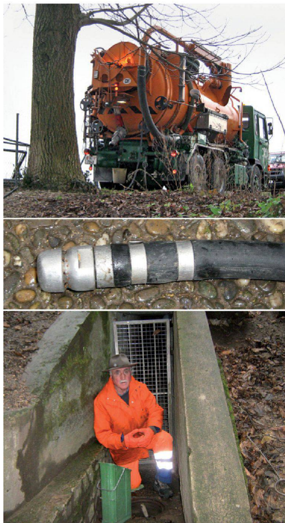
Abb. 115: Augst, Augusta Raurica. Am Ausgang (unten) der römischen Kloake bei den Zentralthermen, wo in römischer Zeit die Abwässer Richtung Violenbach abgeleitet wurden, war die «moderne» Entwässerungsleitung in ihrem Verlauf unbekannt und zudem verstopft. Mit Pumpwagen (oben) und Spezialdüse (Mitte) gelang es, die Leitung wieder freizuschwemmen (s. Abb. 116).
