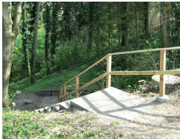
Abb. 116: Augst, Augusta Raurica. Der Ausgang der römischen Kloake, die von den einstigen Zentralthermen etwa 80 m unterirdisch zum Abhang des Violenbachs führte (Bild), ist jetzt wieder trocken und ungefährlich begehbar.
