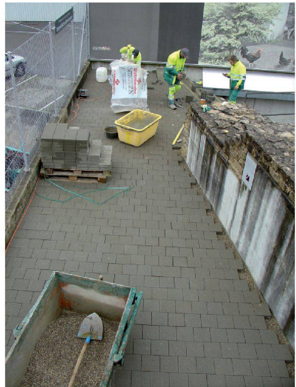
Abb. 100: Augst, Augusta Raurica. Der Splittbelag (Abb. 99) beim Zugang des Unterirdischen Brunnhauses wurde auf Wunsch der Firma E. Frey AG durch Betonsickersteine ersetzt.
