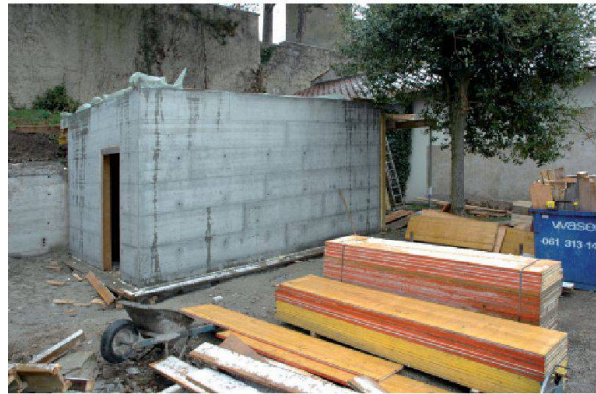
Abb. 102: Augst, Augusta Raurica. Der erste Schritt der Neugestaltung des Lapidariums neben dem Römerhaus (s. Abb. 84) wurde mit dem Rohbau der Toilettenanlage durch die Firma Glanzmann AG realisiert.
