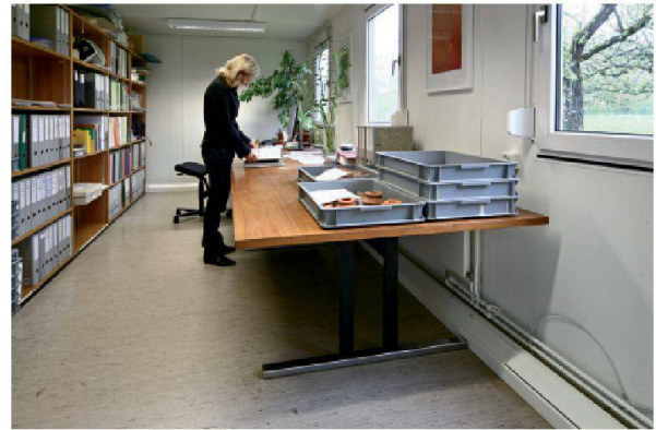
Abb. 19: Arbeitsplatz «Forschungskordinatorin» im selben Bürocontainer: In den Kabelkanälen entlang des Bodens (rechts vorne) führt Ratten- und Mäusekot gelegentlich zu Geruchsbelästigung – ein Job für den Kammerjäger.
