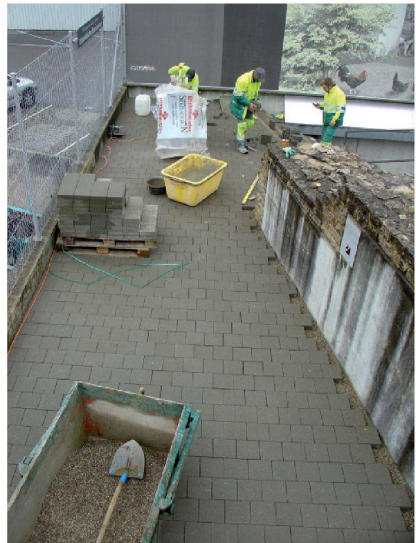
Abb. 100: Augst, Augusta Raurica. Der Splittbelag (Abb. 99) beim Zugang des Unterirdischen Brunnenhauses wurde auf Wunsch der Firma E. Frey AG durch Betonsickersteine ersetzt.
