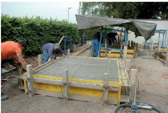
Abb. 103: Augst, Augusta Raurica, Lapidarium beim Römerhaus: Arbeiten an einem der drei neuen Betonsockel.
