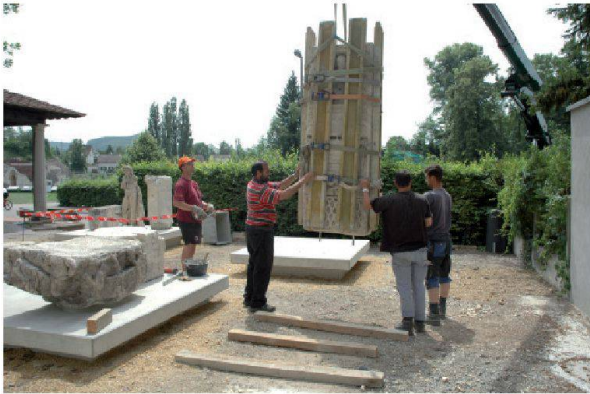
Abb. 101: Augst, Augusta Raurica, Lapidarium beim Römerhaus: Die schwersten und gut «verpackten» Kunststeinabgüsse mussten mithilfe eines Pneu-krans platziert werden.
