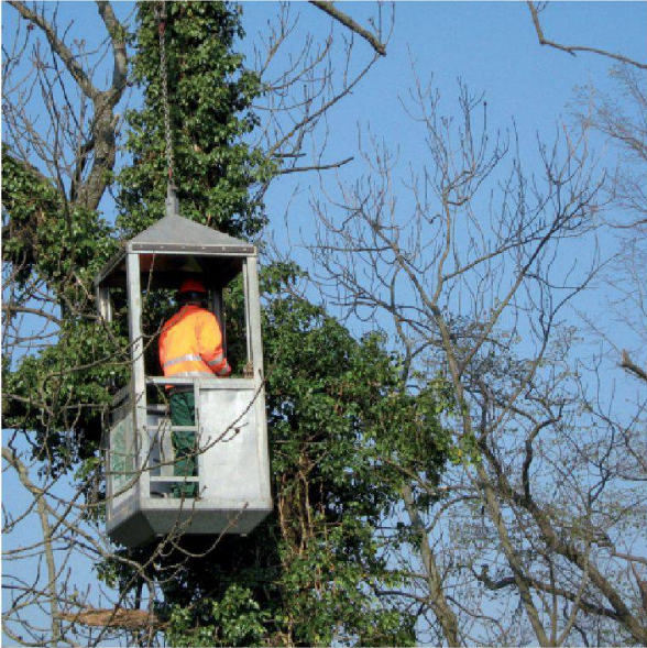
Abb. 107: Augst, Sicherheitsholzung im Theater Augusta Raurica – rationell mit dem Pneukran.
