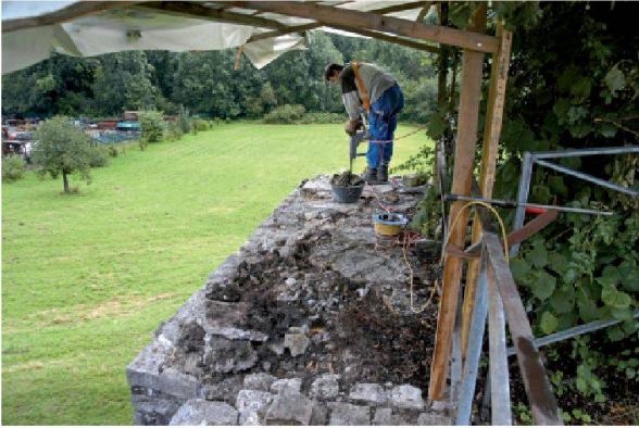
Abb. 92: Augst, Augusta Raurica. Entfernung der defekten Mauerabdeckung und Konservierungsarbeiten auf der Basilica-Nordmauer durch Ismet Muhadini.
