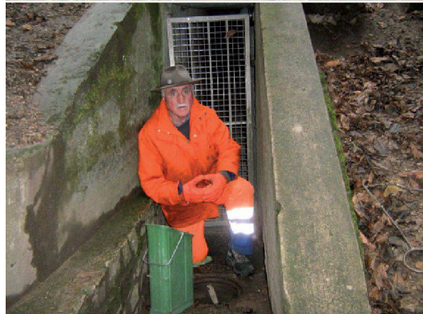
Abb. 115: Augst, Augusta Raurica. Am Ausgang (unten) der römischen Kloake bei den Zentralthermen, wo in römischer Zeit die Abwässer Richtung Violenbach abgeleitet wurden, war die «moderne» Entwässerungsleitung in ihrem Verlauf unbekannt und zudem verstopft. Mit Pumpwagen (oben) und Spezialdüse (Mitte) gelang es, die Leitung wieder freizuschwemmen (s. Abb. 116).
