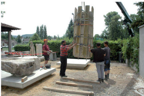
Abb. 101: Augst, Augusta Raurica, Lapidarium beim Römerhaus: Die schweren und gut «verpackten» Kunststeinabgüsse mussten mithilfe eines Pneu-krans platziert werden.
