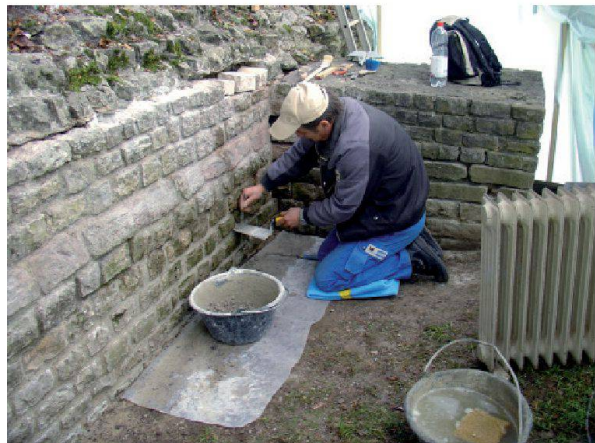
Abb. 96: Augst, Augusta Raurica. Der Sockelbereich der Basilica-Ostmauer wurde neu ausgefugt (im Bild Mladen Puklin von der Firma Markus Fux AG).
