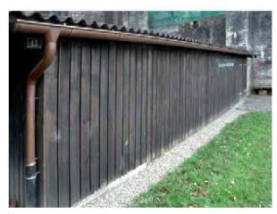
Abb. 61: Augst, Augusta Raurica. Dach der «Römischen Brotbackstube» am Nordfuss des Schönbühls. Eine Regenrinne und eine sanierte Sickeranlage sollen künftig «Überschwemmungen» im Innern des täglich genutzten Workshopgebäudes verhindern.
