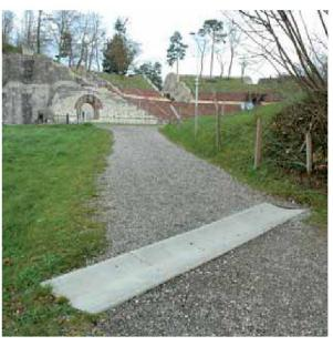
Abb. 62: Augst, Augusta Raurica. Auch der Zugangsweg zur «Römischen Brotbackstube» musste mit einer Regenrinne verbessert werden.
