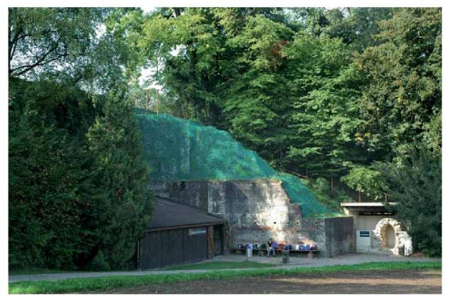
Abb. 52: Augst, Augusta Raurica. Die über 10 m hohe Stützmauer am Fuss des Schönbühl-Tempels ist Anfang des 20. Jahrhunderts restauriert worden. Wegen Einsturzgefahr (s. Abb. 51) mussten Teile davon 2006 provisorisch mit Netzen gesichert werden. Es ist vorgesehen, die Finanzierung zu sichem und diese Gefahrenzone in den nächsten Jahren zu sanieren. Dabei muss auch das Teilstück der römischen Wasserleitung Lausen-Augusta Raurica (rechts) versetzt werden.
