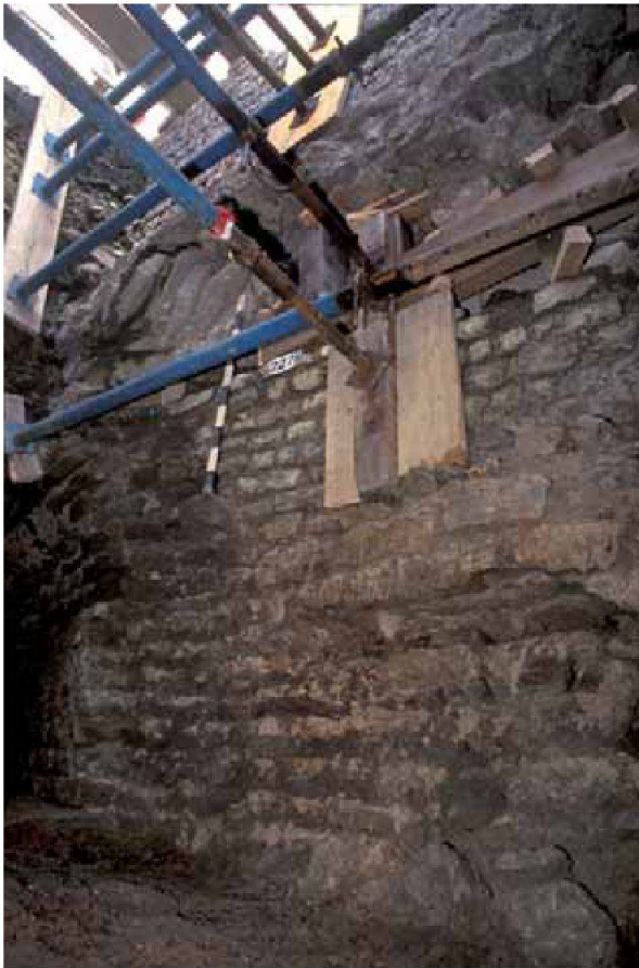
Abb. 12: Augst, Theatersanierung (Grabung 2006.055). Sondierung Feld 250/251; eine komplizierte Spriessung ermöglicht das detaillierte Studium der komplexen mehrphasigen Mauerbefunde.
