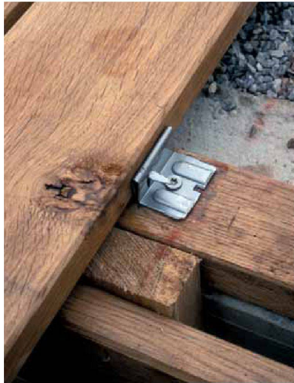
Abb. 9: Augst, Theatersanierung (Grabung 2006.055). Einbau des Bühnenbodens aus Eichenbrettern: Die Domen des Montagesystems «Igel» werden seitlich in das nachfolgende Bodenbrett gedrückt, dadurch dringt weniger Regenwasser in die Hölzer ein und die Lebensdauer des Bodens wird verlängert.
