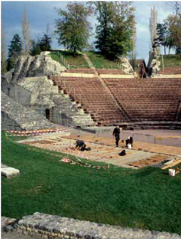
Abb. 8: Augst, Theatersanierung (Grabung 2006.055). Einbau des Bühnenbodens aus Eichenbrettern durch Mitarbeiter der Holzbaufirma K. Graf, Mairsprach.
