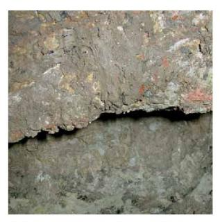
Abb. 24: Kaiseraugst AG, Wacht/Künzli (Grabung 2006.004). Sodbrunnen. Kavernenartige Aushöhlungen.
