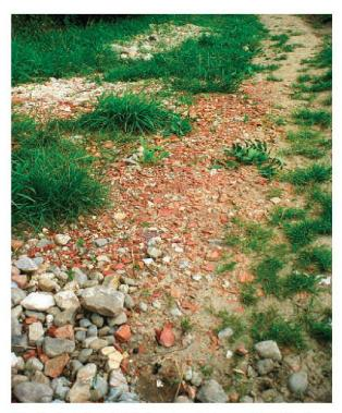
Abb. 28: Ziegelschutt als Befestigung bzw. Drainage auf einem Wanderweg bei Sermuz (VD).
