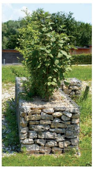
Abb. 19: Augst/BL, Augusta Raurica, Schwarzacker. Prototyp einer Reihe von Drahtkörben, gefüllt mit mauerartig aufgeschichteten Handquadern aus Kalkstein und gefüllt mit Humus und Heckenpflanzen (im Vordergrund: Wolliger Schneeball). In den Körben eingelegte Folien (und gelegentliches Zurückschneiden der Pflanzen) verhindern ein Wurzelwachstum unter die Erdoberfläche in die archäologischen Kulturschichten. Das Bild wurde ein Jahr nach der Anpflanzung im Frühjahr 2006 aufgenommen.
