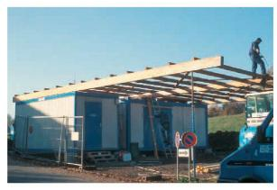
Abb. 55: Augst, Theatersanierung (Grabung 2005.055). Erstellen der redimensionierten, provisorischen Baustelleneinrichtung für die im Jahr 2006 verbleibenden Arbeiten; Aufbau von Büro- und Mannschaftscontainer auf dem Gelände jenseits der modernen Sichelenstrasse.
