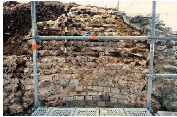
Abb. 40: Augst, Theatersanierung (Grabung 2005.055). Peripherie, Keil 4. Entlastungsbogen MR 138 mit freiliegendem, von Frost und Erosion stark in Mitleidenschaft gezogenem Mauerwerk.
