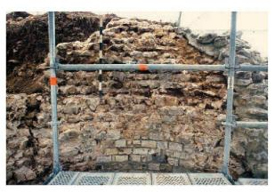
Abb. 40: Augst, Theatersanierung (Grabung 2005.055). Peripherie, Keil 4. Entlastungsbogen MR 138 mit freiliegendem, von Frost und Erosion stark in Mitleidenschaft gezogenem Mauerkern.
