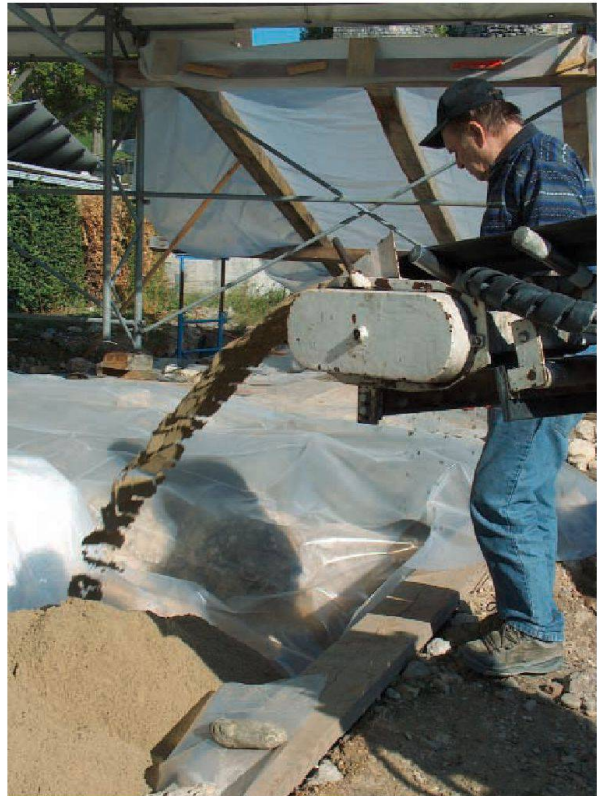
Abb. 51: Augst, Theatersanierung (Grabung 2005.055). Ziegelmosaikboden im nordwestlichen Theater-Vorgelände. Aufbau der provisorischen Wintersicherung, Einbringen der Sandschicht als oberflächlicher Schutz gegen Niederschlagswasser und Wind; zum Einsatz kommt ein Lastwagen mit Förderband der Fa. E. Frey AG, Kaiseraugst.
