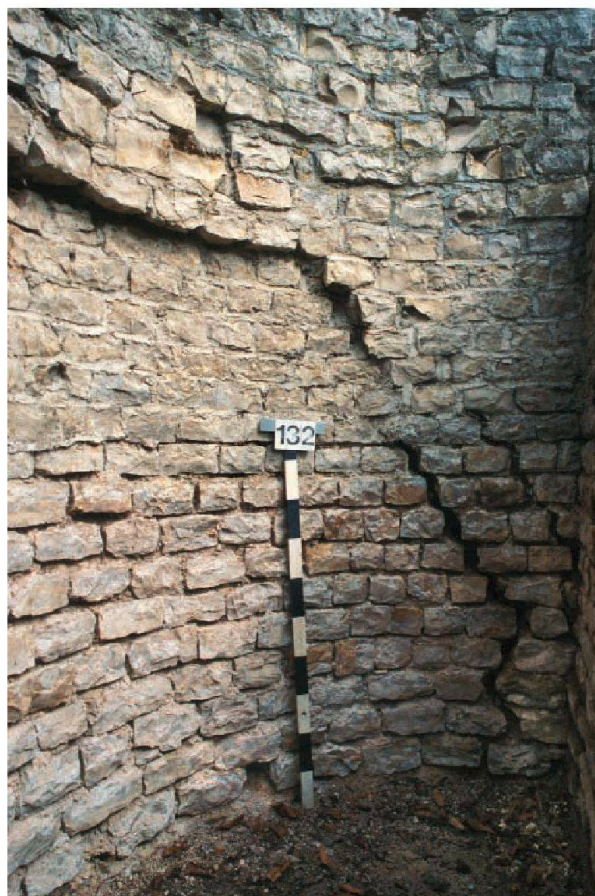
Abb. 38: Augst, Theatersanierung (Grabung 2005.055). Peripherie, Keil 4. Entlastungsbogen MR 140 mit leicht verschobenem, originalem Kalksteinmauerwerk und statisch bedingter Rissbildung in der Mauerschale.
