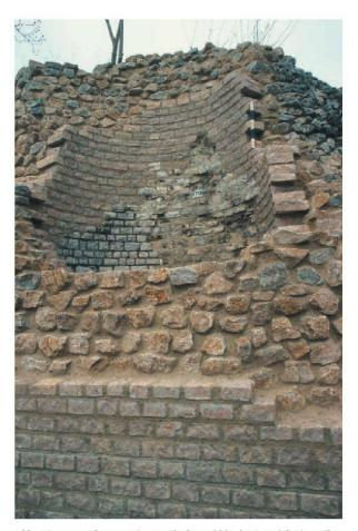
Abb. 41: Augst, Theatersanierung (Grabung 2005.055). Peripherie, Keil 4. Entlastungsbogen MR 138. Einzelne vorgesetzte Blendquader und eine zurückhaltend ausgeführte Übermörtelung des Mauerkerns bieten optimalen Schutz für die originalen Mauerpartien.
