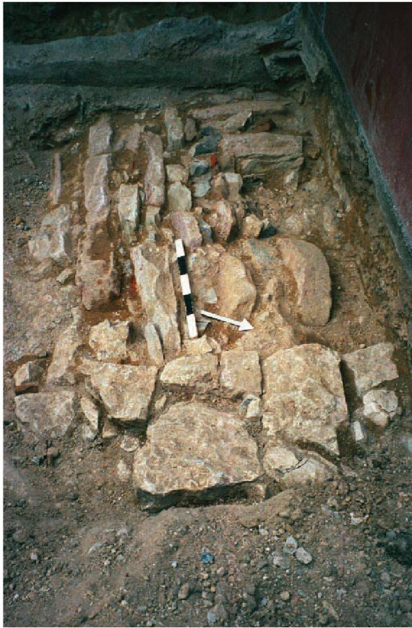
Abb. 22: Augst BL, Gemeindehaus (Grabung 2005.056). Oberseite des Tonnengewölbes MR 3 über dem Zugang zum «Gewölbekeller», vorne MR 4, die ursprünglich als Flankenmauer für die Zugangsrampe zum Tor diente, danach als Abschluss des tunnelartigen neuen Zugangs vom Anbau des Gemeindehauses aus. Im Gewölbe ist ein halbiertes Schleifstein verbaut (rechts Mitte). Von Osten.
