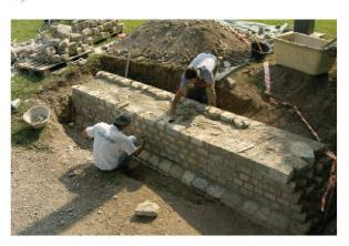
Abb. 59: Augst, Augusta Raurica. Konservierungsarbeiten an der Basilikamauer oberhalb der Curia (Abb. 58) durch Avelino Matos de Cruz (rechts) und Antonio Matos de Cruz.
