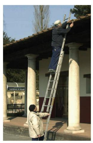
Abb. 69: Augst, Augusta Raurica. Am Römerhausdach müssen im Rahmen des normalen Unterhalts – aber in antiker Weise – die Hohlräume zwischen den untersten Leisten- und Hohlziegeln mit Kalkmörtel ausgefugt werden.
