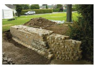
Abb. 60: Augst, Augusta Raurica. Die fertig konservierte Mauer neben der Curia (Abb. 59). Für einen nachhaltigen Schutz ist noch eine partielle Humusabdeckung mit dichtem Grasbewuchs erforderlich (vgl. Abb. 58).
