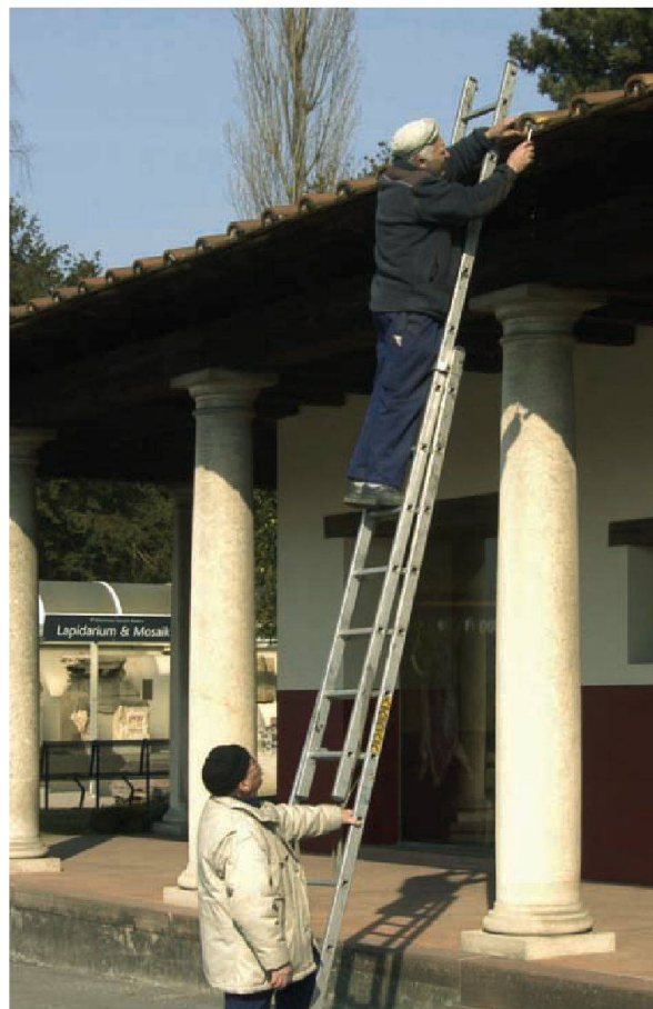
Abb. 69: Augst, Augusta Raurica. Am Römerhausdach müssen im Rahmen des normalen Unterhalts – aber in antiker Weise – die Hohlräume zwischen den untersten Leisten- und Holzriegeln mit Kalkmörtel ausgefügt werden.
