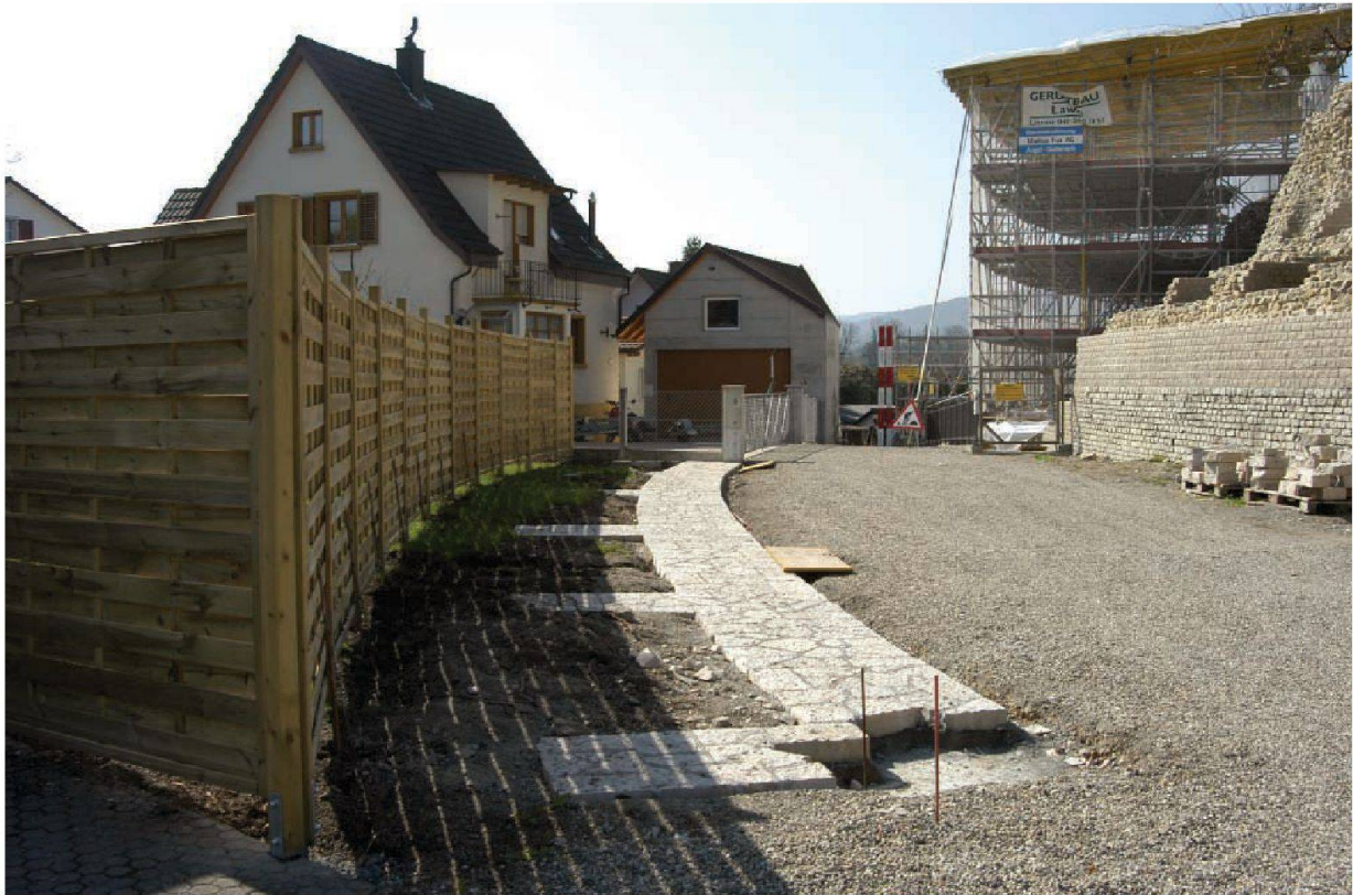
Abb. 67: Augst, Augusta Raurica, Theatersanierung. Rechts das letzte grosse Baugerüst der mehrjährigen Konservierungsarbeiten, von welchem aus die Maurerarbeiten an der Peripherie von Keil 4 ausgeführt werden konnten. Im Vordergrund ist der Grundriss des Ersten Theaters im Boden markiert, hier konkret die Peripheriemauer mit kleinen Strebepfeilern in kurzen Abständen. Links im Bild die neu erstellte Sichtschutzwand gegen einen Privatgarten. Dank der Grundeigentümerin, der Stiftung Pro Augusta Raurica, konnte die alte Hecke mit Gartenmauer über dem Theaterbefund entfernt und der neue Zaun einige Meter innerhalb der Parzelle errichtet werden. So haben die Besucher ein einprägsames Gesamtbild vom Grundriss des ältesten Theaters von Augusta Raurica.
