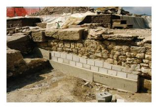
Abb. 63: Augst, Augusta Raurica, Insula 27. Die mit einem Betonfundament und modernen Zementbacksteinen unterfangene Mauer 11 (Abb. 62). Nach Wiederherstellung des Gehniveaus des 3. Jahrhunderts n. Chr. sind nur noch die einst überirdischen «aufgehenden» Mauerteile mit den imposanten Schwellsteinen sichtbar.
