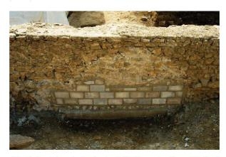
Abb. 64: Augst, Augusta Raurica, Insula 27. Eine andere Mauer (MR 9) mit ähnlicher Konsolidierung des erhaltungsbedingt ausgebrochenen Fundaments mittels moderner Zementbacksteine. Diese werden zwar nicht sichtbar sein, können aber jederzeit vom römischen Original unterschieden werden.
