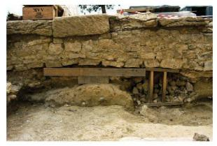
Abb. 62: Augst, Augusta Raurica, Insula 27. Eine der im Fundamentbereich ausgebrochenen und provisorisch gestützten römischen Mauern (MR 11) vor ihrer Reparatur und Konservierung (vgl. Abb. 63).
