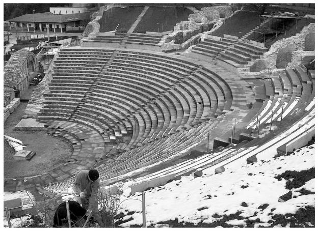
Abb. 23: Augst, Theatersanierung (Grabung 2004.055). Rekonstruktion des Sitzstufenbereichs: Im frisch mit Erde angeböschten Bereich des zweiten Sitzstufenrangs zeichnen sich die Stimbretter der Treppenläufe, die im oberen, nicht mit Sitzstufenkörben rekonstruierten Teil von Rang 2 provisorisch erscheinen sollen, noch überdeutlich ab. Blick von Osten.
