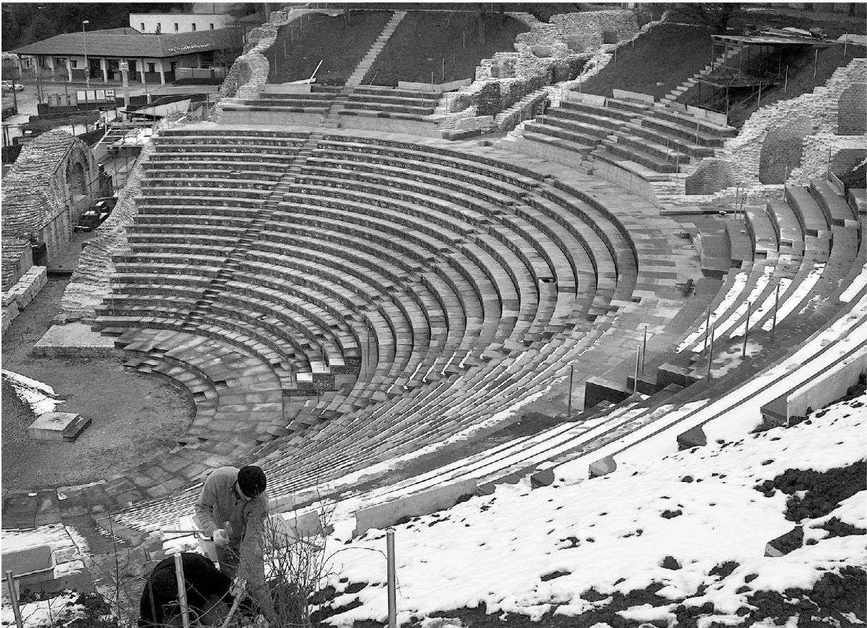
Abb. 23: Augst, Theatersanierung (Grabung 2004.055). Rekonstruktion des Sitzstufenbereichs: Im frisch mit Erde angeböschten Bereich des zweiten Sitzstufenrangs zeichnen sich die Stimmbretter der Treppenläufe, die im oberen, nicht mit Sitzstufenkörben rekonstruierten Teil von Rang 2 provisorisch erscheinen sollen, noch überdeutlich ab. Blick von Osten.
