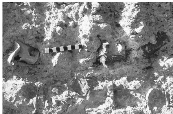
Abb. 35: Augst, Theatersanierung (Grabung 2004.055). Peripheriebereich Keil 3 (MR 58), Arbeitsstand vor Beginn der Aufmauerungsarbeiten: In dem aus den 1940er Jahren stammenden Mauerwerk wurden sogar leere Konservendosen vermauert.
