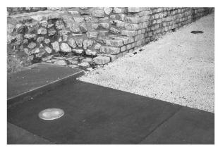
Abb. 30: Augst, Theatersanierung (Grabung 2004.055). Ausgestaltung der Bodenbeläge, Mittelvomitorium: Die Bodenlampen sind in die Bodenbeläge integriert. Blick vom Diazoma-Umgang gegen Nordosten.
