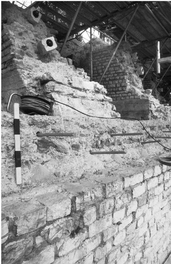
Abb. 36: Augst, Theatersanierung (Grabung 2004.055). Peripheriebereich Keil 3 (MR 58): Ins Mauerwerk eingebaute Glasfaseranker und -dübel garantieren die Verbindung zwischen dem bestehenden Mauerkörper und den Vor- und Aufmauerungen der aktuellen Sanierungskampagne.
