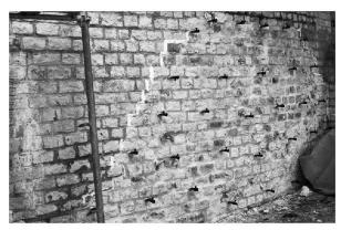
Abb. 44: Augst, Theatersanierung (Grabung 2004.055). Peripheriebereich Keil 4 (MR 58): Nach der Feinsanierung der Mauerschale mit dem rot bemalten Fugenstrich und dem Abdichten möglicher Austrittsöffnungen wurden die Packer zum Einbringen des Injektionsmörtels gesetzt. Der Raster zum Setzen der Packer wurde durch die Erhaltungsgrenzen der antiken Fugmörtelpartien bestimmt. Blick von Süden, im Hintergrund Pfeiler MR 195.
