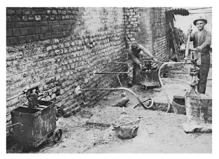
Abb. 22: Augst, Theatersanierung (Grabung 1934.059). Grundlagen zur Erarbeitung eines Auswertungskonzepts. Injektionsarbeiten an den Mauern des Südaditus im Jahre 1934; Einbringen von Portlandzementmasse mit der Handpumpe unter niedrigem Druck.
