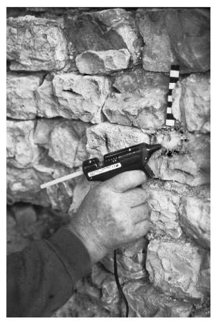
Abb. 39: Augst, Theatersanierung (Grabung 2004.055). Peripheriebereich Keil 3, Mauerinnenschale des Entlastungsbogens MR 131. Detail der Feinrestaurierung von Mauerschalen: Vor dem Ausinjizieren von Haarrissen in den Muschelkalkquadern der Mauerschale mit einem Injektionsharz werden mögliche Flüssigkeitsaustritte mit einem Heisssiegelkleber abgedichtet. Maurer Max Heid mit der Klebepistole.
