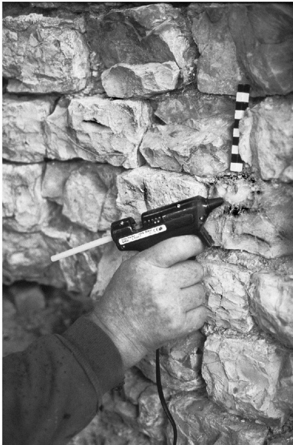
Abb. 39: Augst, Theatersanierung (Grabung 2004.055). Peripheriebereich Keil 3, Mauerinnenschale des Entlastungsbogens MR 131. Detail der Feinrestauration von Mauerschalen: Vor dem Ausinjizieren von Haarrissen in den Muschelkalkquadern der Mauerschale mit einem Injektionsharz werden mögliche Flüssigkeitsaustritte mit einem Heissiegelkleber abgedichtet. Maurer Max Heid mit der Klebepistole.
