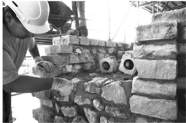
Abb. 37: Augst, Theatersanierung (Grabung 2004.055). Peripheriebereich Keil 3 (MR 58): Die Schraubenmutter der Glasfaseranker werden in den Mauerkern integriert. Maurer Agim Delija beim Erstellen der neuen Kernvor-mauerung.
