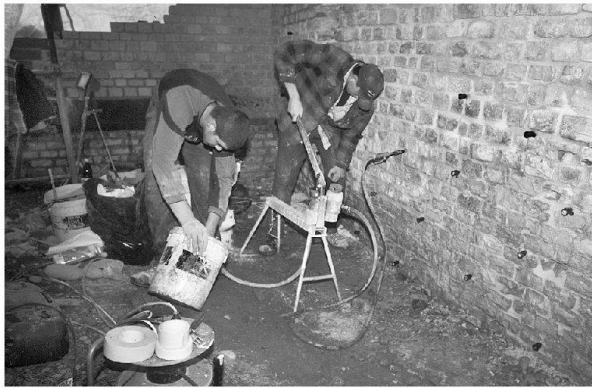
Abb. 47: Augst, Theatersanierung (Grabung 2004.055). Peripheriebereich Keil 4 (MR 58): Einpumpen des Injektionsmörtels in die Mauerkluff; an der Handkolbenpumpe arbeiten Dominik Fux und Mubekir Hajrizi. Blick von Osten, im Hintergrund Pfeiler MR 196.
