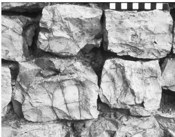
Abb. 41: Augst, Theatersanierung (Grabung 2004.055). Peripheriebereich Keil 3, Mauerinnenschale des Entlastungsbogens MR 131. Die Feinsanierung der Schalenquäderchen ist abgeschlossen und der zum Abdichten verwendete Heissiegelkleber wurde von den Steinen abgezogen; die Mauerpartie ist zum Verfugen bereit.
