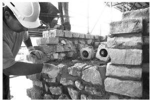
Abb. 37: Augst, Theatersanierung (Grabung 2004.055). Peripheriebereich Keil 3 (MR 58): Die Schraubenmuttern der Glasfaseranker werden in den Mauerkern integriert. Maurer Agim Delija beim Erstellen der neuen Kernvormauerung.
