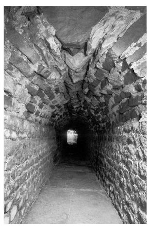
Abb. 19: Augst, Theatersanierung (Grabung 2000.055). Grundlagen zur Erarbeitung eines Auswertungskonzepts. Abwasserkanal auf dem Gelände des Theaters; nördlicher Abschnitt mit Wangen aus opus vittatum-Mauerwerk und über Holzschalung errichtetem Gewölbe.
