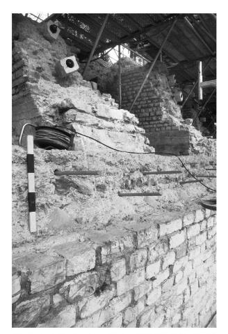
Abb. 36: Augst, Theatersanierung (Grabung 2004.055). Peripheriebereich Keil 3 (MR 58): Ins Mauerwerk eingebohrte Glasfaseranker und -dübel garantieren die Verbindung zwischen dem bestehenden Mauerkörper und den Vor- und Aufmauerungen der aktuellen Sanierungskampagne.
