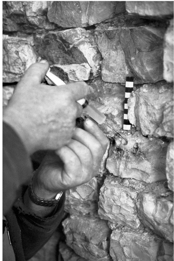
Abb. 40: Augst, Theatersanierung (Grabung 2004.055). Peripheriebereich Keil 3, Mauerinnenschale des Entlastungsbogens MR 131. Detail der Feinrestauration von Mauerschalen: Mit einer Spritze wird das Injektionsharz durch den ebenfalls mit dem Heissiegelkleber ausgebildeten «Trichter» in die Haarrisse eines Schalenquaders gepresst.
