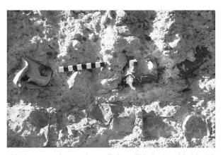
Abb. 35: Augst, Theatersanierung (Grabung 2004.055). Peripheriebereich Keil 3 (MR 58), Arbeitsstand vor Beginn der Aufmauerungsarbeiten: In dem aus den 1940er Jahren stammenden Mauerkern wurden sogar leere Konservendosen vermauert.
