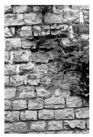
Abb. 21: Augst, Theatersanierung (Grabung 1995.055). Grundlagen zur Erarbeitung eines Auswertungskonzepts. Typisches Schadensbild am Mauerwerk des jüngeren szenischen Theaters; entstanden durch Frostsprengungen und wild wuchernden Pflanzenbewuchs.
