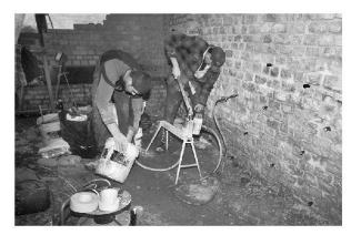
Abb. 47: Augst, Theatersanierung (Grabung 2004.055). Peripheriebereich Keil 4 (MR 58): Einpumpen des Injektionsmörtels in die Mauerkluft; an der Handkolbenpumpe arbeiten Dominik Fux und Mubekir Hajrizi. Blick von Osten, im Hintergrund Pfeiler MR 196.
