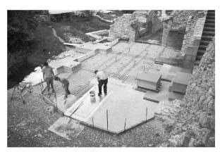
Abb. 28: Augst, Theatersanierung (Grabung 2004.055). Ausgestaltung der Bodenbeläge: Einbringen des hellen Bodenbelags im Bereich der ehemals durch ein Tonnengewölbe überspannten Südhalle. Zur Stabilisierung wird im Bodenbelag ein leichtes Eisennetz eingelegt. Übersicht von Südosten.
