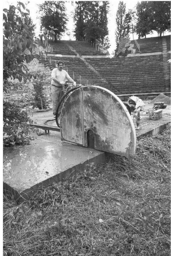
Abb. 48: Augst, Theatersanierung (Grabung 2004.055). Orchesterbereich: Durch die Firma Stark-Betonbohren, CH-4133 Pratteln, wird die Betonplatte des Kranfundaments mittels eines riesigen Fräsblattes zu Stücken von 1,5 Tonnen Gewicht zersägt.
