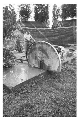
Abb. 48: Augst, Theatersanierung (Grabung 2004.055). Orchestrabereich: Durch die Firma Stark-Betonbohren, CH-4133 Pratteln, wird die Betonplatte des Kranfundaments mittels eines riesigen Fräsblattes zu Stücken von 1,5 Tonnen Gewicht zersägt.
