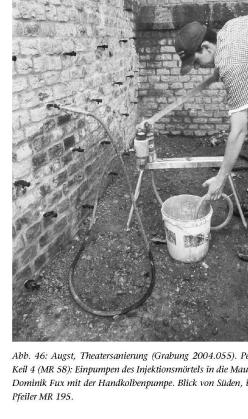
Abb. 46: Augst, Theatersanierung (Grabung 2004.055). Peripheriebereich Keil 4 (MR 58): Einpumpen des Injektionsmörtels in die Mauerkluft; Maurer Dominik Fux mit der Handkolbenpumpe. Blick von Süden, im Hintergrund
