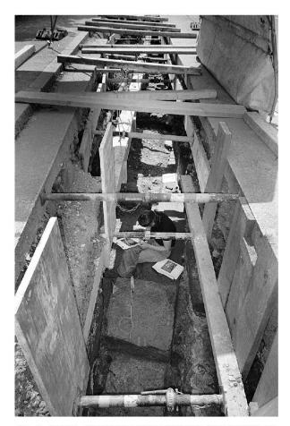
Abb. 6: Augst BL, Wasserleitung Giebenacherstrasse (Grabung 2003.51). Spriessungen, ein schmaler Graben, eine schleifend geschnittene Mauer und irgendwo zwischendrin die Archäologin (Barbara Pfäffli) am Dokumentieren – Alltag einer Leitungsgrabung.
