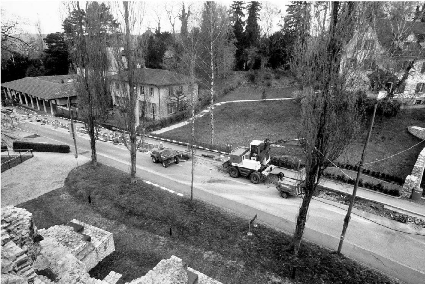
Abb. 3: Augst BL, Wasserleitung Giebenacherstrasse (Grabung 2003.51). Aushubarbeiten in der ersten Etappe, vom Römermuseum (links oben) bis zur Einmündung des modernen Basilicawegs. Von Südosten, vom zweiten Rang des Theaters aus aufgenommen.
