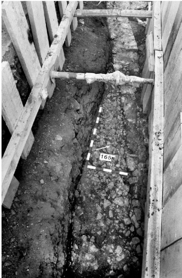
Abb. 16: Augst BL, Wasserleitung Giebenacherstrasse (Grabung 2003.51). Links die oberste erhaltene Kiesschicht der Neuntürmestrasse, danach Mauer MR 11, die Portikus- oder Aussenmauer von Insula 9, rechts die Innenseite der Insula. Von Osten.
