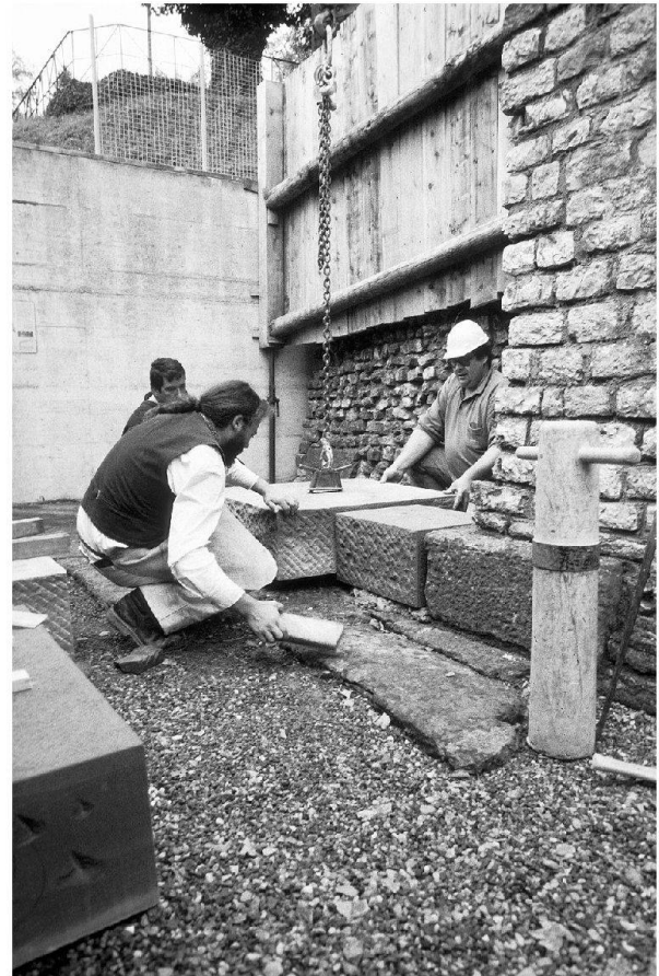
Abb. 7 und 8: Augst, Augusta Raurica. Markus Horisberger (mit Brille) mit seinem Steinmetzteam bei der Theatersanierung: links an einem der nördlichen Stützpfiler, rechts am Fusse der hohen Caveamauer in der nördlichen Zugangshalle. Zum Versetzen schwerer Sandsteinquader hat er eine moderne Version des «Wolfs» entwickelt, ein Stahlanker zum Einhängen des Kranhakens, welcher einfach mit zwei divergierenden Bohrlöchern anzubringen und rasch wieder zu entfernen ist.
