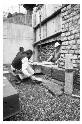
Abb. 7 und 8: Augst, Augusta Raurica. Markus Horisberger (mit Brille) mit seinem Steinmetzteam bei der Theatersanierung: links an einem der nördlichen Stützpfeiler, rechts am Fusse der hohen Caveamauer in der nördlichen Zugangshalle. Zum Versetzen schwerer Sandsteinquader hat er eine moderne Version des «Wolfs» entwickelt, ein Stahlanker zum Einhängen des Kranhakens, welcher einfach mit zwei divergierenden Bohrlöchern anzubringen und rasch wieder zu entfernen ist.
