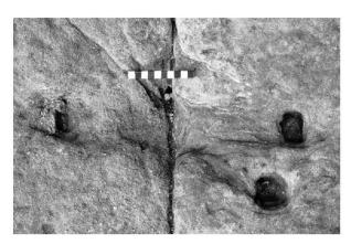
Abb. 5: Augst, Augusta Raurica, Theatersanierung. Detail zweier Fundamentquader aus Buntsandstein (Mauer 236, Südhalle des Dritten [Szenischen] Theaters) mit der Vertiefung für eine (herausgerissene!) eiserne Verbindungsklammer. Im Block links ist die Verbleiung verblieben (= Kat. 2). Das breitere Loch unten rechts ist wohl ein Stemm- und sicher kein Klammerloch. M. ca. 1:6.
