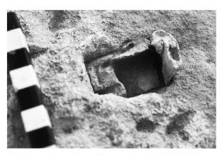
Abb. 4: Augst, Augusta Raurica, Theatersanierung. Detail der Bauklammer-Verbleiung in einem Gurtquader aus Buntsandstein des Dritten (Szenischen) Theaters (Abb. 3; Verbleiung = Kat. 1). M. ca. 3:4.
