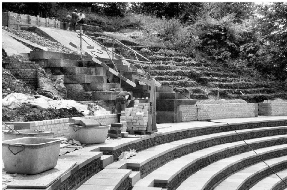
Abb. 23: Augst, Theatersanierung (Grabung 2003.55). Rekonstruktion der Sitzstufen im ersten Rang. Aufmauern der Gürtelmauer der ersten praecinctio.
