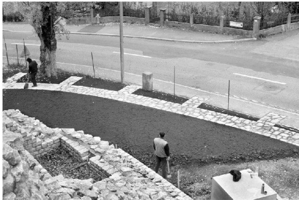
Abb. 38: Augst, Theatersanierung (Grabung 2003.55). Umgebungsgestaltung. Fertiggestellte Umgebung in Keil 2. Die bodenebene Kalksteinmarkierung der Umfassungsmauer des älteren szenischen Theaters ist in dieser Zone bereits ausgeführt; ebenso konnten die Geländearbeiten und das Einbringen des Schotterrasens für die Gehwege abgeschlossen werden. Blick vom Keil 2 nach Norden.
