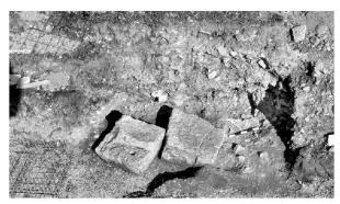
Abb. 16: Augst, Theatersanierung (Grabung 2003.55). Sitzstufen, zweiter Rang – Keil 2. Zwei originale Buntsandsteinquader mit rudimentärem Spitzhiebbehau in der antiken Verfüllung des oberen Sitzstufenrangs. Vermutlich wurden die Quader während der Bauzeit in der Auffüllung entsorgt, weil sich im Verlauf der Bearbeitung herausstellte, dass sie nicht von ausreichender Steinqualität waren (diverse Lehmeinschlüsse und -lager).
