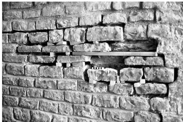
Abb. 36: Augst, Theatersanierung (Grabung 2003.55). Sanierung originaler Mauerschalen. Retten, was noch zu retten ist. Soweit möglich und vom Aufwand her vertretbar, wurden die originalen Ziegelplatten wieder zusammengeklebt. In einzelnen Fällen waren die Ziegel durch Frostsprengung und Salze allerdings derart zerstört, dass neue Blender vor die Überreste der Originale gesetzt werden mussten.
