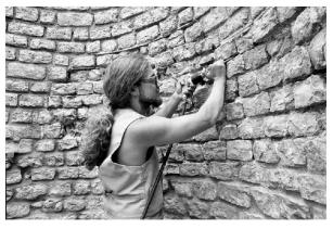
Abb. 34: Augst, Theatersanierung (Grabung 2003.55). Sanierung originaler Mauerschalen. Steinbildhauer Flavian Naber bei Konservierungsarbeiten an einem der Entlastungsbögen der Peripherie von Keil 1. Nach dem Ausspitzen der bei neuzeitlichen Restaurierungen angebrachten, harten Fugen aus Portlandzement werden vorhandene Frostschäden am Kalksteinmauerwerk repariert. Danach muss das Mauerwerk mit einem «weicheren» Restauriermörtel neu verfugt werden.
