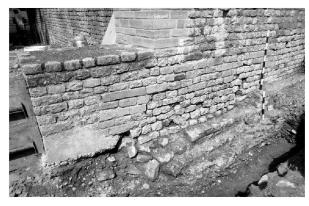
Abb. 14: Augst, Theatersanierung (Grabung 2003.55). Schwellensituation des Mittelvomitoriums. Innere Peripheriemauer 55 mit den darunter liegenden Mauern einer älteren Bauphase, wohl des älteren szenischen Theaters.
