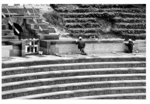
Abb. 24: Augst, Theatersanierung (Grabung 2003.55). Rekonstruktion der Sitzstufen im ersten Rang. Versetzen der Sandsteinabdeckung über der Gürtelmauer der ersten praecinctio.
