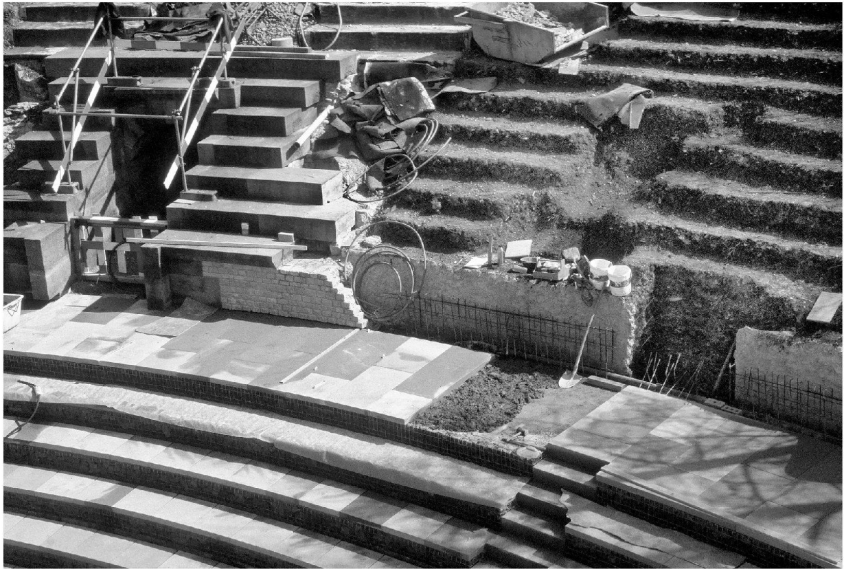
Abb. 21: Augst, Theatersanierung (Grabung 2003.55). Rekonstruktion der Sitzstufen im ersten Rang. Versetzen des Plattenbelags des Diazoma-Umgangs (Umgang der ersten praecinctio).
