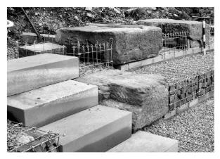
Abb. 28: Augst, Theatersanierung (Grabung 2003.55). Rekonstruktion der Sitzstufen im zweiten Rang. Detail der Aufbauarbeiten in Keil 3. Aus didaktischen Gründen erfolgte eine Integration von drei originalen Sitzstufenquadem aus Buntsandstein in die moderne Gitterkorbkonstruktion.
