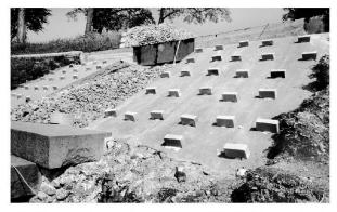
Abb. 30: Augst, Theatersanierung (Grabung 2003.55). Rekonstruktion der Sitzstufen im zweiten Rang. Zone der Betonüberwölbung des Südost-Vomitoriums; Unterkonstruktion als Sicherung gegen das Abrutschen der darüber folgenden 28° steilen Erdböschung.
