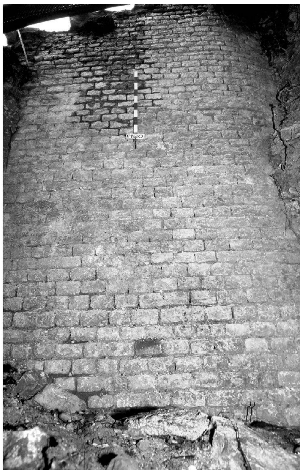
Abb. 19: Augst, Theatersanierung (Grabung 2003.55). Einsturztrichter im zweiten Rang – Keil 1. Ansicht an die östliche, sorgfältig aus Muschelkalk-Handquadern gefügte Mauerschale von MR 65.
