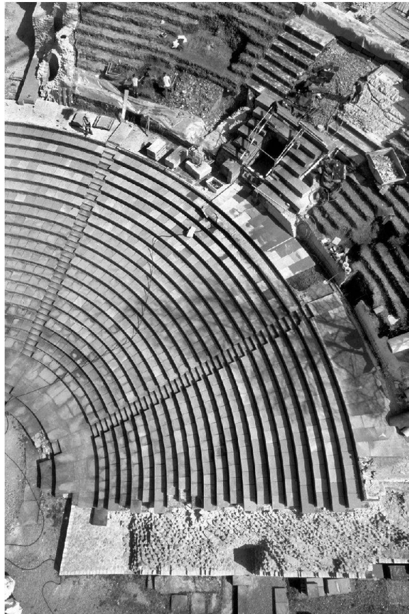
Abb. 20: Augst, Theatersanierung (Grabung 2003.55). Rekonstruktion des Sitzstufenbereichs. Aufsicht auf die Südhälfte während der Versetzarbeiten für die Platten des so genannten Diazoma-Umgangs (Umgang der ersten praecinctio).
