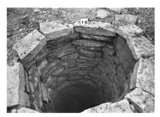
Abb. 21: Kaiseraugst AG, Überbauung Schürmatt 2. Etappe, Friedhofstrasse (2003.06). Südlicher Keller: Schacht aus Kalksteinplatten.
