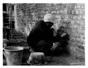
Abb. 41: Augst, Theatersanierung (Grabung 2002.55). Sanierungsarbeiten an der Peripherie von Keil 2. Arbeiter Salim Leghdemsi beim Neuverfugen der Mauerschalen.
