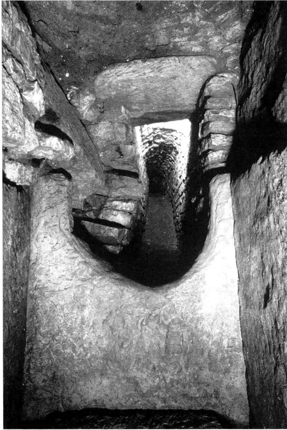
Abb. 24: Augst, Theatersanierung (Grabung 2002.55). Abwasserkanal, Verzweigung im Süden, südöstlicher Abschnitt mit Sandsteinkammer. Blick von Nordwesten, von der Sandsteinkammer aus in den südöstlichen Fortsetzungskanal. Im Zentrum die U-förmig ausgehauene Mündung; in der oberen Bildhälfte der Sandsteinarchitrav mit dem Entlastungsbogen aus Buntsandsteinkeilen (vgl. Abb. 27). Links der verstürzte Sandsteinarchitrav des von den Frauenthermen her kommenden, nordöstlichen Seitenkanals (vgl. Abb. 29).
