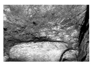
Abb. 27: Augst, Theatersanierung (Grabung 2002.55). Abwasserkanal, Verzweigung im Süden, südöstlicher Abschnitt mit Sandsteinkammer. Blick von Nordwesten an die Südostwand der Sandsteinkammer. Detail des oberen Wandabschlusses mit Sandsteinarchitrav der Mündung des südöstlichen Fortsetzungskanals und darüber liegendem Entlastungsbogen aus Buntsandsteinkeilen (und einem Ziegelkeil).
