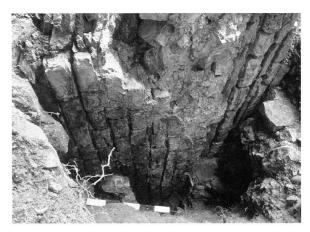
Abb. 3: Augst, Theatersanierung (Grabung 2002.55). Blendbogen der südlichen Eingangshalle. Ansicht an die im Befund untere Mauerschale des abgestürzten Mauerblocks mit Blendbogenrest und bogenförmig verlaufender Mörtelbraue. Zustand während der Freilegung.
