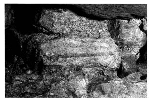
Abb. 26: Augst, Theatersanierung (Grabung 2002.55). Abwasserkanal, Verzweigung im Süden, südöstlicher Abschnitt mit Sandsteinkammer. Detail des Kalksteingewölbes des südöstlichen Fortsetzungskanals mit im Scheitelbereich als Spolie verbautem Architekturstück aus kreidigem Korallenkalk (Bekrönung eines kleinen Pfeilers oder Pilasters oder oberer Abschluss eines kleinen Kalksteinaltars).
