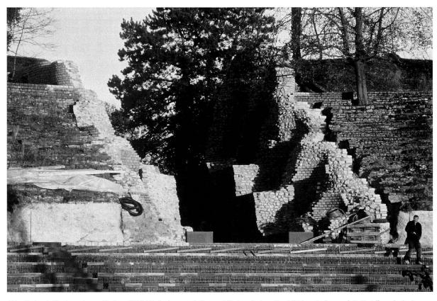
Abb. 40: Augst, Theatersanierung (Grabung 2002.55). Sanierungsarbeiten am Mittelvomitorium. Das Mittelvomitorium nach Fertigstellung der Sanierungsarbeiten von 2002. Die Wangenmauern und die Entlastungsbögen sind restauriert und wo nötig repariert. Die stark zerstörten modernen Kernvormauerungen in den oberen Bereichen wurden erneuert. Im Mündungsbereich zur cavea wurde die unterste Sandsteinquaderlage gemäss den im Baubefund erhaltenen Hinweisen ergänzt.
