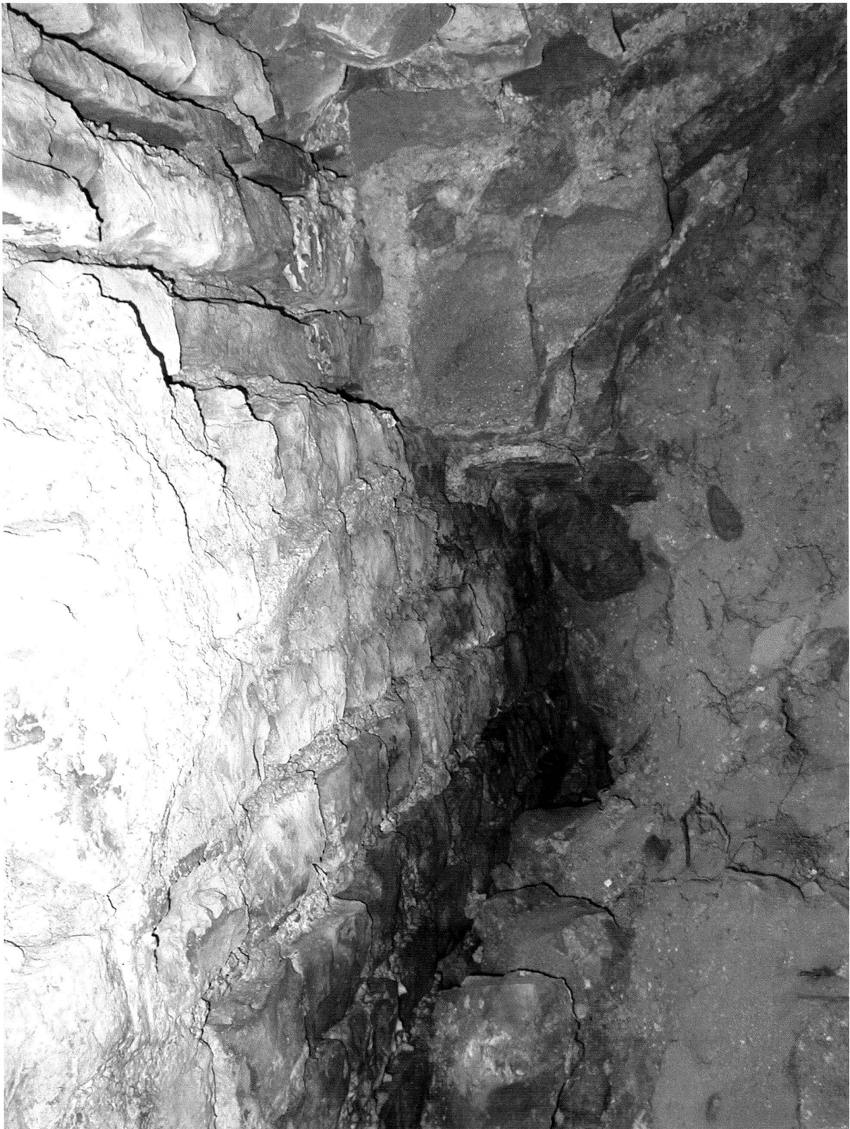
Abb. 7: Augst, Theatersanierung (Grabung 2002.55). Blendbogen der südlichen Eingangshalle. Die Abbildung gibt die Lage des Blendbogens in seinem ursprünglichen baulichen Zusammenhang wieder. Deutlich erkennbar ist die bogenförmig verlaufende Mörtelbraue am Übergang von der Nischenrückwand zur inneren Leibung des Buntsandsteinbogens. Im Zentrum der Verputzrest mit der aufgemalten Sandsteinquaderimitation (vgl. Abb. 8). Korrespondierend mit dem Scheitel der Innenleibung des Bogens ist ein 8–10 cm starker Rücksprung im opus vittatum-Mauerwerk der Nischenrückwand erkennbar. Die Quaderlagen über dem Rücksprung weisen eine geringere Stärke und einen deutlich höheren Anteil an Buntsandsteinquaderchen auf als die auf Sicht gemauerte, mit rot bemaltem Fugenstrich versehene Schale unterhalb des Rücksprungs.
