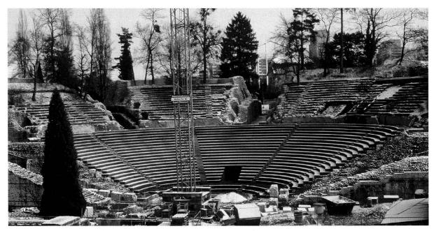
Abb. 34: Augst, Theatersanierung (Grabung 2002.55). Fertig gestellte Rekonstruktion der Sitzstufen im ersten Rang. Gut erkennbar die vier radialen Treppenläufe und die zentral gelegene Nische im Anschluss an den Prohedrie-Umgang.
