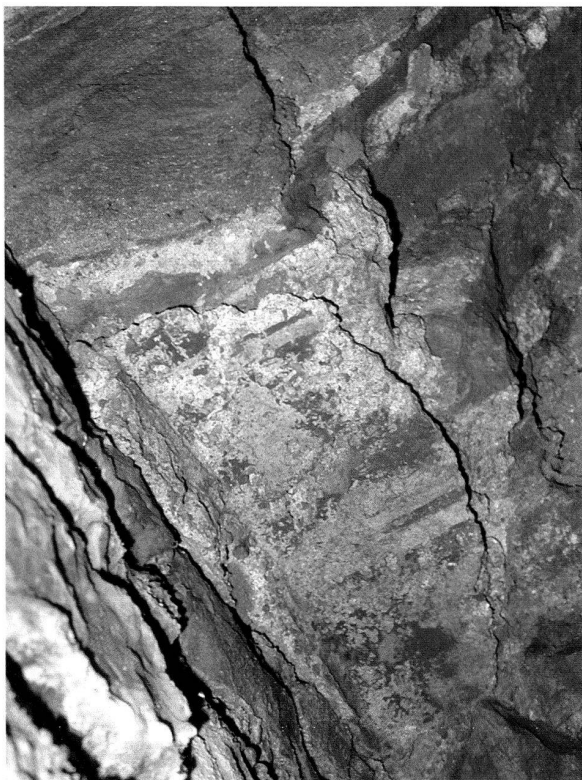
Abb. 8: Augst, Theatersanierung (Grabung 2002.55). Blindbogen der südlichen Eingangshalle. Erhalten gebliebener Verputzrest an der Innenleibung des Sandsteinbogens (zur Lage vgl. Abb. 7). Die Bemalung des Verputzes imitiert einen Werksteinbogen aus Buntsandstein, dessen Keilsteine durch rot bemalte Fugen voneinander abgesetzt sind.
