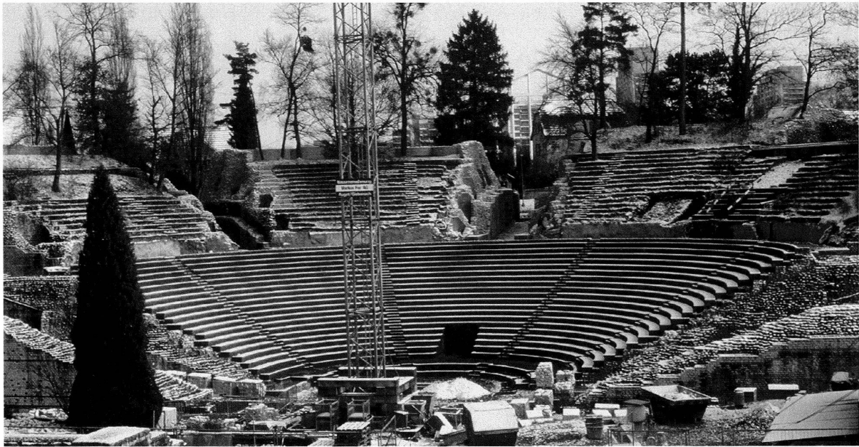
Abb. 34: Augst, Theatersanierung (Grabung 2002.55). Fertig gestellte Rekonstruktion der Sitzstufen im ersten Rang. Gut erkennbar die vier radialen Treppenhänge und die zentral gelegene Nische im Anschluss an den Prohedrie-Umgang.
