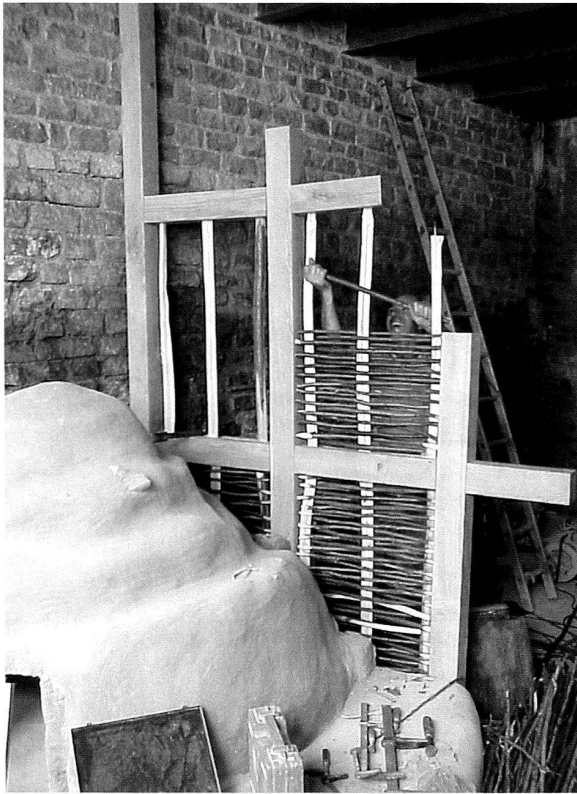
Abb. 42: Augst, Gebäude zwischen der Insula 9 und dem Theater. Konservierung «Bäckerei» und «Wachposten» (2002.907). Rolf Fischler beim Flechten der Lehmfachwerkwand.
