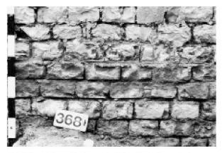
Abb. 6: Augst, Theater. Nordwange des Südost-Vomitoriums mit pietra rasaähnlicher Wandbehandlung und rot ausgezogenem Fugenstrich. Der Ausschnitt stammt aus der Zone des antiken Bodenniveaus, das mit der Unterkante des Fugenstrichs (Bildmitte) korrespondiert.
