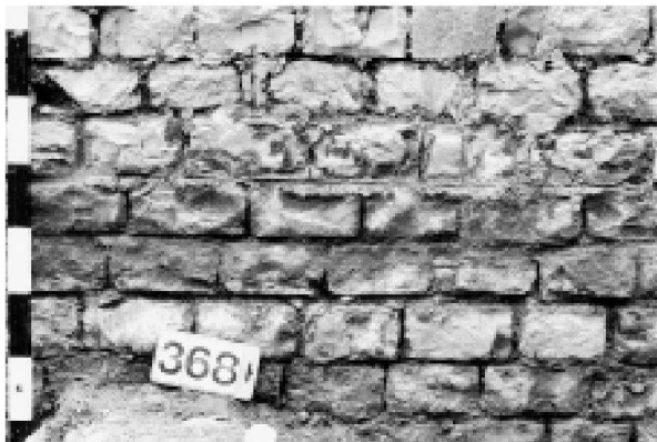
Abb. 6: Augst, Theater. Nordwange des Südost-Vomitoriums mit pietra-rasa-ähnlicher Wandbehandlung und rot ausgezogenem Fugenstrich. Der Ausschnitt stammt aus der Zone des antiken Bodenniveaus, das mit der Unterkante des Fugenstrichs (Bildmitte) korrespondiert.
