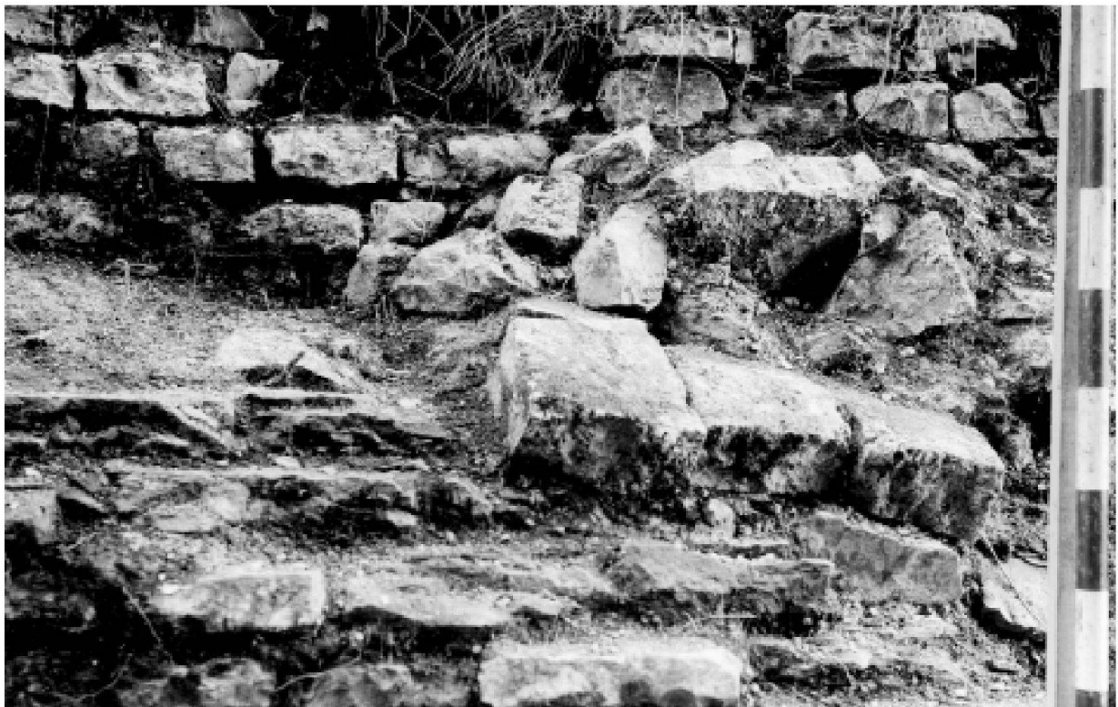
Abb. 10: Augst, Theater. Südost-Vomitorium, Südwanne mit ansteigendem Gewölbeauflager des Tuffsteingewölbes, Detail zu Abb. 11, Zustand nach der Freilegung 1939. Reste von drei Tuffkeilsteinen der Anfängerreihe in situ. Die plattigen Kalksteine des Kämpfers sind grösstenteils weggebrochen. Im Hintergrund das Haupt der Widerlagermauer. Die Kalkbruchsteine zwischen dem Widerlager und den Tuffkeilen gehören zur Kalksteinfüllung, die zur Verstärkung der Auflast über den Bogenschenkeln eingebracht worden ist.
