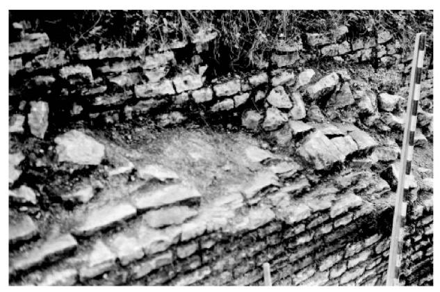
Abb. 9: Augst, Theater. Südost-Vomitorium, Südwange mit ansteigendem Gewölbeauflager des Tuffsteingewölbes, Zustand nach der Freilegung 1939. Im oberen Bildteil ist deutlich die getreppt ansteigende Widerlagermauer erkennbar. Davor, im Bereich der Mauerschale erodiert, der Bettungskeil für die Kämpferreihe. Links sind noch drei Tuffkeilsteine der Anfängerreihe zu erkennen (vgl. Abb. 10) sowie Reste der Kalksteinfüllung zur Verstärkung der Auflast über den Bogenschenkeln.
