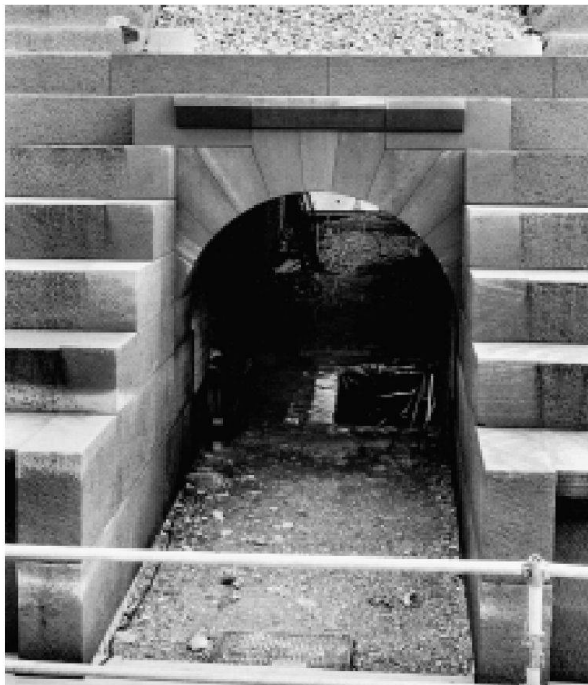
Abb. 5: Augst, Theater. Südost-Vomitorium, Mündungsbereich zur cavea. Im Jahr 2000 nach den neuesten Forschungsergebnissen errichtete Rekonstruktion des Werksteinbogens als Ersatz des schadhafte, 1940/41 durch Rudolf Laur-Belart rekonstruierten Bogens (ausgeführt von Steinmetz Gregor Bucher, unter Anleitung von Bildhauermeister Markus Horisberger).
