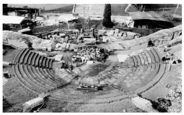
Abb. 27: Augst, Theatersanierung (Grabung 2001.55). Moderne Sitzstufenrekonstruktion. Blick vom zweiten Rang auf die fertiggestellte untere Hälfte der cavea. Deutlich erkennbar sind der Orchestraumgang und die Treppenläufe mit ihren auf der Auffüllung aufliegenden Betonfundamenten. Der Blick von oben lässt die Gitterkörbe vollständig verschwinden, so dass nur noch das geometrische Muster der Sandstein-Abdeckplatten sichtbar ist.
