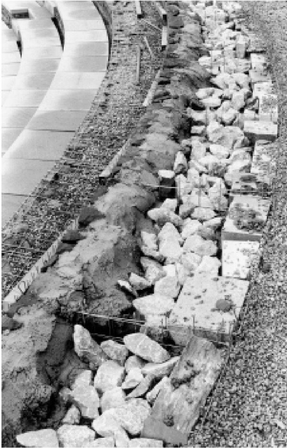
Abb. 23: Augst, Theatersanierung (Grabung 2001.55). Moderne Sitzstufenrekonstruktion. Die Rückseite der Stirnfüllung wird mit Mörtel verstrichen, um ein Ausschwemmen der Feinkomponenten in der Korbfüllung zu vermeiden. Danach wird die Kernfüllung aus Kalkbruchsteinen eingebracht.
