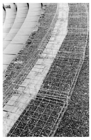
Abb. 17: Augst, Theatersanierung (Grabung 2001.55). Moderne Sitzstufenrekonstruktion. Versetzte Gitterkorbreihe. Gut erkennbar ist das Bodengitter mit 12,5 cm  $\times$  12,5 cm Raster. Unter den Körben ist das Ringfundament aus Zementsteinen und Beton zu sehen.
