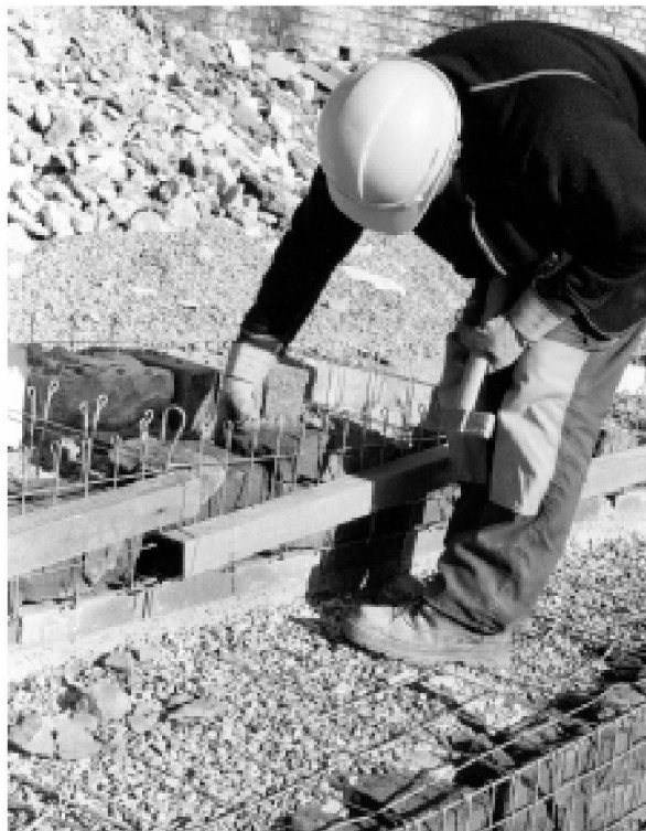
Abb. 21: Augst, Theatersanierung (Grabung 2001.55). Moderne Sitzstufenrekonstruktion. Aufsichten der Stirnfüllung aus roten Buntsandsteinschroppen. Um ein Ausbauchen der Gitterkörbe zu verhindern, wird während dieser Arbeitsphase die Stirnseite mit Holzbalken verstärkt.
