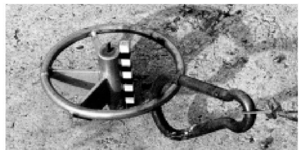
Abb. 19: Augst, Theatersanierung (Grabung 2001.55). Moderne Sitzstufenrekonstruktion. Einbetonierter Mittelpunkt mit Stahring zum Einhängen des Drahtseils für die Kontrolle der Diagonalmasse.
