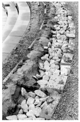
Abb. 23: Augst, Theatersanierung (Grabung 2001.55). Moderne Sitzstufenrekonstruktion. Die Rückseite der Stirnfüllung wird mit Mörtel verstrichen, um ein Ausschwemmen der Feinkomponenten in der Korbfüllung zu vermeiden. Danach wird die Kernfüllung aus Kalkbruchsteinen eingebracht.
