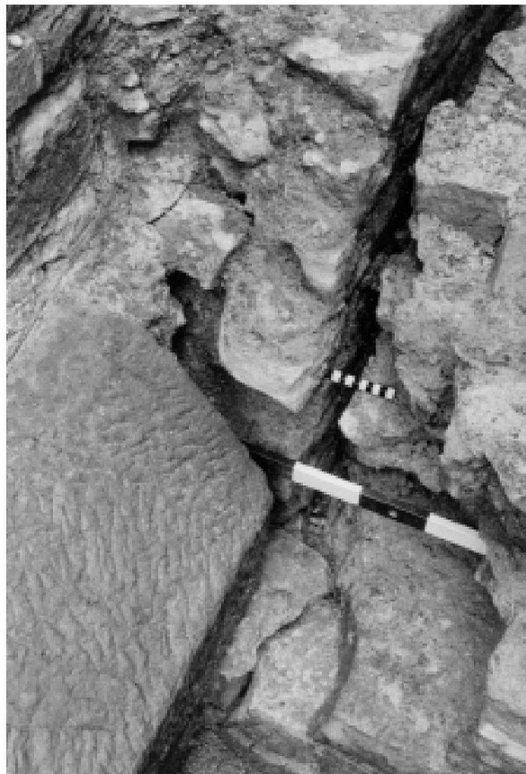
Abb. 33: Augst, Theatersanierung (Grabung 2001.55). Umfassung jüngerer szenisches Theater, Stützpfiler MR 195/Umfassung älteres szenisches Theater MR 59. Detail zu Abb. 31. Links Sandsteingurtquader des Stützpfilers MR 195 auf der Abbruchkante der Peripheriemauer des älteren szenischen Theaters MR 59 aufliegend. Rechts die gegen die äussere Mauerschale von MR 59 gebaute Hangstützmauer MR 337, die beim Versetzen des Gurtquaders ausgebrochen worden ist.
