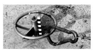
Abb. 19: Augst, Theatersanierung (Grabung 2001.55). Moderne Sitzstufenrekonstruktion. Einbetonierter Mittelpunkt mit Stahlring zum Einhängen des Drahtseils für die Kontrolle der Diagonalmasse.
