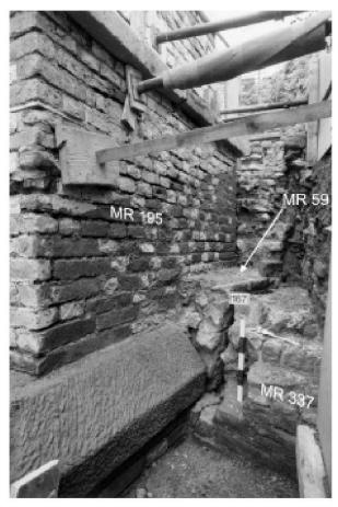
Abb. 31: Augst, Theatersanierung (Grabung 2001.55). Umfassung jüngeres szenisches Theater, Stützpfeiler MR 195/Umfassung älteres szenisches Theater MR 59. Mauerbefund in den Feldern 167 und 168 von Südwesten. Der Stützpfeiler MR 195 setzt auf der gegen Westen abfallenden Abbruchkrone von MR 59 auf.
