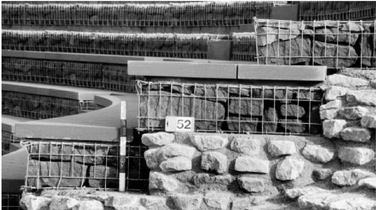
Abb. 15: Augst, Theatersanierung (Grabung 2001.55). Moderne Sitzstufenrekonstruktion. Fertiggestellte Stufen mit Gitterkörben, Sandsteinfüllung und Abdeckplatten aus Buntsandstein. Sichtbare Seitenflächen am Westende des Sitzstufeneinbaus.
