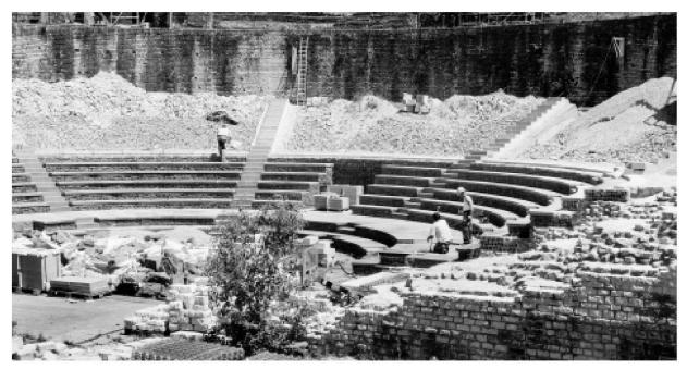
Abb. 26: Augst, Theatersanierung (Grabung 2001.55). Moderne Sitzstufenrekonstruktion. Blick von Südwesten auf das fertiggestellte unterste Drittel mit der nachgewiesenen Nische im Zentrum (vgl. Abb. 13). Die Fernwirkung lässt die Gitterkörbe zurücktreten und gibt Raum für eine Licht- und Schattenwirkung, die den Horizontalverlauf der Sitzstufenreihen unterstreicht. Im Bereich der Auffüllung sind die Betonfundamente für die Treppenläufe deutlich erkennbar.
