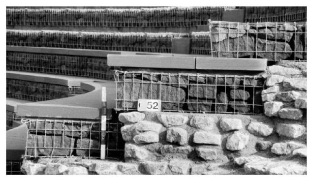
Abb. 15: Augst, Theatersanierung (Grabung 2001.55). Moderne Sitzstufenrekonstruktion. Fertiggestellte Stufen mit Gitterkörben, Sandsteinfüllung und Abdeckplatten aus Buntsandstein. Sichtbare Seitenflächen am Westende des Sitzstufeneinbaus.
