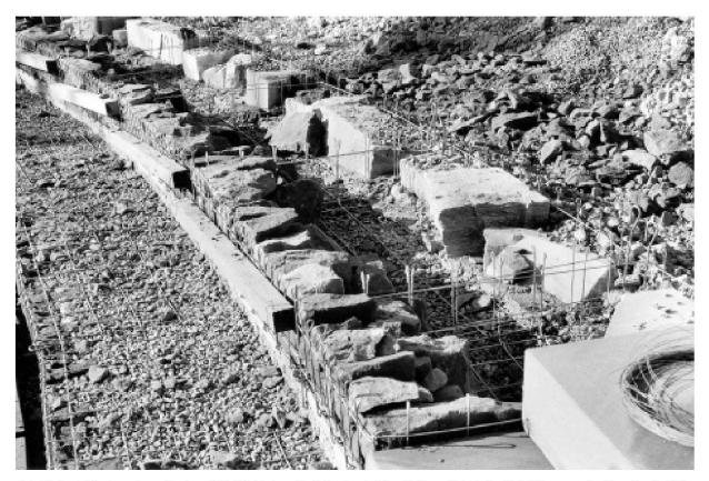
Abb. 22: Augst, Theatersanierung (Grabung 2001.55). Moderne Sitzstufernekonstruktion. Fertig geschichtete Sandsteinfüllungen an den Stirnseiten der Körbe. Die festgebundenen Holzbalken verhindern ein Ausbauchen der Gitterkörbe während den Füllarbeiten.
