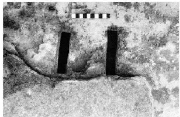
Abb. 7: Augst, Theatersanierung (Grabung 2001.55). Sitzstufenquader aus Buntsandstein des jüngeren szenischen Theaters. Ausschnitt der Oberfläche mit doppeltem Wolfsloch.
