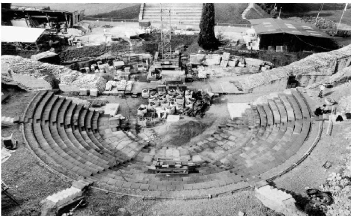
Abb. 27: Augst, Theatersanierung (Grabung 2001.55). Moderne Sitzstufenrekonstruktion. Blick vom zweiten Rang auf die fertiggestellte untere Hälfte der cavea. Deutlich erkennbar sind der Orchestraengang und die Treppenläufe mit ihren auf der Auffüllung aufliegenden Betonfundamenten. Der Blick von oben lässt die Gitterkörbe vollständig verschwinden, so dass nur noch das geometrische Muster der Sandstein-Abdeckplatten sichtbar ist.
