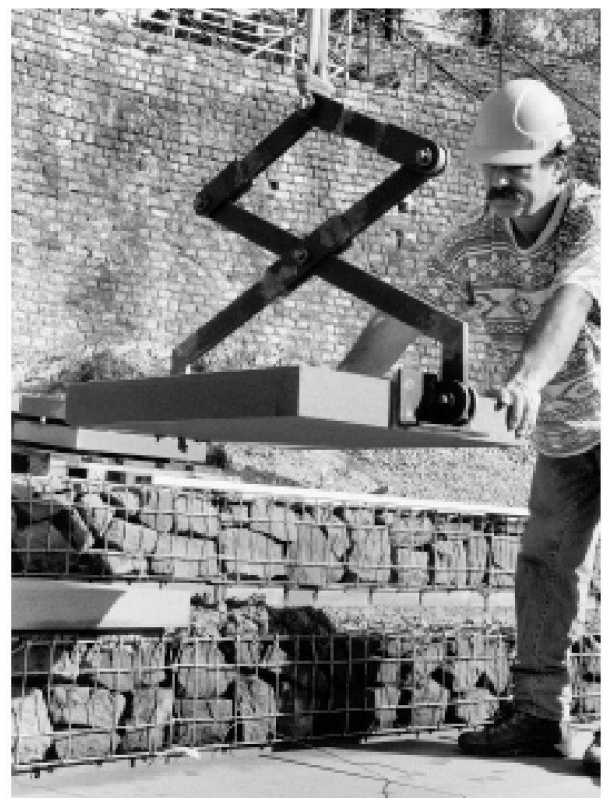
Abb. 24: Augst, Theatersanierung (Grabung 2001.55). Moderne Sitzstufenrekonstruktion. Einsetzen und Verschliessen des Deckels und Auffüllen des Korbs mit Granitschotter und -splitt.
