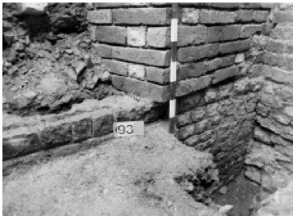
Abb. 32: Augst, Theatersanierung (Grabung 2001.55). Umfassung jüngerer szenisches Theater, Stützpfiler MR 195/Umfassung älteres szenisches Theater MR 59. Freigelegter Mauerbefund in den Feldern 167 und 168 von Südwesten. Oben im Bild die Südecke des Stützpfilers MR 195, die auf der Abbruchkante der Peripheriemauer des älteren szenischen Theaters MR 59 aufliegt, rechts die Hangstützmauer MR 337.
