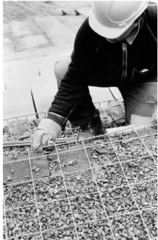
Abb. 24: Augst, Theatersanierung (Grabung 2001.55). Moderne Sitzstufenrekonstruktion. Einsetzen und Verschliessen des Deckels und Auffüllen des Korbs mit Granitschotter und -splitt.
