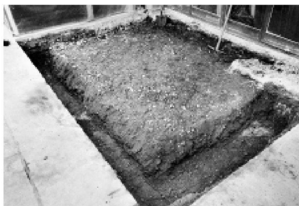
Abb. 5: Kaiseraugst AG, Bernhard Natterer, Wintergarten Gewerbepark, Landstrasse (Baubegleitung 2001.11). Blick von Südosten auf den Fundamentaus­hub mit den angeschnittenen Portikusmauern zur Raetiastrasse.
