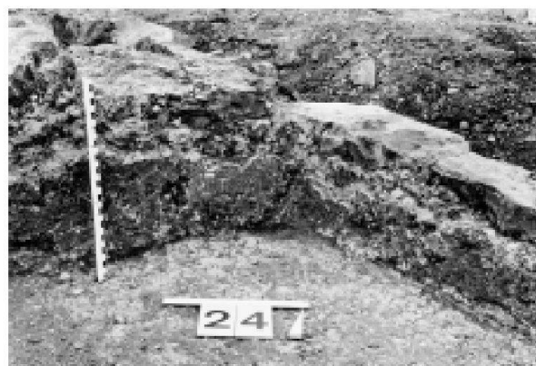
Abb. 22: Kaiseraugst AG, Graber-Hubschmid Hans und Margrit, Einfamilienhausprojekt, Äussere Reben (Grabung 2001.08). Blick von Süden auf die Mauerecke MR 4/MR 5 mit zweilagigem Wandverputz.
