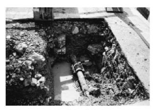
Abb. 31: Augst BL, Region 10,B (Grabung 2001.57). Dieses Jahr in Augst ein häufiges Bild! – Wasserleitung mit Reparaturmuffe, hier in der Poststrasse. An der Schmalkante des Grabens, über dem Wasser, die von Süden heranlaufende Innenunterteilung, rechts die West-Ost verlaufende Aussenmauer eines neuzeitlichen Gebäudes, das bei der Erweiterung der Poststrasse abgebrachen worden war. Van Norden
