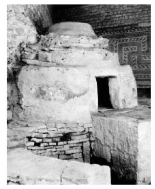
Abb. 35: Augst, Gebäude zwischen der Insula 9 und dem Theater. Konservierung des Backofens in der «Taberne» (2001.907). Die vielen kleinen Löcher der Wespennester sind im Kranz und in der Ofenkuppel gut erkennbar.
