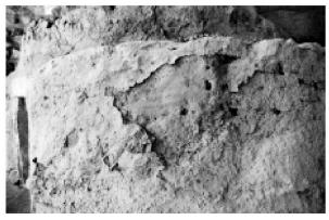
Abb. 36: Augst, Gebäude zwischen der Insula 9 und dem Theater. Konservierung des Backofens in der «Taberne» (2001.907). Das Konservierungsmittel Calaton hat sich gelöst; die Wespen verursachten Löcher in der römischen Lehmkonstruktion.
