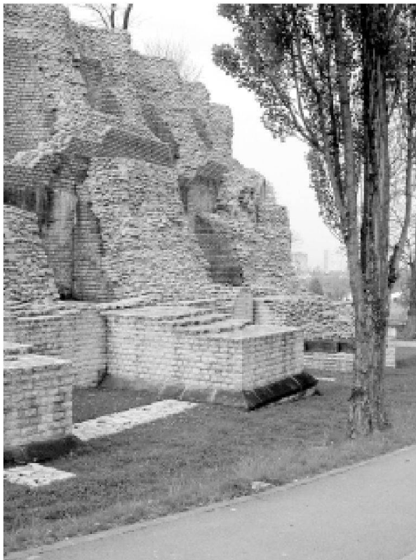
Abb. 39: Augst, Theatersanierung (2001.55). Im Bereich ausserhalb des Cavea-Keils 1, im Norden des Monuments an der Giebenacherstrasse, wird erstmals die vorgesehene Umgebungsgestaltung ersichtlich. Der Mauerverlauf des ersten Theaters ist bodeneben mit Bruchsteinen markiert (links im Vordergrund), die hier bereits fertig konservierte Ruine des 3. Theaters präsentiert sich monumental und für eine weitere Generation gesichert, und im Vorge-lände dominiert grüner Rasen, in dem die Schotterrasen-Fusswege kaum merkbar integriert sind. Vorne rechts der asphaltierte Gehsteig der Gieben-acherstrasse.
