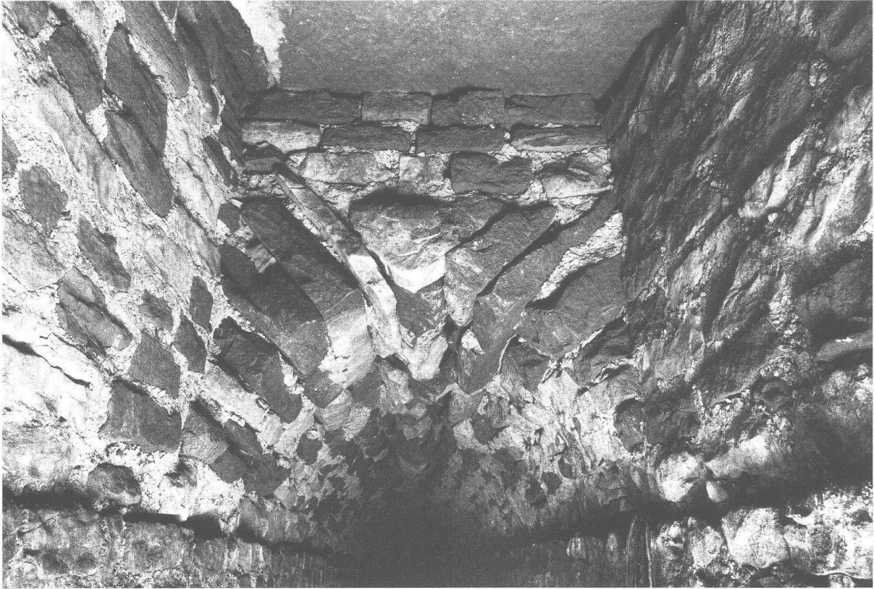
Abb. 3: Augst, Theatersanierung (Grabung 2000.55). Nordabschnitt des Abwasserkanals. Blick in den Einstiegschacht des älteren Gewölbeabschnitts. Der Aufbau des Gewölbes aus radial gestellten Sandsteinquadern und einem Schlussstein von dreieckiger Form ist sehr gut erkennbar. Am oberen Bildrand die originale Deckelplatte aus Buntsandstein.
