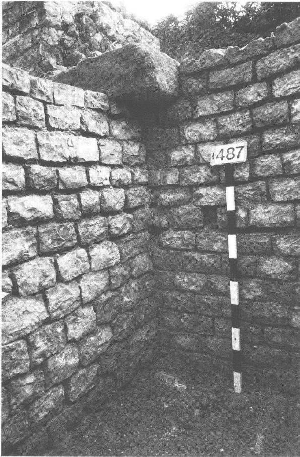
Abb. 12: Augst, Theatersanierung (Grabung 2000.55). Eingangsbereich des Südost-Vomitoriums, Feld 163 (vgl. Abb. 11). Blick von Westen. Rechts die Umfassungsmauer MR 58, links die stumpf anstossende Quermauer MR 331. Im Mauerwinkel unter dem Sandsteinquader in MR 58 ist der Ansatz der Reparatur MR 336 erkennbar.
