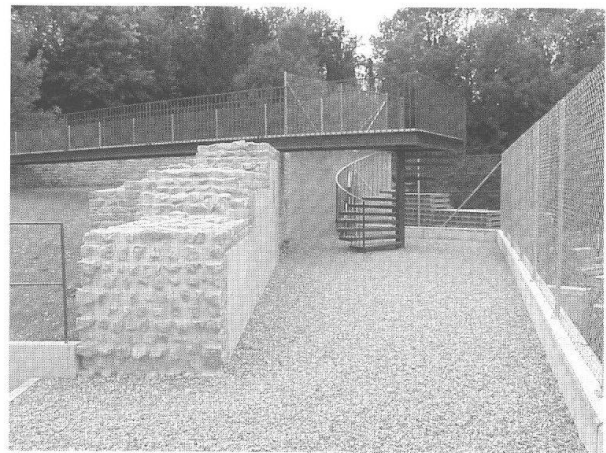
Abb. 39: August, Violenried, ehemaliges E. Frey-Areal (Grabung 2000.60, Konservierung 2000.925). Teilrekonstruktion der nördlichen Hangstützmauer mit Wendeltreppe. Der Zaun rechts steht auf einer neuen hohen Betonstützmauer, die das Gelände bis zur Sohle der ehemaligen Kastelen-Kiesgrube (rechts und hinten) abfängt.
