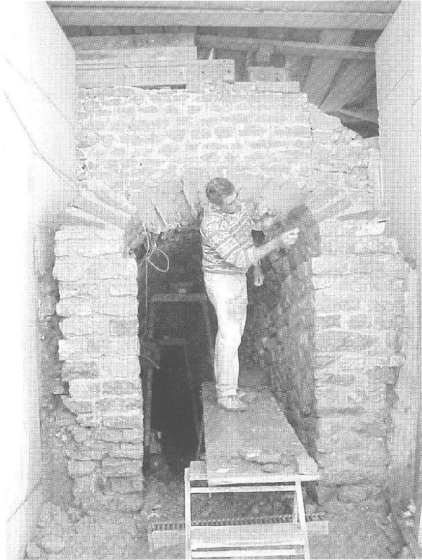
Abb. 42: Augst, Violenried, ehemaliges E. Frey-Areal (Grabung 2000.60, Konservierung 2000.925). Teilrekonstruktion des Eingangsportals zum unterirdischen Brunnenhaus.
