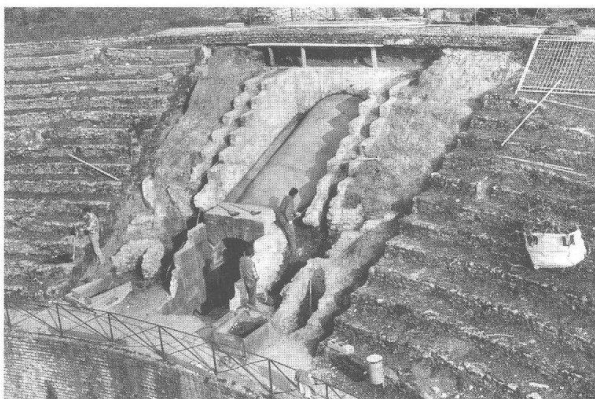
Abb. 36: Augst, Theatersanierung (Grabung 1999.55). Westteil des Südostvomitoriums (Abb. 1,B), Betongewölbe, während den Freilegungsarbeiten.
