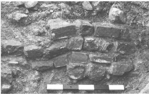
Abb. 28: Augst, Theatersanierung (Grabung 1999.55). Südliche Flügelmauern des Ersten Theaters. Verstärktes Mauerstück von Abb. 25. Ansicht an die oben liegende Mauerchale mit Resten von pietra rasa -Verstrich und sorgfältig angebrachtem Fugenstrich. Die Schale besteht vorwiegend aus Buntsandstein-Handquadern und Mauerquäderchen, die aus einem äusserst dichten, sehr regelmässig brechenden Kalkstein gefertigt sind.
