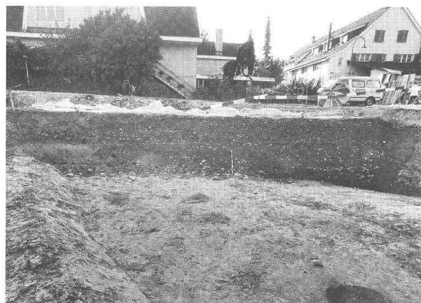
Abb. 26: Kaiseraugst AG, Hans Bolinger AG, Überbauung Allmendgasse/Heidemurweg (Grabung 1999.08). Blick von Osten auf den Grabungsrand West mit diversen humosen Schichten.
