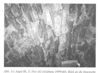
Abb. 11: Augst BL, E. Frey AG (Grabing 1999.60). Blick an die Innenseite der Tunneldecke. Im Westteil der Tunneldecke wurden als Schlusssteine des Gewölbes Tuffstein-Platten eingefügt (in Bildmitte). Blick von Westen gegen den Tunnelausgang.
