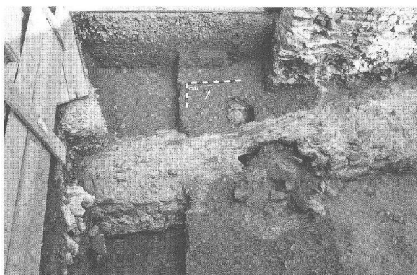
Abb. 6: Augst BL, E. Frey AG (Grabung 1999.60). Nach dem vollständigen Abbau der Schichten in Zone 3 liegt die Oberseite des Tunnels frei. In der Bildmitte die beiden Einbruchstellen und das mittig frei schwebend erhaltene Steinband des Tunnelgewölbes. Ganz links die untersten Steine des Brunnenschachtes. Von Süden und oben.
