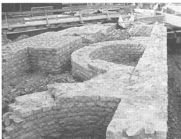
Abb. 1: Augst, neu erworbenes Ruinengelände beim Werkhof der Firma E. Frey AG (Grabung 1997.60/1998.60/1999.60). Die fertig konservierte, jüngere Hangstützmauer 3 (vgl. Abb. 40). Links im Hintergrund ist die ältere Stützmauer mit den Strebepfeilern erkennbar. Das römische Bad und das unterirdische, überwölbte Brunnenhaus liegen rechts ausserhalb des Bildausschnittes (vgl. unten, Abb. 38–42).
