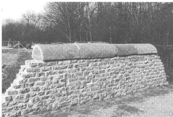
Abb. 43: Augst, Osttorareal (Grabung 1998, S. 6). Dieser Mauerabschnitt (MR 1) veranschaulicht heute die einstige Umfassung des monumentalen Grabrundbaus vor dem Osttor von Augusta Raurica. Die Teilrekonstruktion ist in der vermuteten Brüstungshöhe ausgeführt. Von den vier halbzyklindrischen Abdecksteinen aus Buntsandstein sind die mittleren beiden Originale, zum Schutz flankiert von zwei nachgehauenen Elementen (von Ost).
