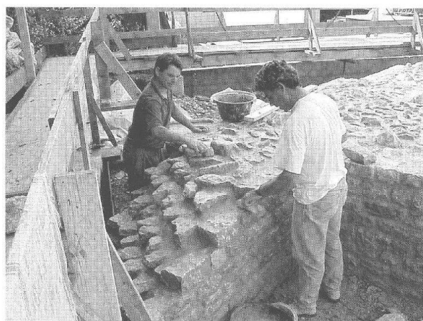
Abb. 41: Augst, E. Frey AG (Grabung 1997.60/1998.60/1999.60). Avelino und Antonio de Matos Cruz beim Konservieren der älteren Hangstützmauer 16 (Abb. 1; 38; 39, links). Rechts ist einer der Strebepeiler erkennbar (MR 24).
