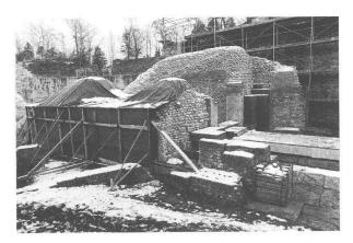
Abb. 49: Augst, Theatersanierung (Grabung 1998.55). Südaditus. Zustand nach Beendigung der Restaurierungsarbeiten von 1998. Die Westseite der äusseren Bühnenmauer 44 wurde über den Winter verpackt, um Frostschäden am neuen, noch nicht ganz ausgehärteten Fugenmörtel aus Luftkalk zu vermeiden.
