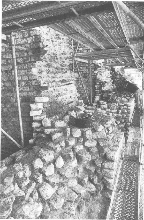
◀ Abb. 20: Augst, Theatersanierung (Grabung 1998.55). Die Mauerkrone der nördlichen Caveaabschlussmauer (MR 60) mit den Ansätzen der Entlastungsbogen während den Aufmauerungsarbeiten.
