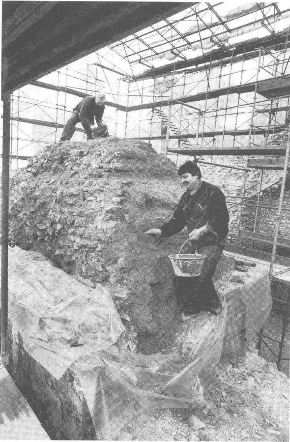
Abb. 44: Augst, Theatersanierung (Grabung 1998.55). Südaditus, Mauer 44. Auftrag der ersten fixierenden und deckenden Schicht aus hydraulischem Kalkmörtel.
