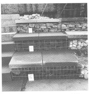
Abb. 53: Augst, Theatersanierung (Grabung 1998.55). Das definitiv ausgewählte System mit Abdeckplatten aus rotem Sandstein (Muster Nr. 5).
