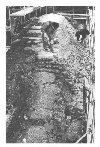
Abb. 38: Augst, Theatersanierung (Grabung 1998.55). Südaditus. Abbau der stark beschädigten modernen Übermauerungen von 1907 und 1936 auf der äusseren Bühnenmauer (MR 44).
