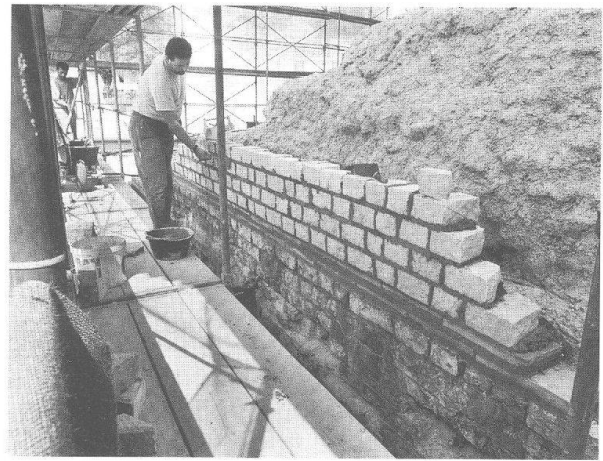
Abb. 46: Augst, Theatersanierung (Grabung 1998.55). Südaditus. Aufmauerung der westlichen Schale von Mauer 44 direkt oberhalb der römischen Reparatur (Abb. 3).
