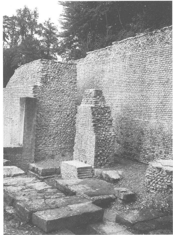
Abb. 32: Augst, Theatersanierung (Grabung 1936.59). Südaditus. Zeitgenössischer Blick auf die 1936 fertig restaurierte innere Bühnenmauer (MR 43) von Süden.
