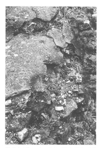
Abb. 36: Augst, Theatersanierung (Grabung 1994.55). Südaditus. Starke Frostschäden an der äusseren Bühnenmauer 44. Detail der Mauerkrone mit aufgebrochener und abgelöster Zementabdeckung von ca. 1907.
