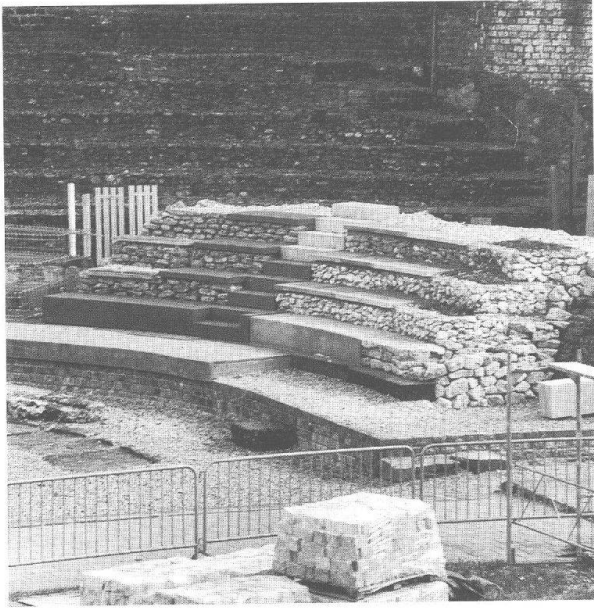
Abb. 52: Augst, Theatersanierung (Grabung 1997.55). Verschiedene Muster zur Gestaltung der Sitzstufen mit Drahtkörben (Abb. 1,C).
