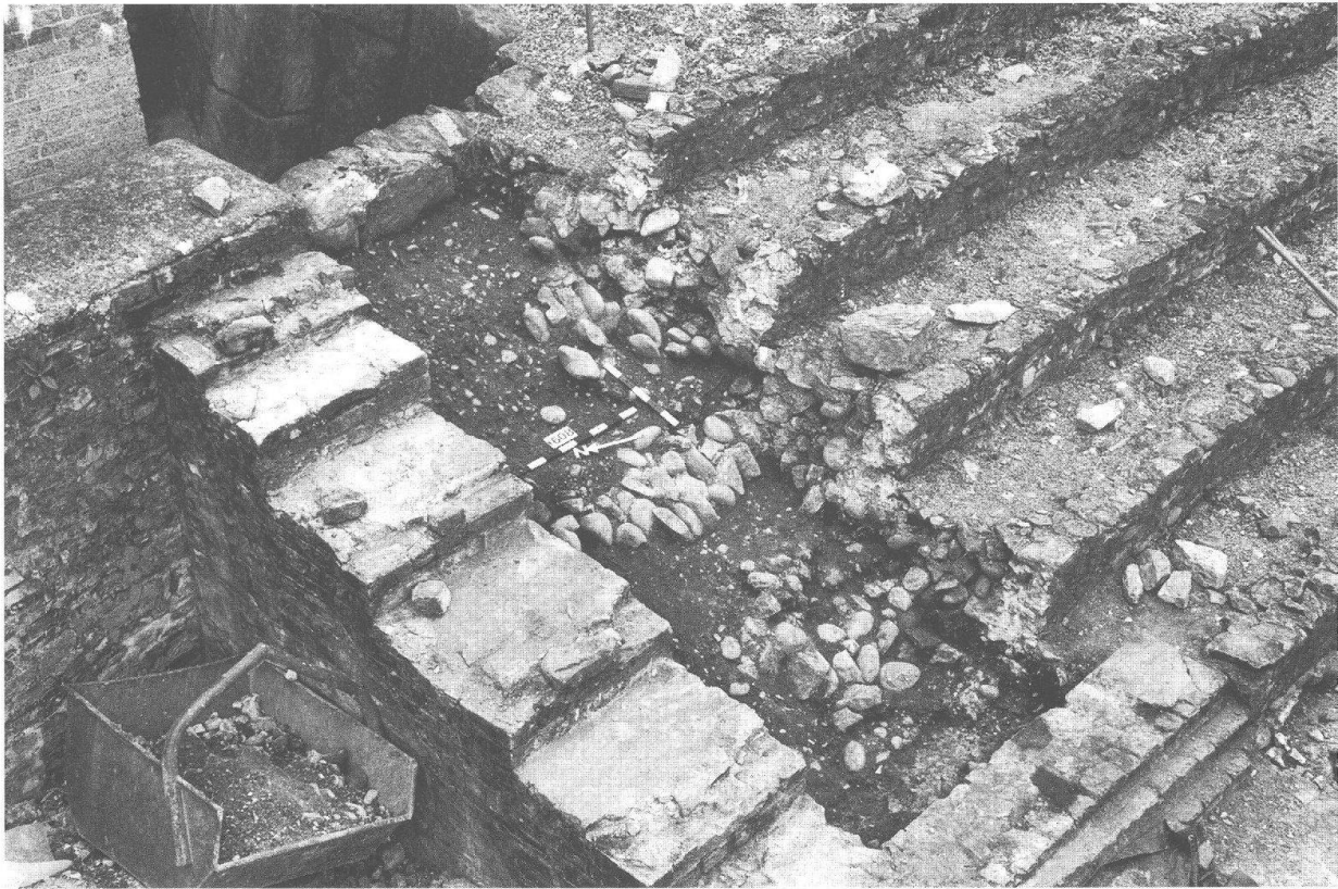
Abb. 11: Augst, Theatersanierung (Grabung 1998.55). Sitzstufen des Amphitheaters und Prohedrie des Ersten Theaters. Aufsicht auf die originalen, zum Teil stark erodierten Sitzstufenunterlagen des Amphitheaters (Abb. 1,3). Rechts davon die 1946 rekonstruierten Sitzstufen.
