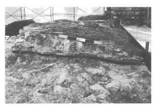
Abb. 39: Augst, Theatersanierung (Grabung 1998.55). Südaditus. Abbau der schadhaften modernen Übermauerung von 1936 auf der inneren Bühnenmauer 43. Die in der Bildmitte quer verlaufende, schwarze Linie ist eine 1936 angebrachte, jetzt unwirksam gewordene Isolationsschicht aus Asphalt gegen Regenwasser.
