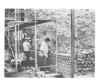
Abb. 45: Augst, Theatersanierung (Grabung 1998.55). Südaditus. Aufmauerung der östlichen Schale von Mauer 44.
