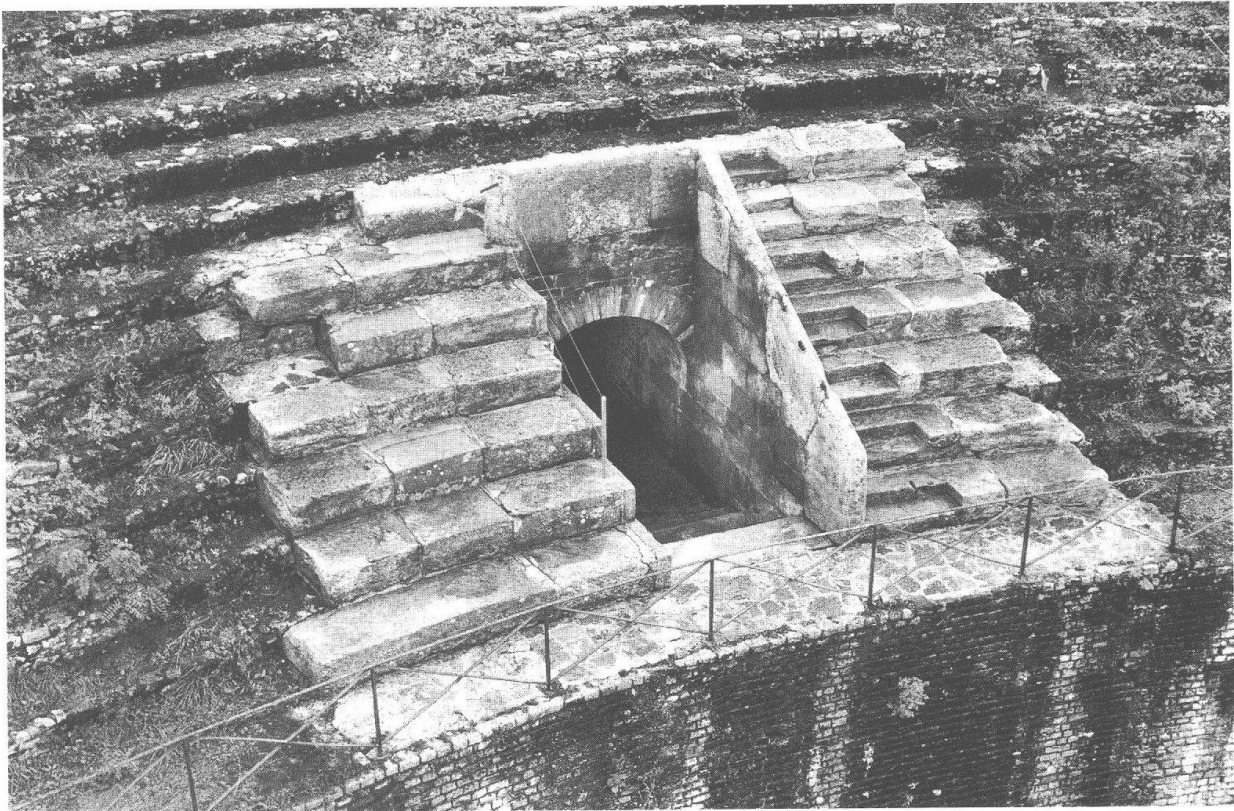
Abb. 25: Augst, Theatersanierung (Grabung 1998.55). Mündung des Südostvomitoriums in den Sitzstufenbereich. Rekonstruktion der Überwölbung von 1939/40 in Stahlbeton und mit sekundär verwendeten antiken Sandsteinquadern (Blick von Westen aus dem Krankorb).
