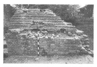
Abb. 35: Augst, Theatersanierung (Grabung 1997.55). Südaditus. Starke Frostschäden am südlichen Fenstergewände in der äusseren Bühnenmauer (MR 44). Die um 1907 als Witterungsschutz angebrachten Zementplomben haben sich vom originalen Mauerkern abgelöst.
