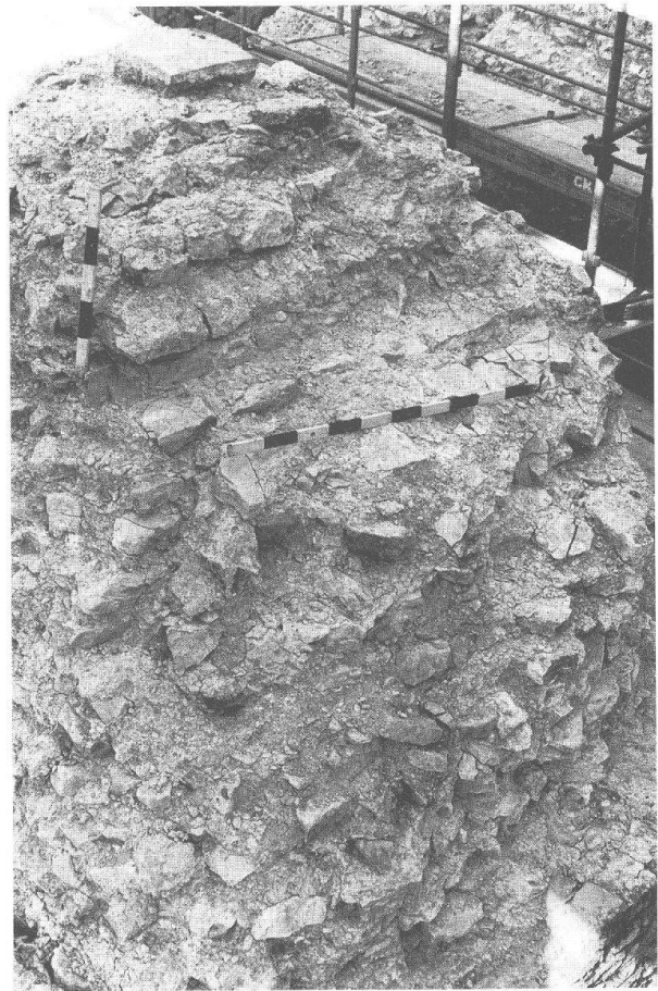
Abb. 4: Augst, Theatersanierung (Grabung 1998.55). Südaditus, westliche Bühnenmauer von Süden (MR 44). Nördliches Fenstergewände mit getreppt verlaufendem Widerlager des Fenstergewölbes. Vor dem unteren Teil der Abmauerung, wo der Massstab liegt, ist der Rest des Bettungskeiles für das Gewölbeauflager zu erkennen.
