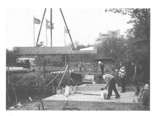
Abb. 14: Augst, Osttorareal (Grabung 1998.56), Befundzone 2 (Trakt für Esel und Futtervorräte). «Bauen über den Ruinen»: Das Verlegen der vorfabrizierten Fundamentplatten auf die Micropfähle und die vorbereitete Humusschicht (im Vordergrund und Abb. 13).
